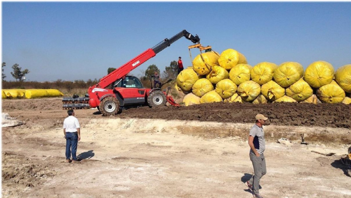
Figura 3.14 Relleno seco con pre-tratamiento y compactación. Tomado de (México, 2002)
