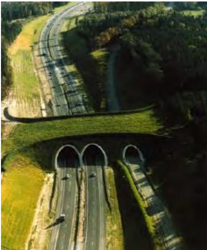
Paso Superior de Fauna con falsos túneles, Países Bajos.
