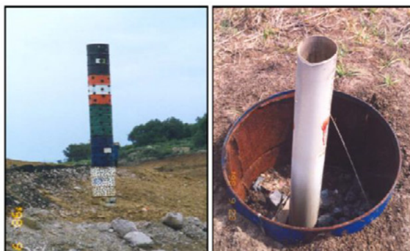
Figura 3.26 Ejemplo de pozos de venteo. Fuente: (SEDESOL, 2009)
