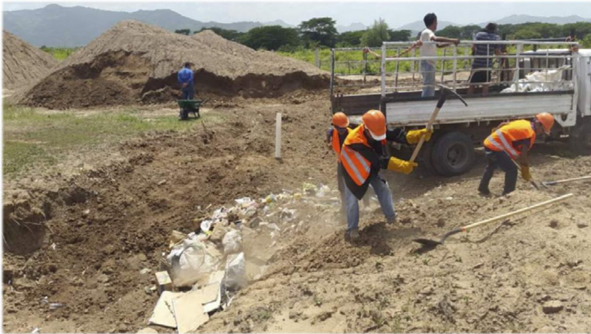
Figura 3.13 Relleno manual. Tomado de (El Herlado 2015)
