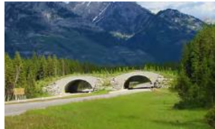
Paso Superior específico para Fauna. Puente Verde sobre la A20, Grevesmühlen, Alemania.
