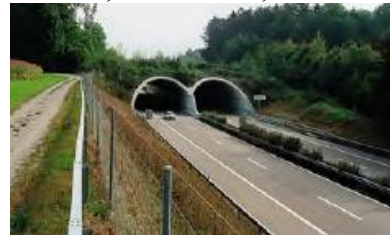
Cercado perimetral que conduce la Fauna hacia el Cruce Superior.
