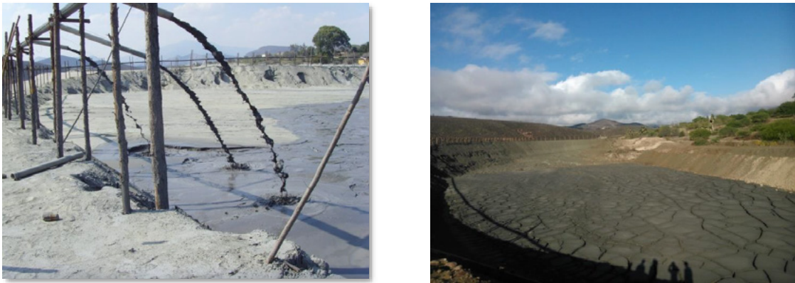
Figura 1.8 Los residuos minerales del proceso de flotación se conducen a la presa de jales, mostrada en ambas fotografías, por gravedad o mediante bomba centrífuga de lodos para su depósito y recuperación de una parte del agua que se utilizó en el proceso. Cortesía de Compañía Minera y Beneficiadora Purísima, S de R. L., Zimapán, Hidalgo.
