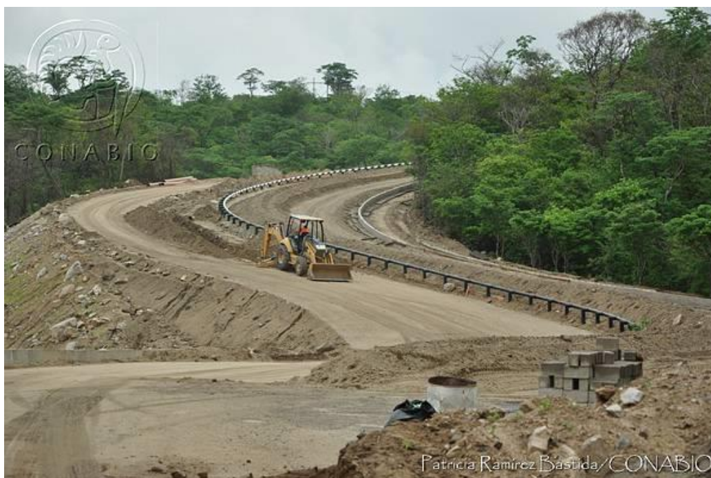
Foto 4.7. Eliminación de la cubierta vegetal para la construcción de la carretera Huatulco, Oaxaca. Fuente: Patricia Ramírez Bastida, Banco de imágenes CONABIO.
