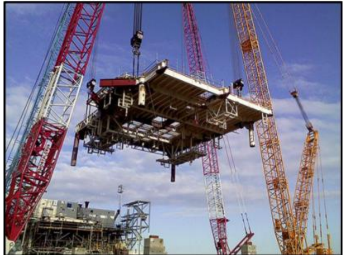
Imagen 23: “Trabajo de izaje en una pataforma marina” - http://ri.ujat.mx/bitstream/20.500.12107/2181/1/162-1796-A.pdf
