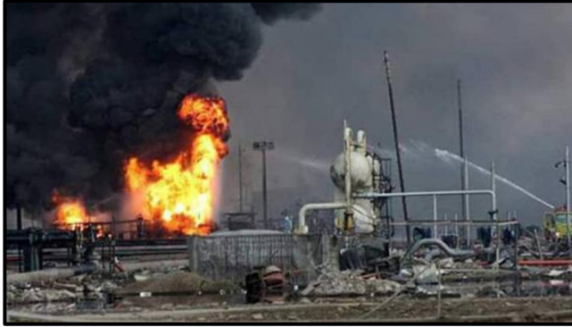
Imagen 14: "Explosión en planta Colorados 3 del Complejo petroquímico Pajaritos 2016" – La jornada.
