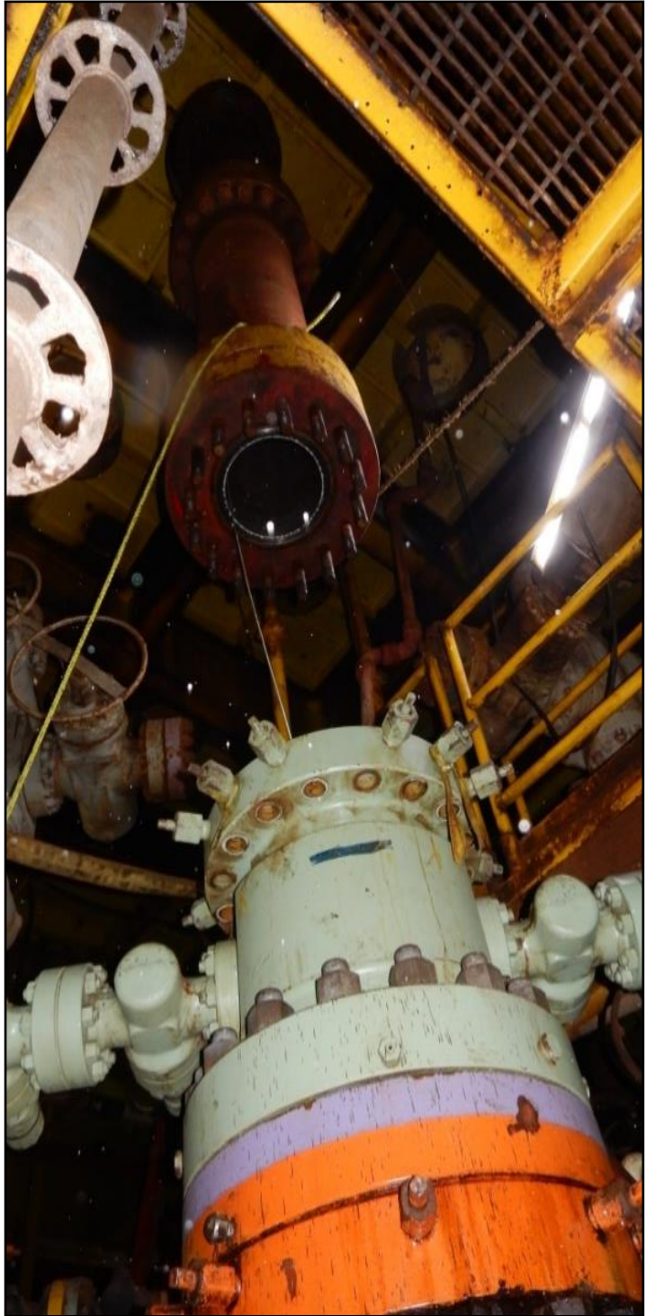
Imagen 30 Ensamble de carrete y cabezal por etapas, PEMEX 2020.
