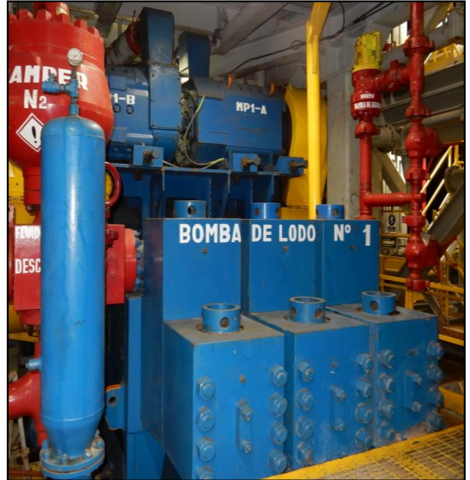
Imagen 15 Bomba de lodo, PEMEX 2020.
