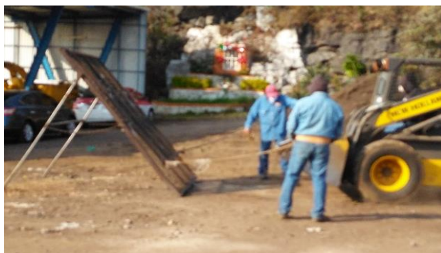
Figura 8. Funcionamiento de la cribadora [8]
