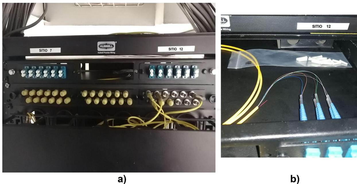
*Figura 3.19. Sitio 1 terminado. a) Distribuidor óptico conectorizado.
