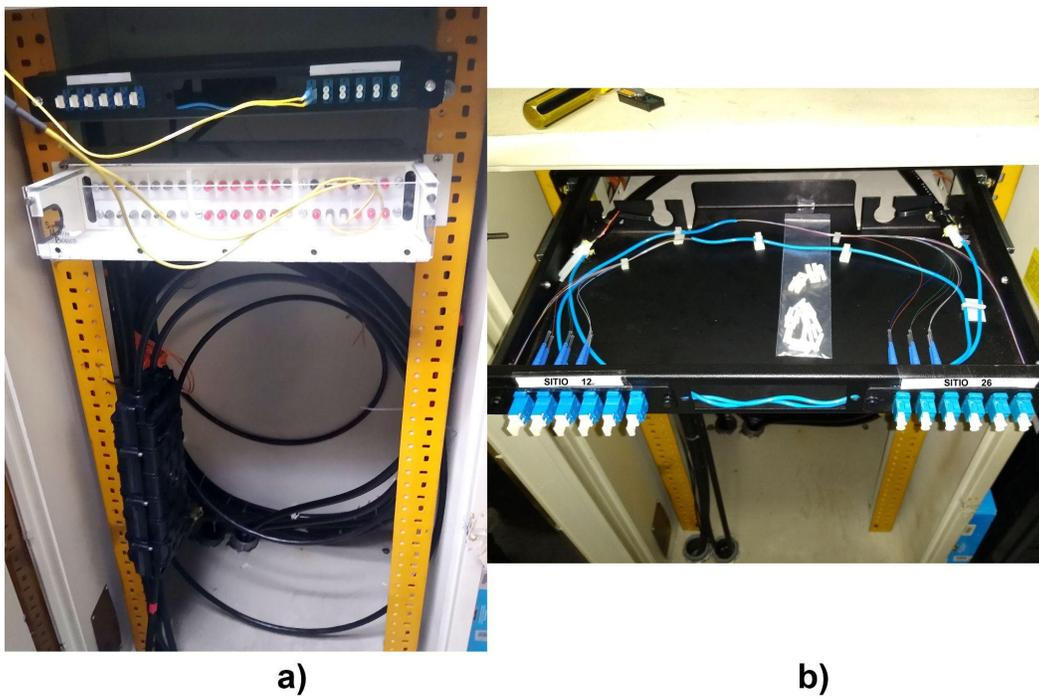
Figura 3.23. Sitio 25 terminado. a) Rack con distribuidor óptico conectorizado y caja de empalme. b) Interior de distribuidor óptico conectorizado.
