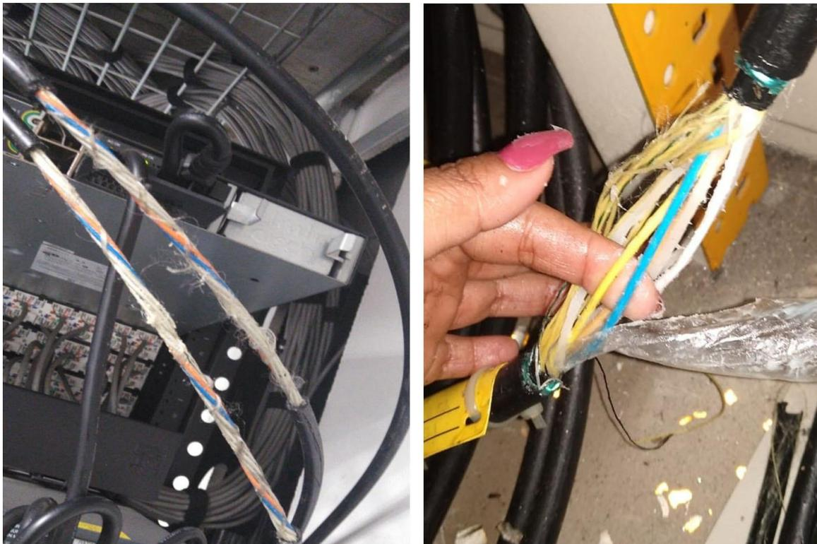
*Figura 3.8. Corte transversal realizado en los cables de fibra óptica del sitio 1 y 12.*
