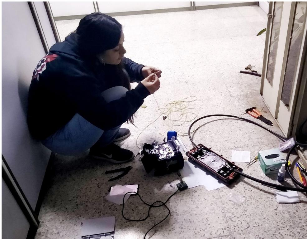
*Figura 3.15. Instalación de caja de empalme sitio 12.*
