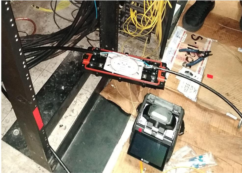
*Figura 3.14. Instalación de caja de empalme sitio 7.*
