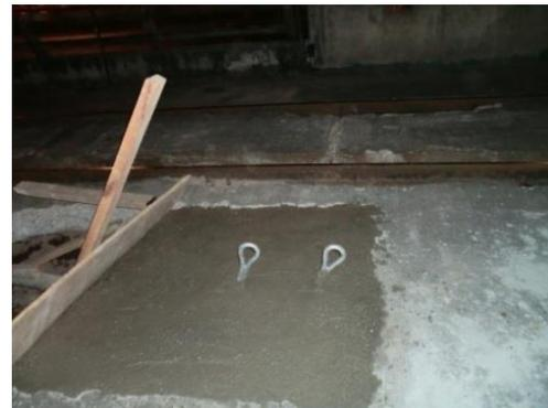
En el caso de cimentación de anclaje, los pernos se sustituirán por herrajes de anclaje adecuados a los tirantes de anclaje. El tipo de cimentación depende del tipo de poste a emplear y de las características y de la capacidad de carga del terreno, donde se realice la cimentación.
