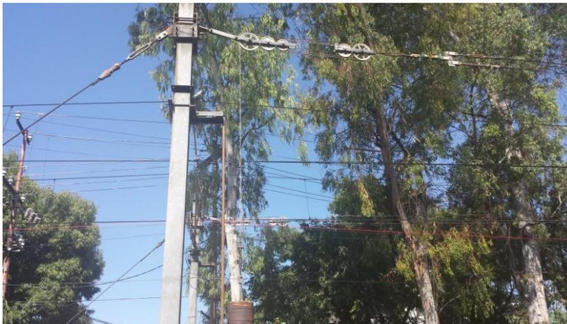
Sistema de poleas y contrapesos instalado en el segundo tramo de la línea del tren ligero de la Ciudad de México.
