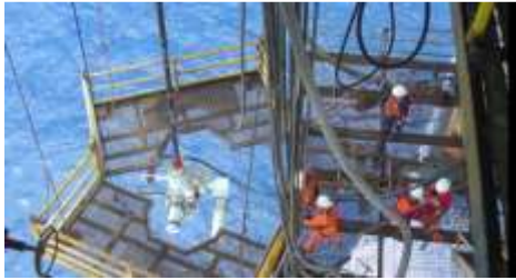
Figura 4.35 Secuencia de instalación submarina del XT
