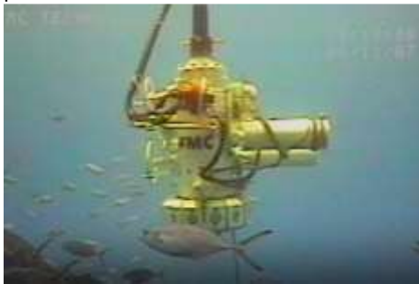
XT llegando al cabezal submarino para su instalación.
