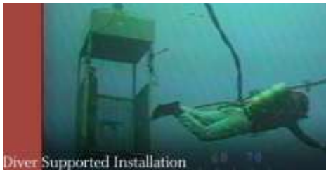
Buzo saliendo de su jaula para asistir en la instalación del XT.
