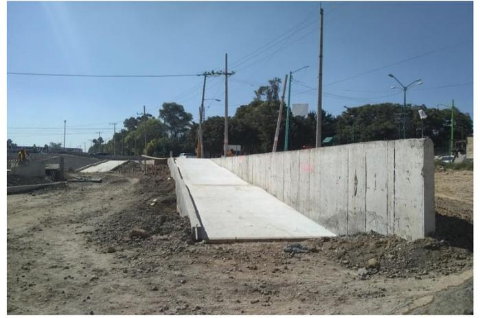
**Imagen 26.** Construcción de rampa tipo 1 en el área central del Parque Lineal. (Archivo Personal)
