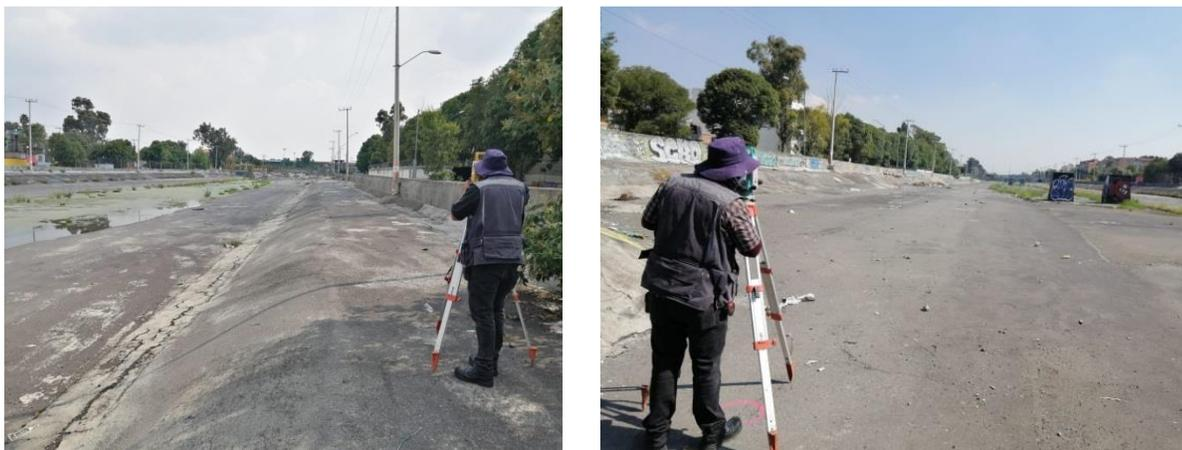
**Imagen 13.** Trazo y nivelación utilizando estación total. (Archivo Personal)
