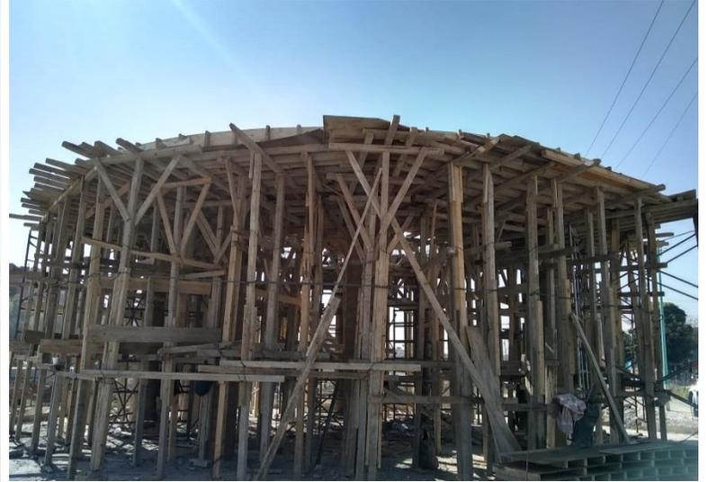
**Imagen 41.** Método de polinado para armado y suministro de concreto para la periferia de la trabe de concreto del Pabellón de la Tercera Edad. (Archivo Personal)
