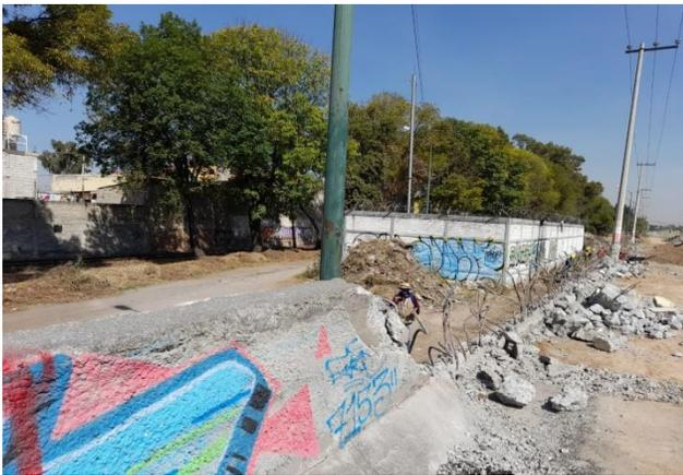
**Imagen 11.** Exposición de varillas de refuerzo del muro lateral (Archivo Personal)
