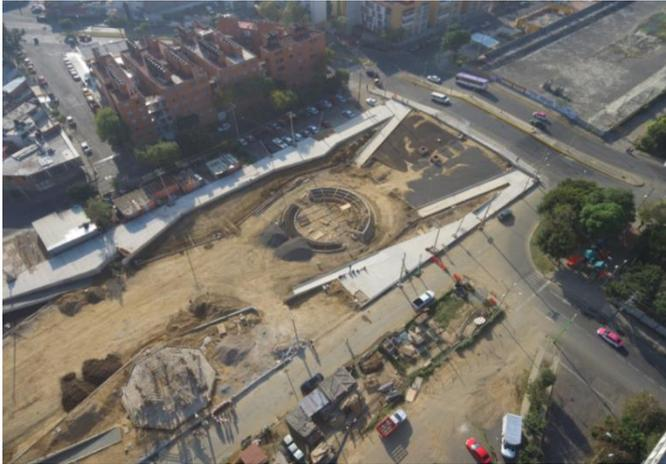
**Imagen 25.** Vista aérea de la conformación de terrazas y rampas del Parque Lineal Gran Canal. (Archivo Personal)
