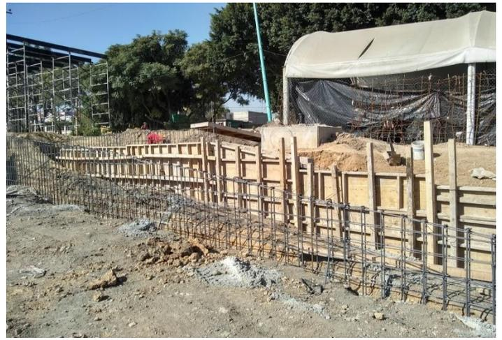
**Imagen 24.** Armado de acero de refuerzo y adaptación de cimbra para rampas de acceso. (Archivo Personal)
