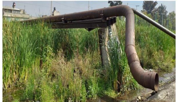
**Imagen 7.1.** Condiciones antes de intervenir el tramo Gran Canal donde se puede observar las condiciones en mal estado en uno de los puentes así como vegetación intrusiva. (Archivo Personal)
