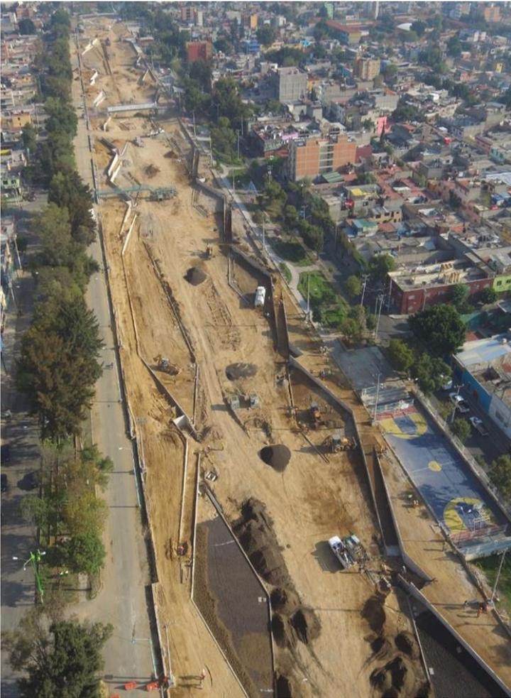
**Imagen 17.** Fotografía área de la conformación del terreno así como la construcción de terrazas, escaleras y rampas de acceso. (Archivo Personal)
