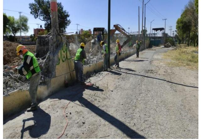
**Imagen 10.** Derrumbe de muros por medios manuales (Archivo Personal)
