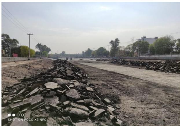
**Imagen 14.** Demolición de carpeta asfáltica por medios mecánicos (Archivo Personal)
