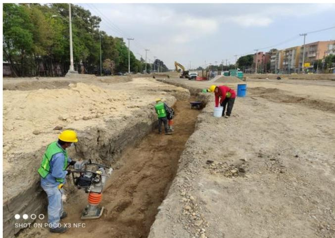
**Imagen 22.** Compactación de plantilla tepetate por medios mecánicos usando pisón neumático. (Archivo Personal)
