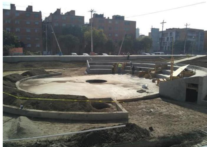
**Imagen 30.** Cimentación del escenario principal donde se observa la construcción de nicho para la instalación de fuente seca. (Archivo Personal)
