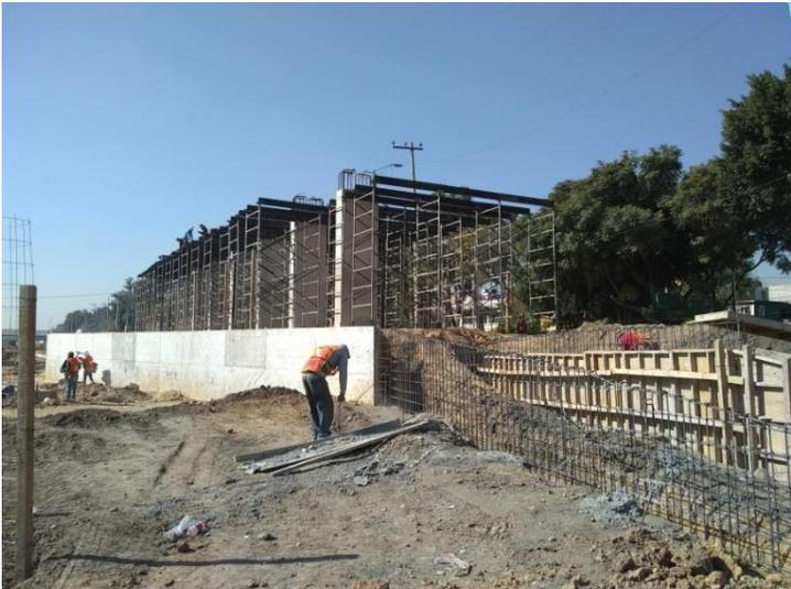
**Imagen 34.** Instalación de estructura metálica ligera para conformar la pérgola. (Archivo Personal)
