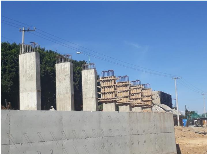
**Imagen 35.** Proceso de cimbrado de acabado aparente y descimbrado de elementos estructurales. (Archivo Personal)
