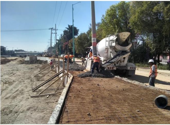
**Imagen 23.** Tendido de parrilla electrosoldada así como el suministro y colocación de concreto  $f'c$  200 kg/cm<sup>2</sup>. (Archivo Personal)
