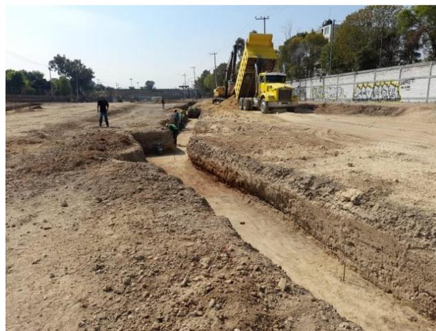
**Imagen 21.** Zanja divisoria de los muros de contención de las terrazas, en el fondo se observan góndolas para relleno de tepetate. (Archivo Personal)
