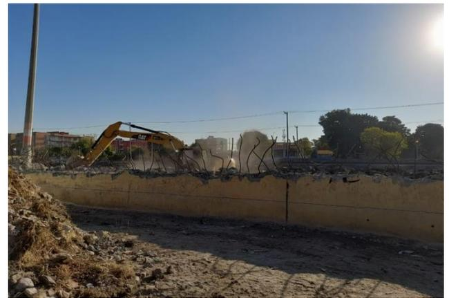
**Imagen 12.** Derrumbe de muros por retroexcavadora como medios mecánicos (Archivo Personal)
