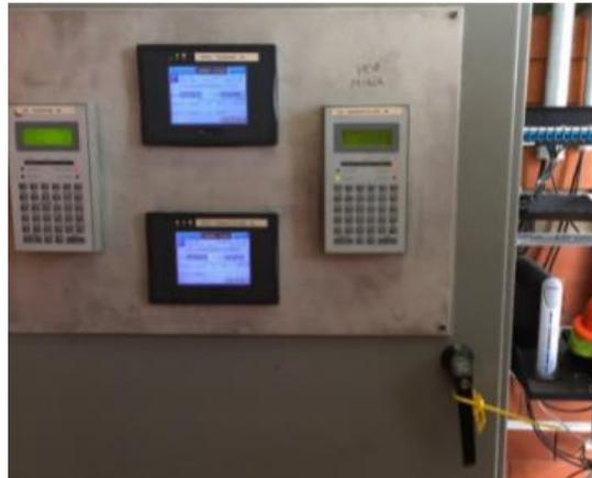
*Figura 9. Computador de flujo electrónico Fuente: Tomada en campo de trabajo, 2020.*
