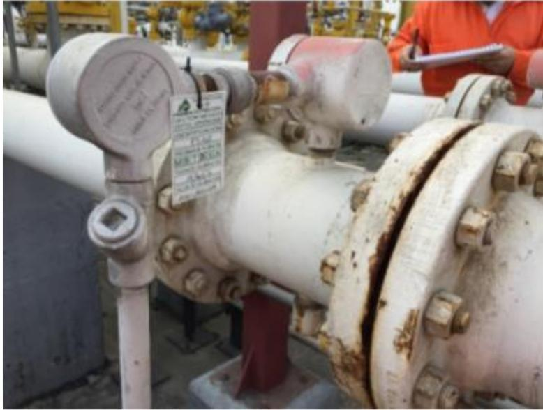
*Figura 12. Medidor Tipo Turbina en campo Fuente: Tomada en campo de trabajo, 2020.*
