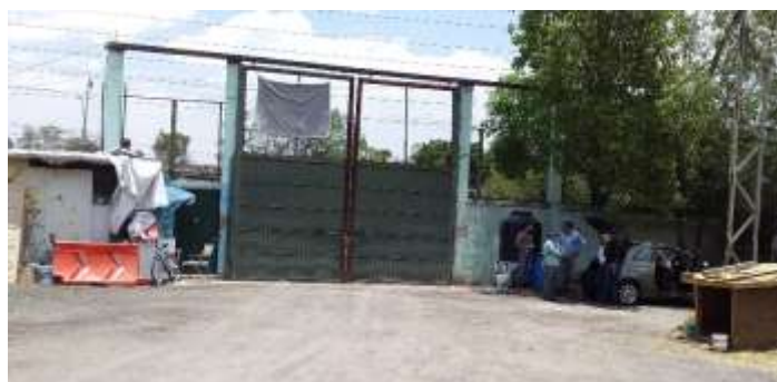
Fotografía 1. Puerta de acceso al predio CEDEC-Parque Bicentenario.
