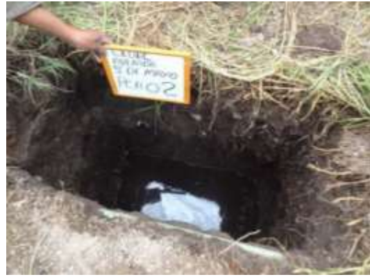
Fotografía 9. Pozo a cielo abierto PCA-2.
