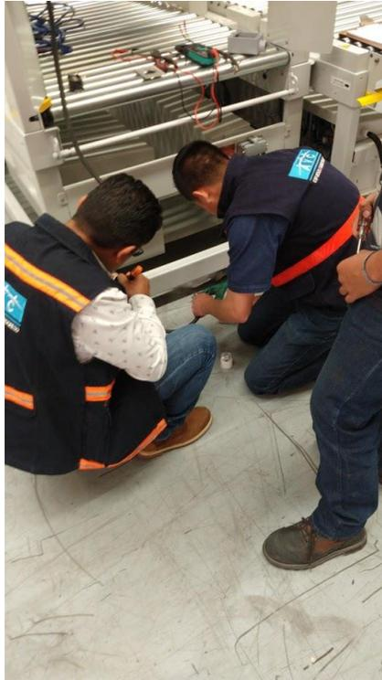
Figura 29. Proveedor de cableado eléctrico realizando el cambio de enchufe
