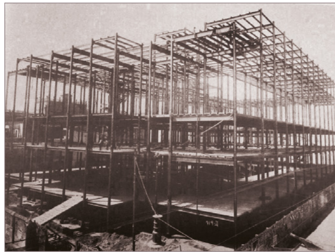
Estructura metálica del Palacio de Comunicaciones
