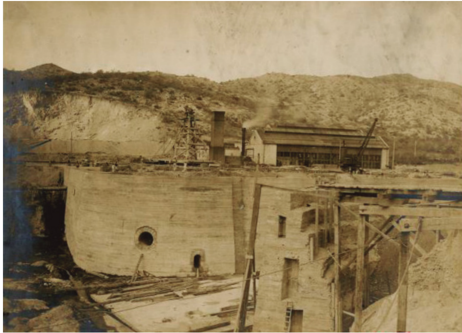
Construcción del dique seco de Salina Cruz
