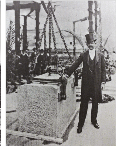
Ing. Militar Gonzalo Garita, director de las obras, al colocar la primera piedra
