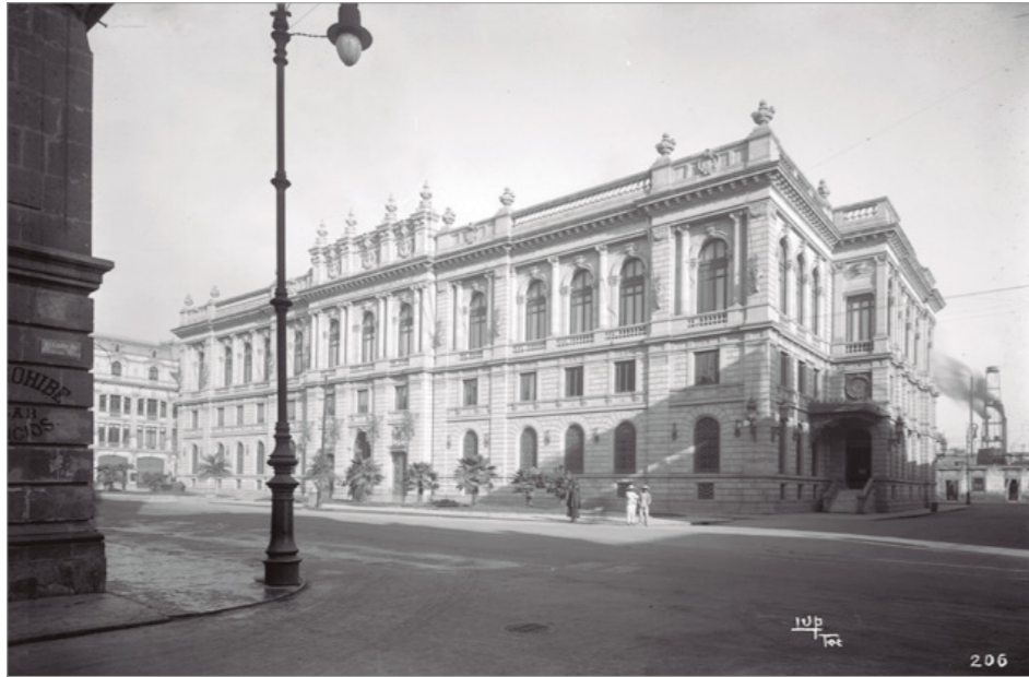
Edificio de la Secretaría de Comunicaciones y Obras Públicas diseñado por el arquitecto italiano Silvio Contri y en la dirección de las obras el ingeniero militar Gonzalo Garita © 122583 CONACULTA. INAH. SINAFO. FN. Fondo Casasola. México
