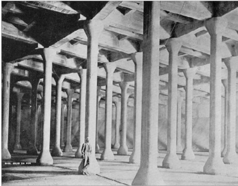
Foto de uno de los tanques de almacenamiento terminado
