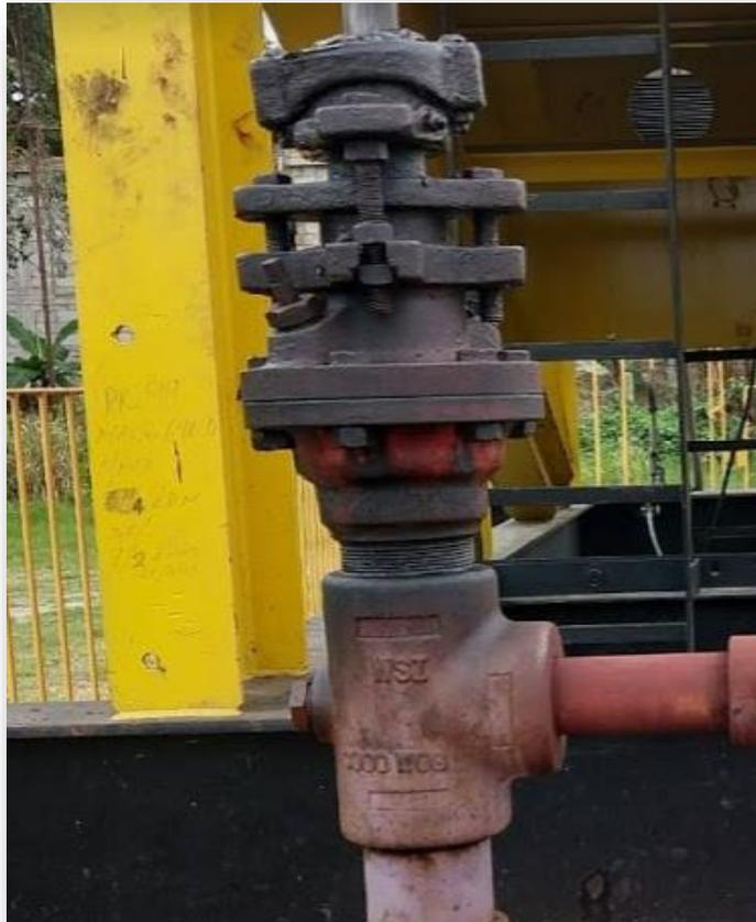
**Figura 28** Estopero instalado en campo
