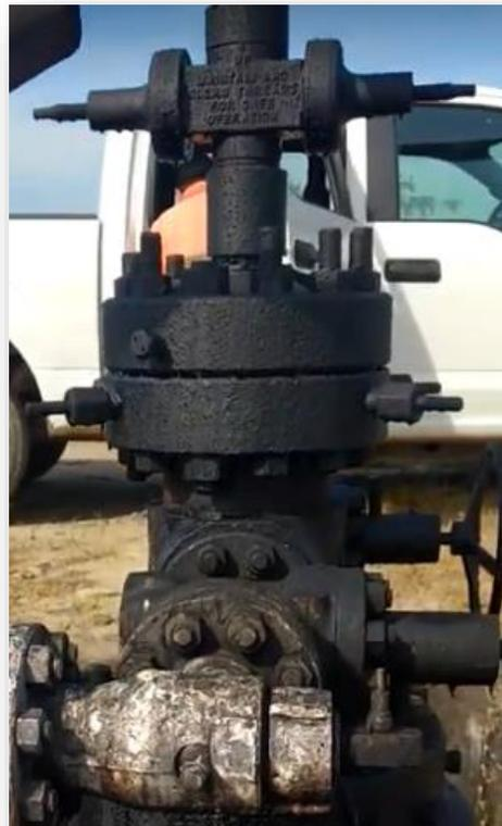
Figura 30 Preventor Instalado en Campo
