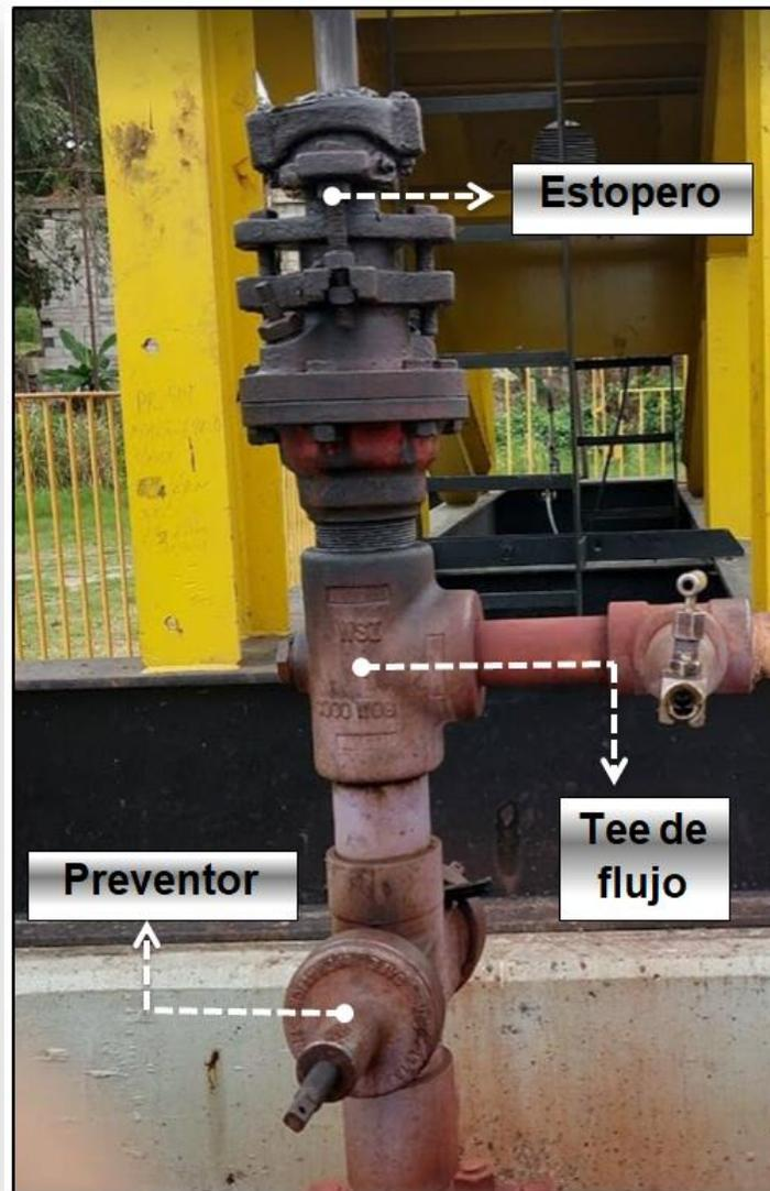
Figura 33 Tee de Flujo, Estopero y Preventor Instalados en Campo
