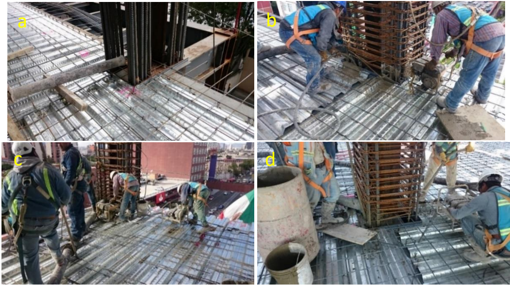
Figura 42. Proceso de colado de una columna.
