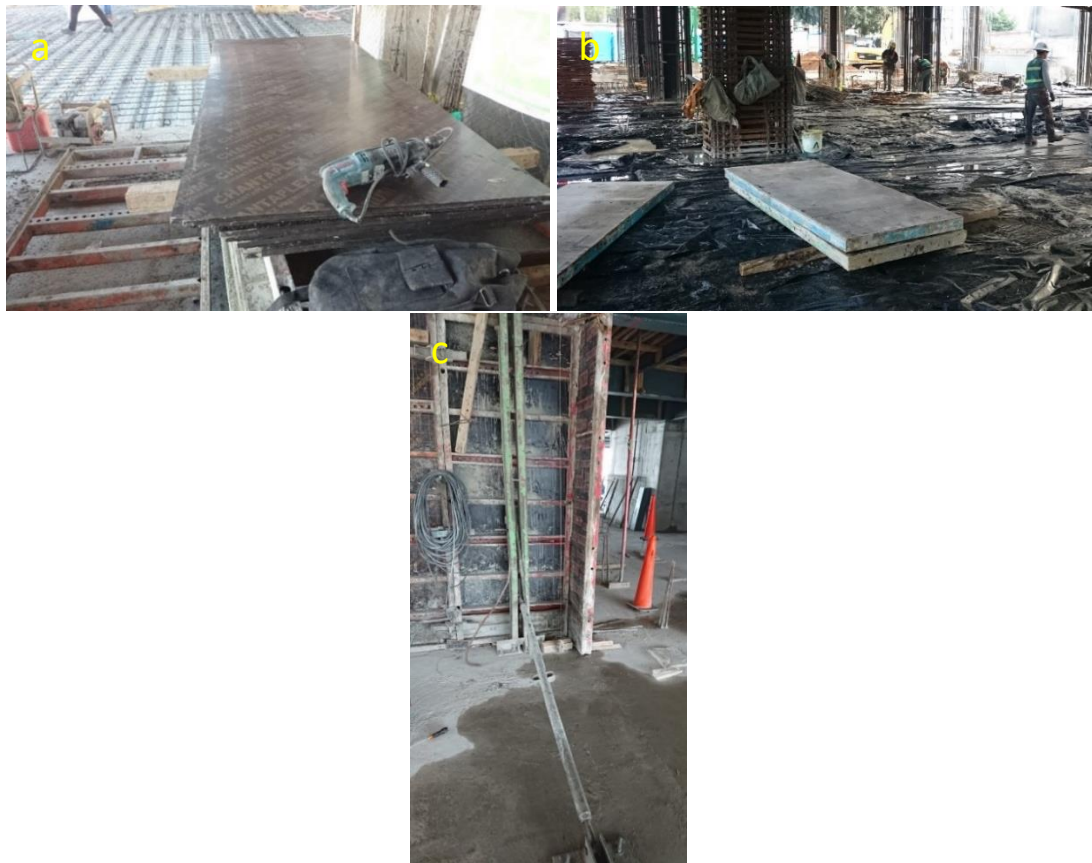
Figura 40. Panel metálico con fenólico.
