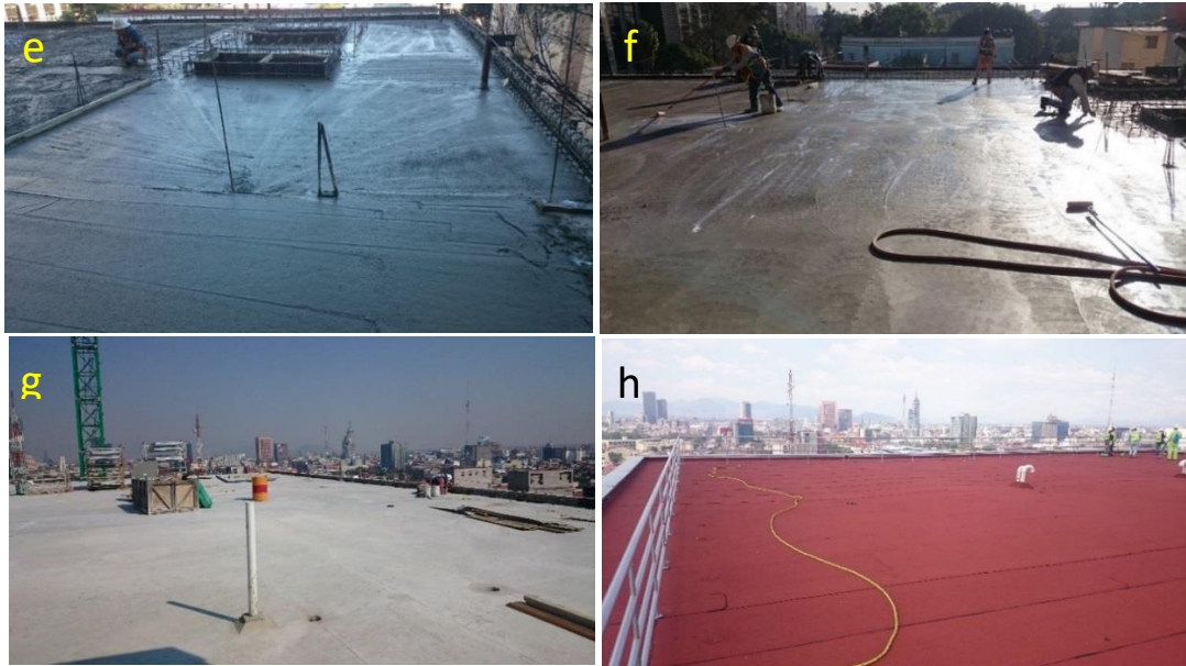
Figura 50-2. Secuencia de la construcción de la losa de azotea.
