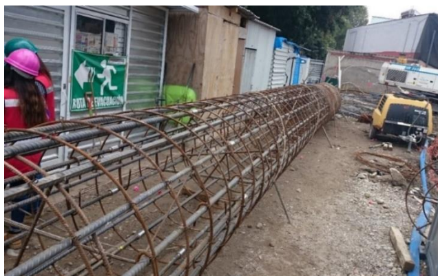
Figura 9. Sección terminada de una jaula de acero.
