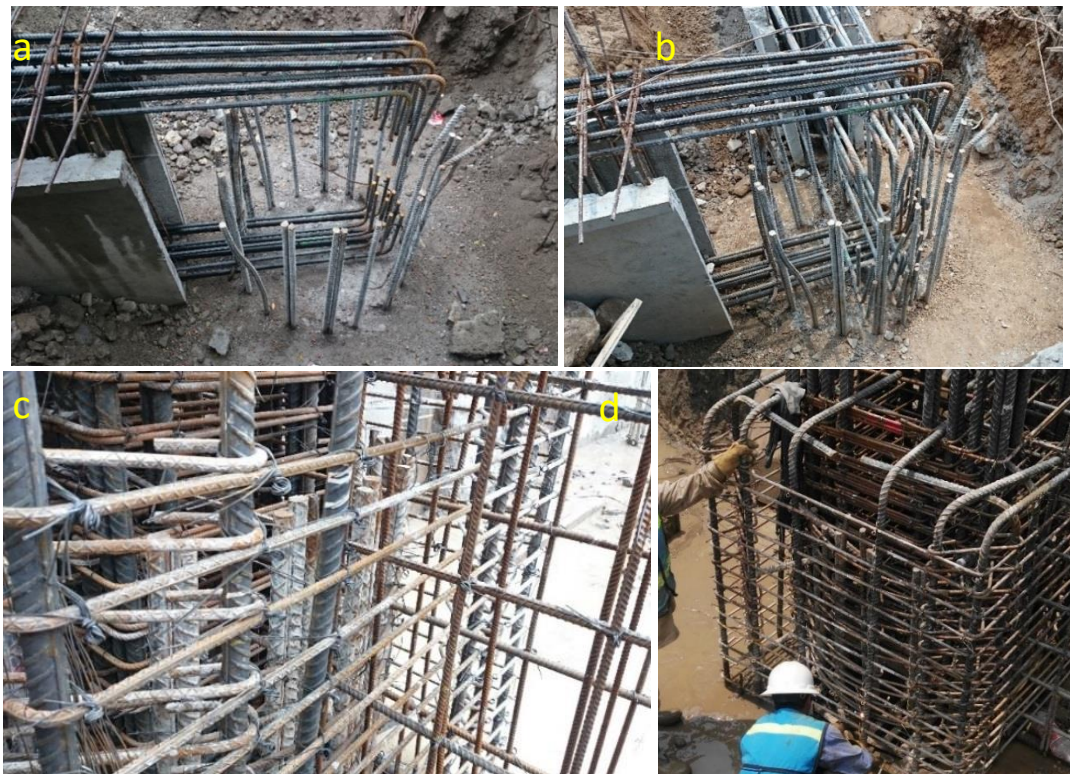
Figura 20. Fotografías del armado de acero de los dados.
