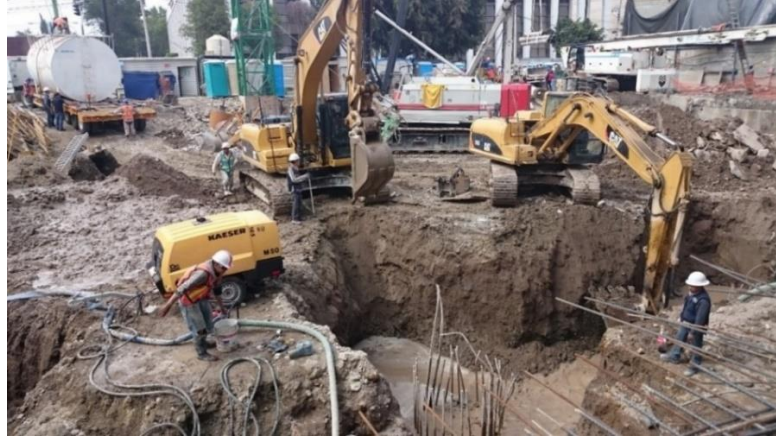
Figura 15. Excavadoras Cat 320 excavando las zanjas para las contratraves.
