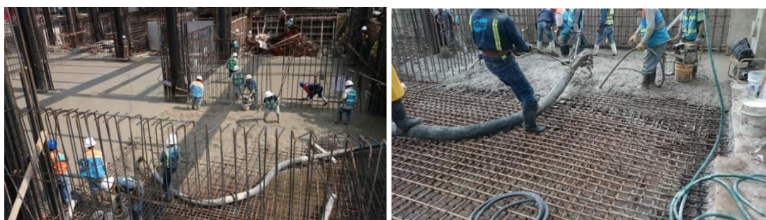
Figura 30. Colado de losa de cimentación, nivel sótanos.
