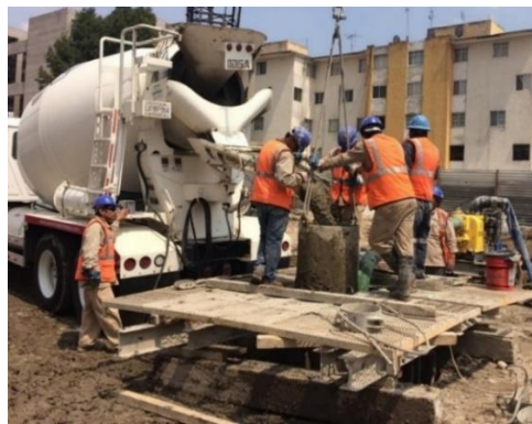
Figura 12. Colado de pila.
