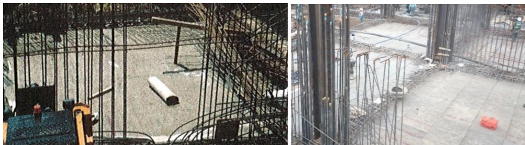
Figura 27. Membrana Voltex colocada en el terreno.
