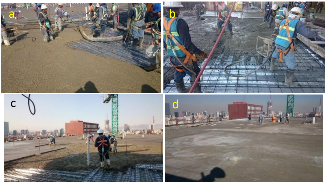
Figura 50-1. Secuencia de la construcción de la losa de azotea.
