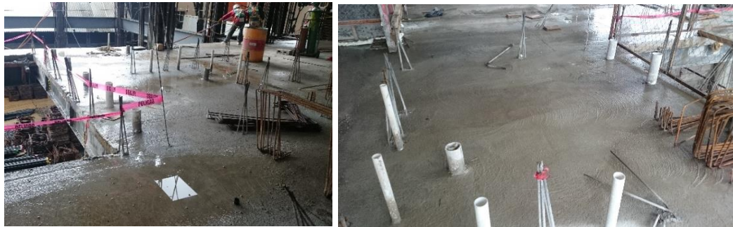
Figura 51. Preparaciones para albañilerías: anclas para desplantar castillos e instalaciones.
