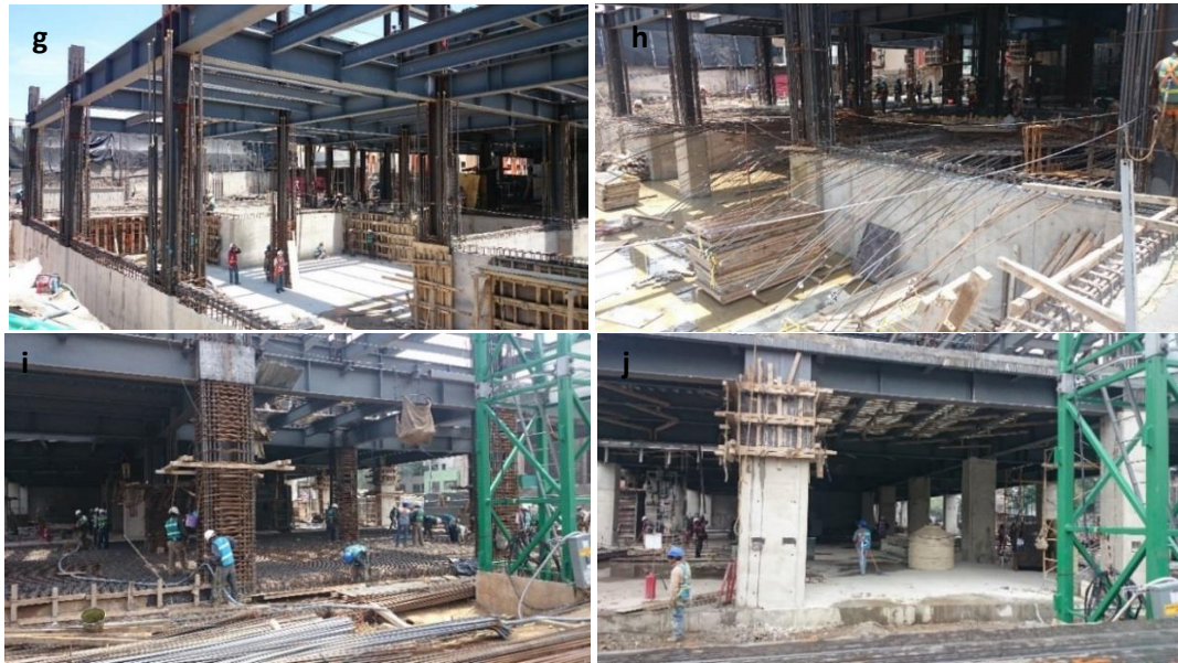
Figura 14-b. Secuencia de fotografías de la cimentación.
