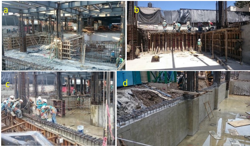
Figura 34. Cimbra y colado de muros.
