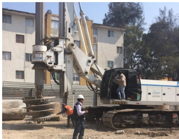
Figura 3. Perforadora HR 260 utilizada en la obra acoplada con broca espiral cilíndrica.
