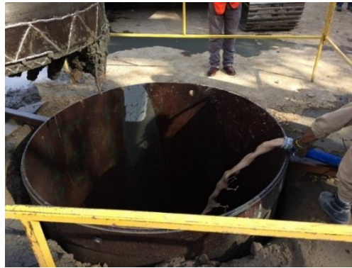
Figura 6. Aplicación de lodo bentonítico.
