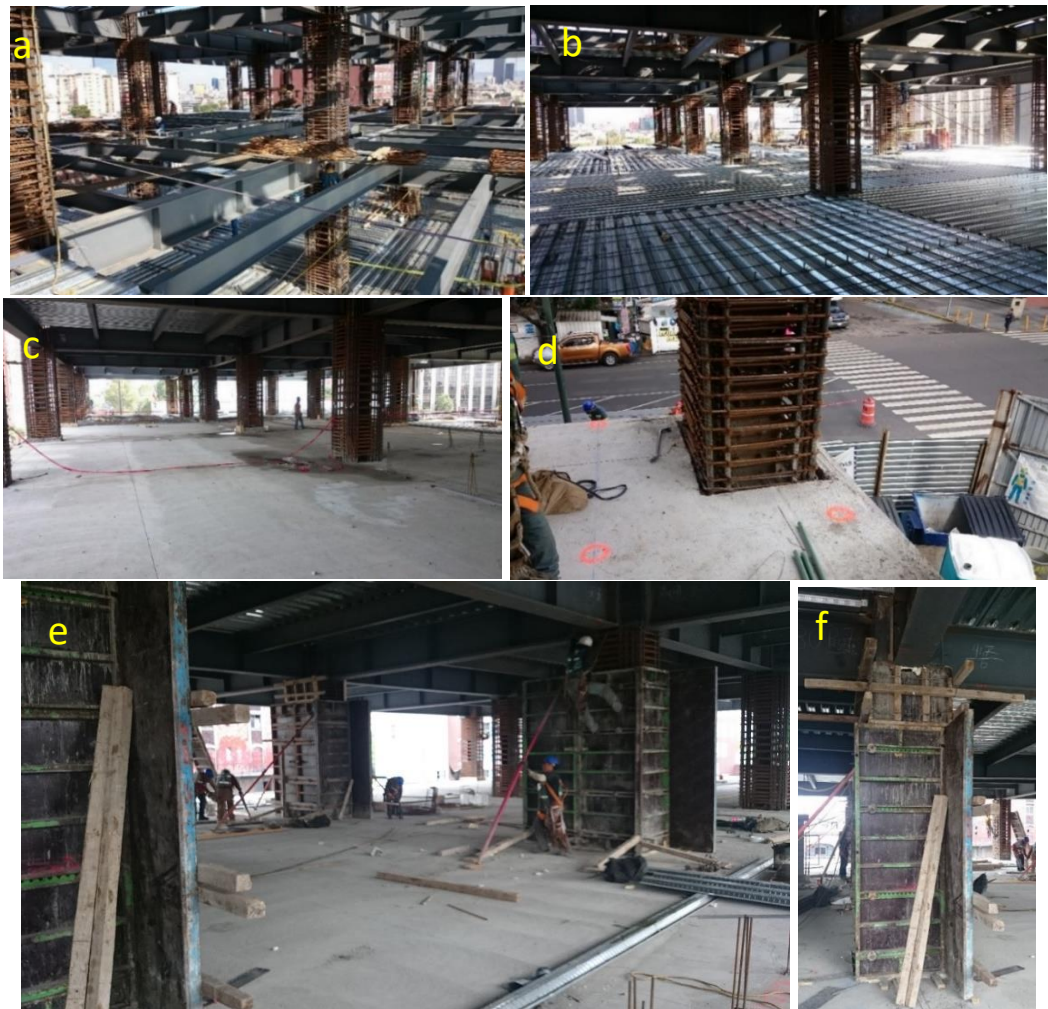
Figura 41. Proceso de cimbrado de las columnas.
