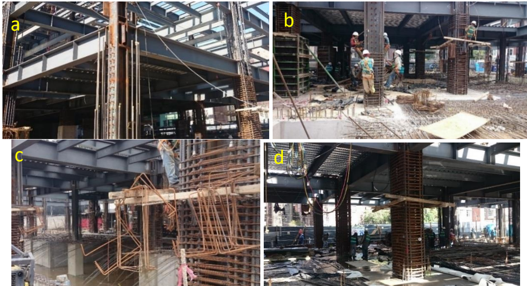
Figura 38. Armado de columnas
