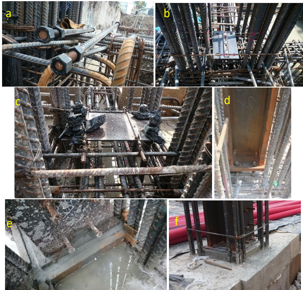
Figura 23. Proceso de colocación de viga de acero para columna.
