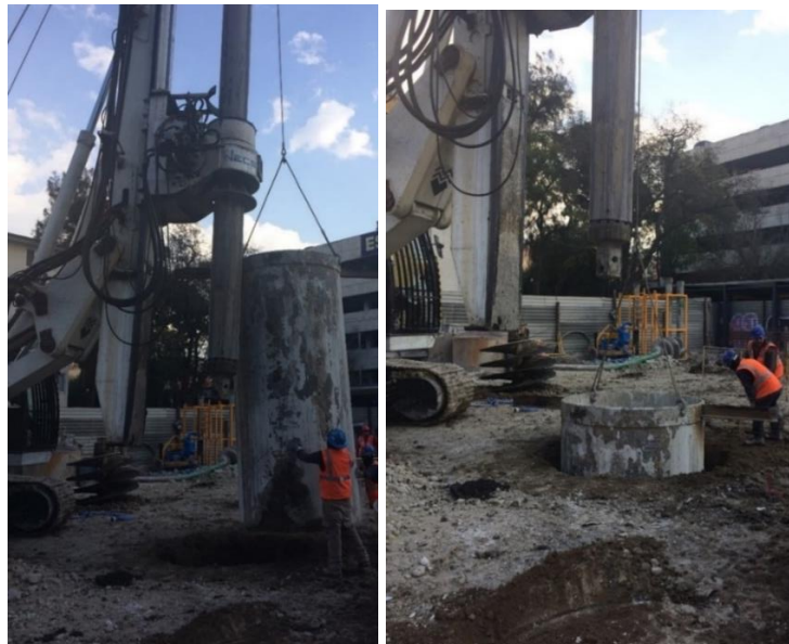
Figura 5. Colocación de ademe metálico.
