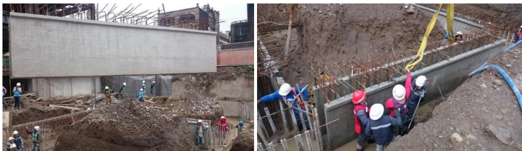
Figura 17. Colocación de trabe canal.
