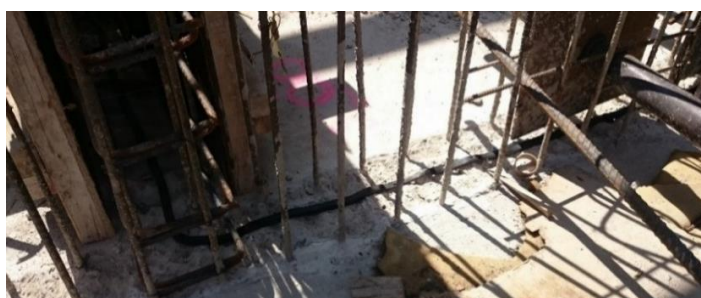
Figura 32. Banda Waterstop y desplante de muro.
