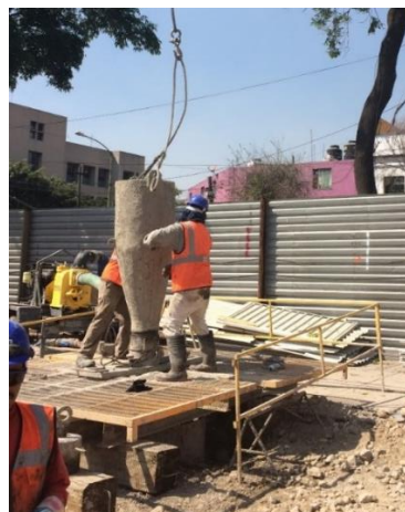
Figura 11. Plataforma para colado de pila.
