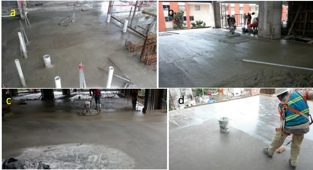
Figura 49. Trabajos posteriores al colado.
