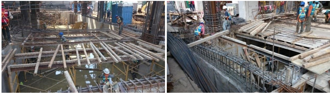
Figura 36. Cimbra para la losa tapa de cimentación
