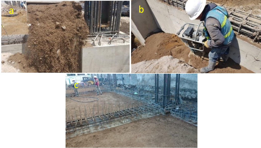
Figura 26. Relleno de material.
