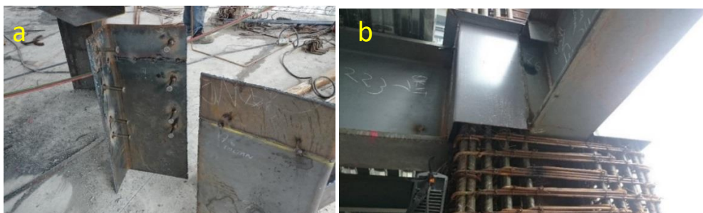
Figura 39. Zuncho metálico en conexiones de columnas y vigas.
