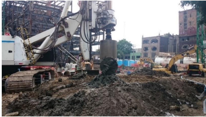
Figura 4. Perforadora acoplada con bote cortador.
