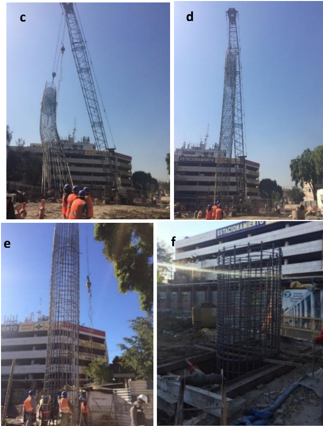
Figura 10-b. Izaje de una sección de la jaula de acero.
