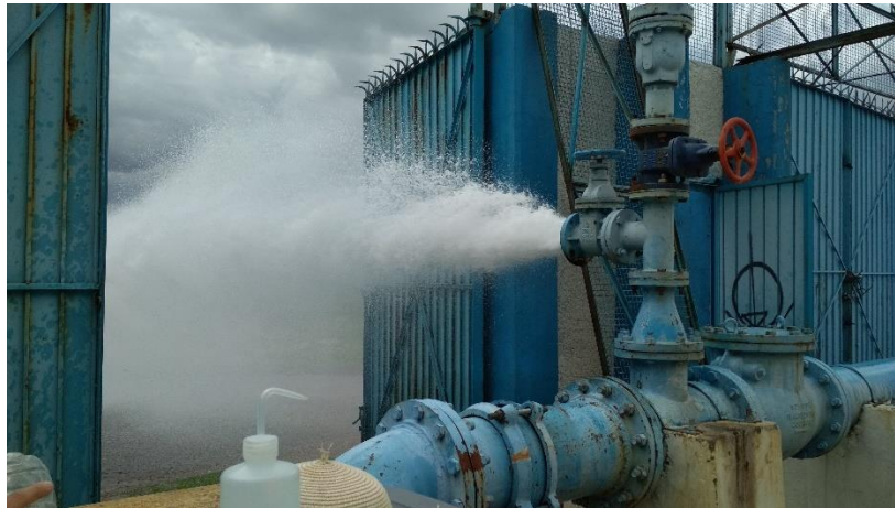
Figura 14. Proceso en que se desfoga el pozo de agua.
