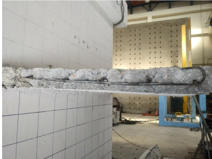
Figura 31. Colocación del armado de la losa
