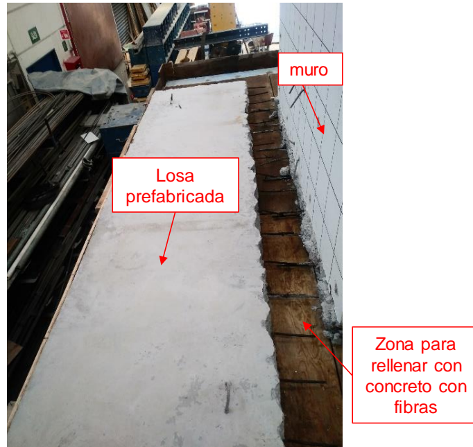
Figura 7. Detalle de los anclajes de varilla
