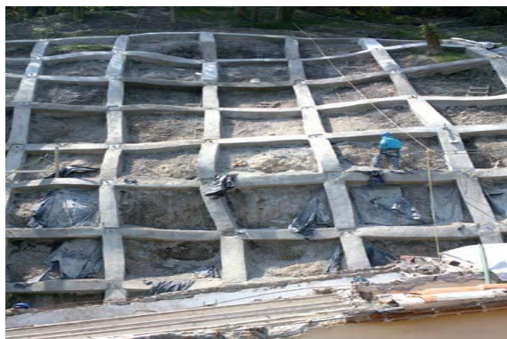
Estabilidad de taludes, método Grid Beam System, Japón
