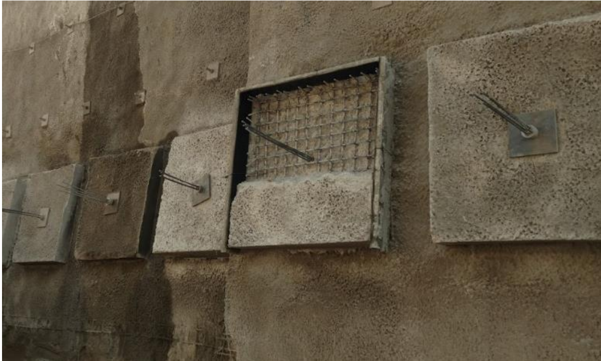
Fotografía 8. Demolición de Zapata de Reacción. (2 de 2).
