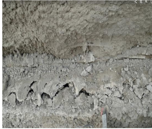
Fotografía 6. Zapata fisurada y agrietada durante el proceso de tensado.
