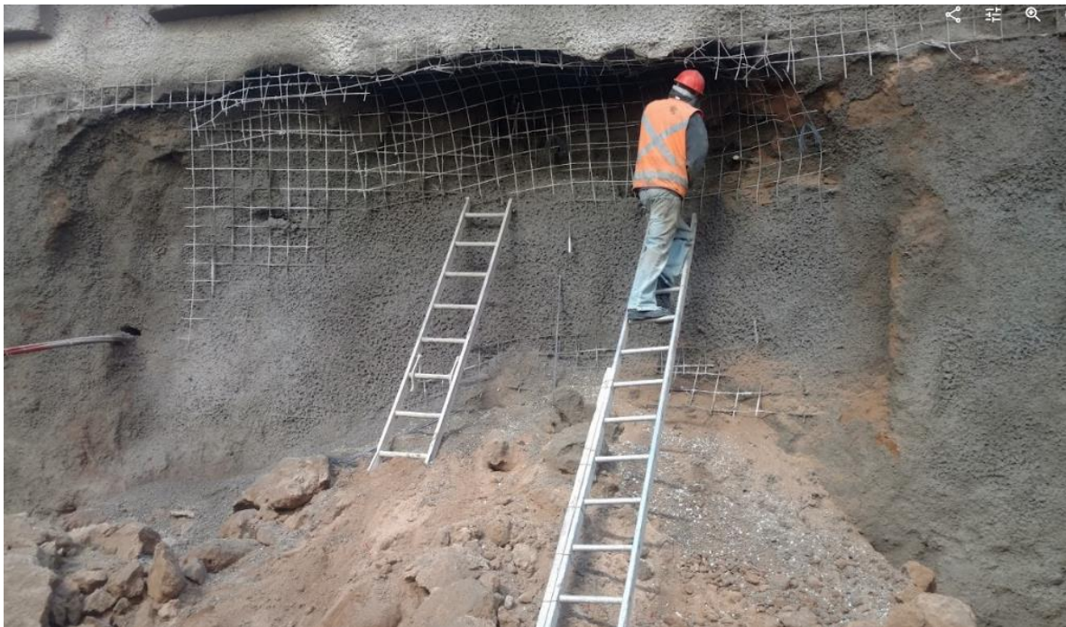
Fotografía 9. Colocación de malla y concreto lanzado para proteger el corte debido a desconches.
