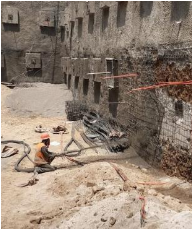
Fotografía 13. Colocación de concreto lanzado comenzando de abajo hacia arriba (1 de 4).
