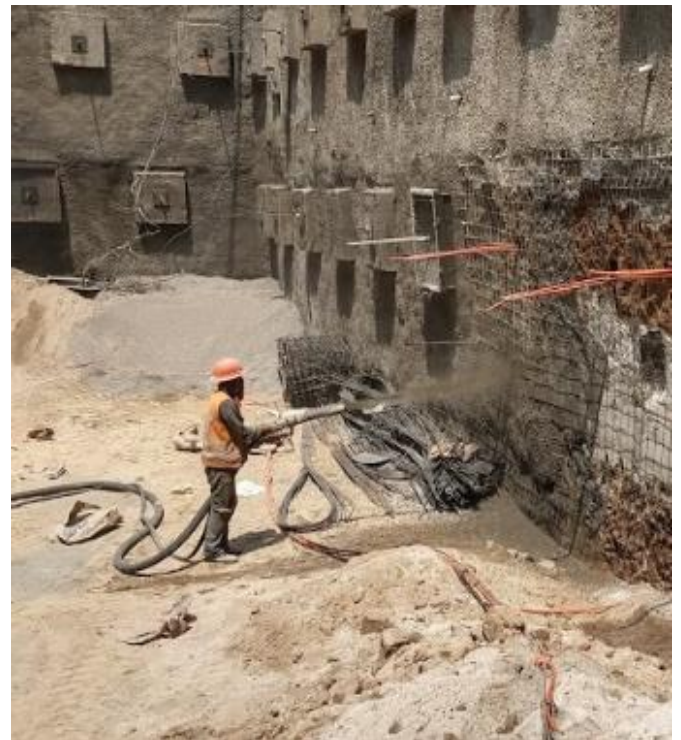
Fotografía 14. Colocación de concreto lanzado comenzando de abajo hacia arriba (2 de 4).
