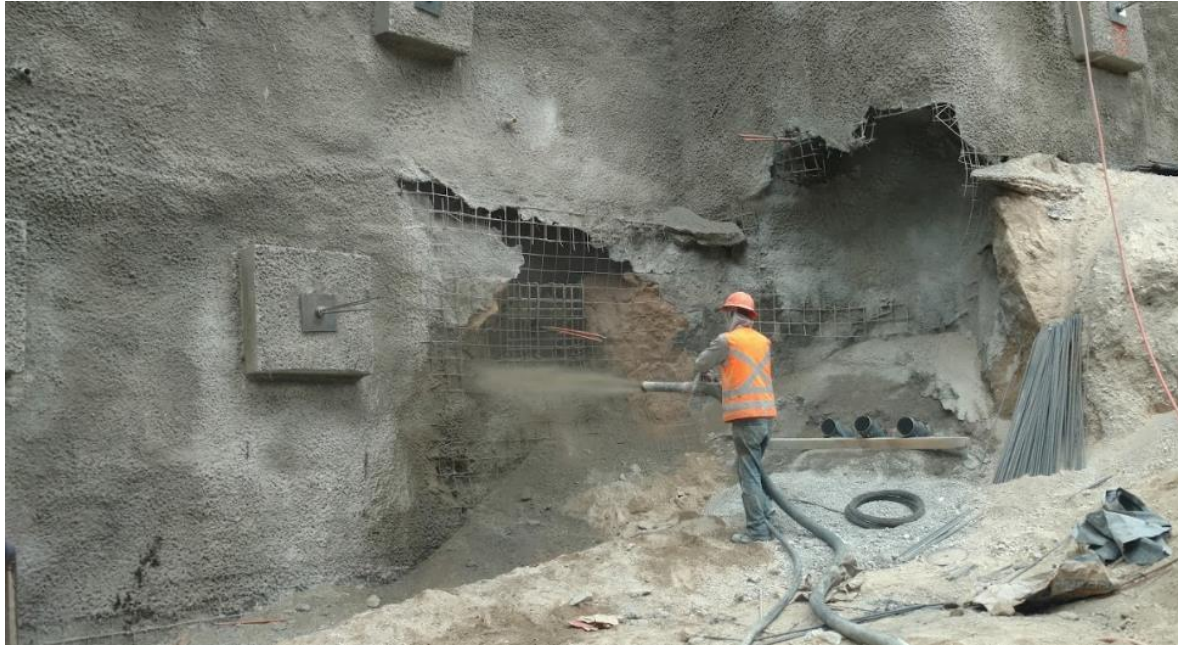
Fotografía 10. Zapata embutida a consecuencia de un desconche.
