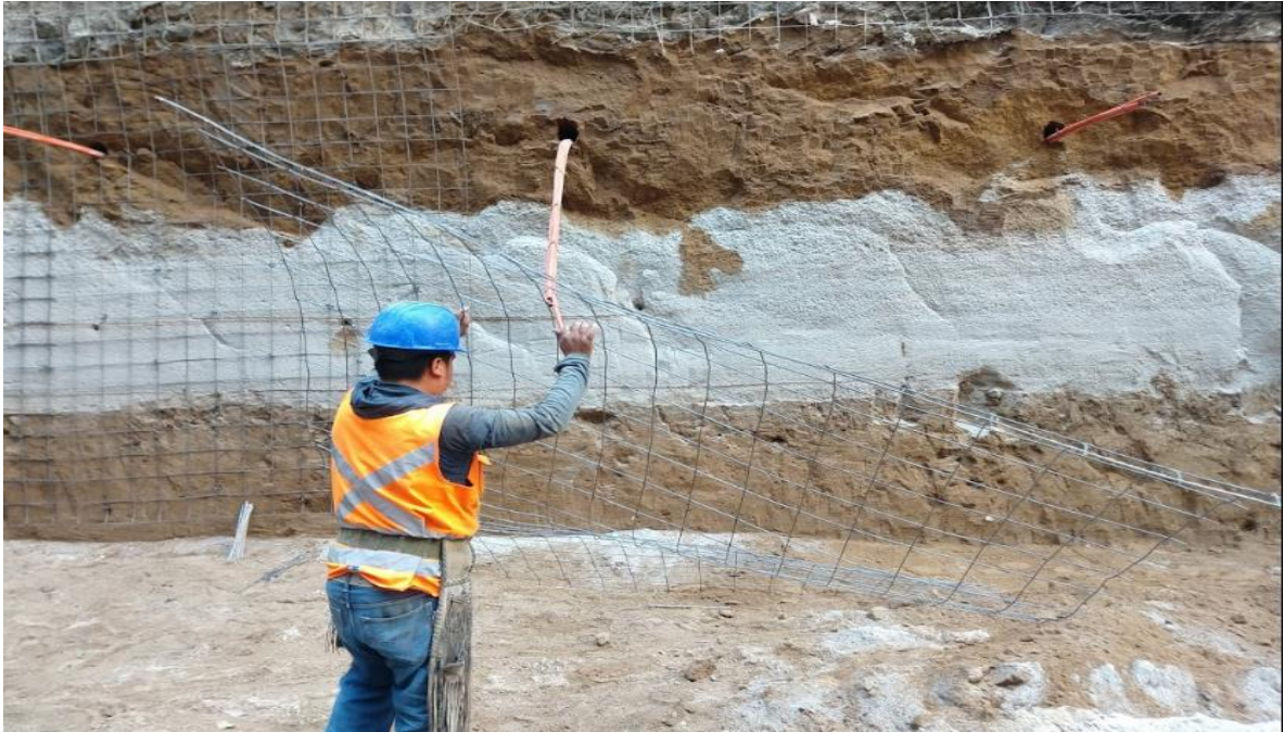
Fotografía 12. Colocación de malla electrosoldada.
