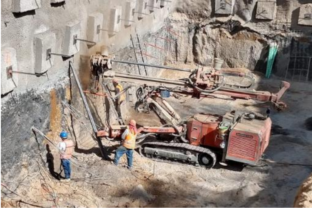
Fotografía 17. Perforación (Drenes de alivio 1 de 4).
