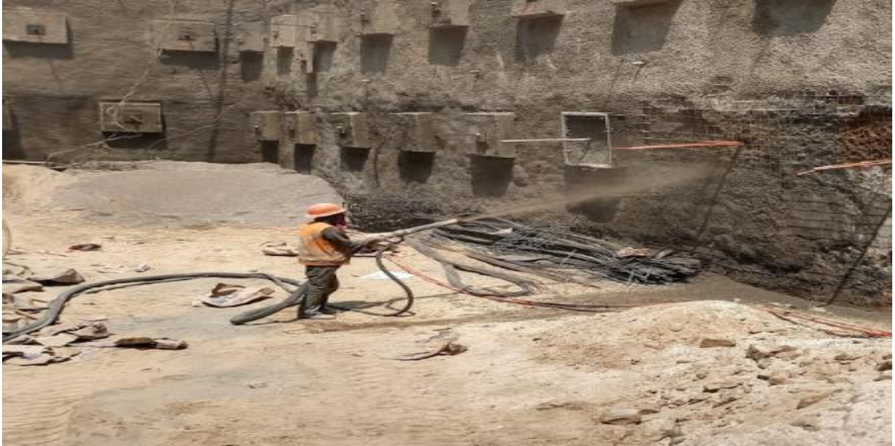
Fotografía 15. Colocación de concreto lanzado comenzando de abajo hacia arriba (3 de 4).
