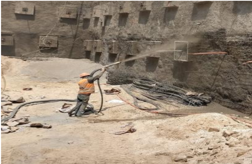
Fotografía 16. Colocación de concreto lanzado comenzando de abajo hacia arriba (4 de 4).
