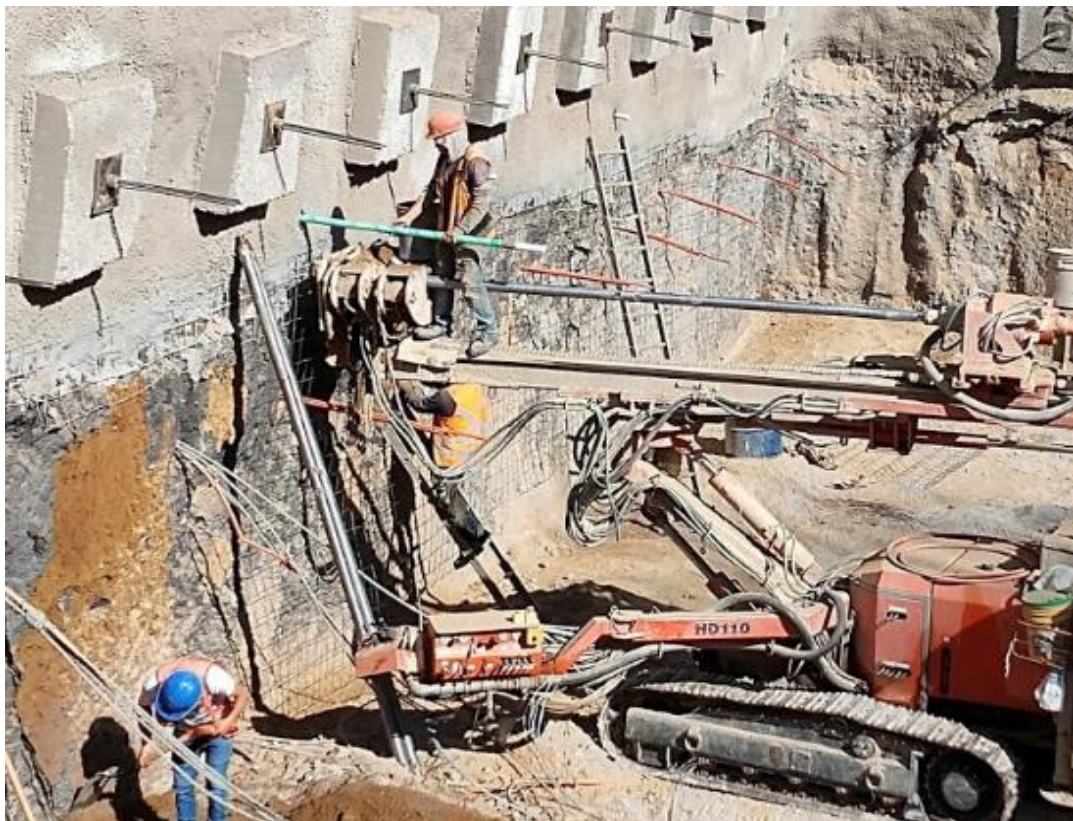
Fotografía 18. Colocación del dren (Drenes de alivio 2 de 5).
