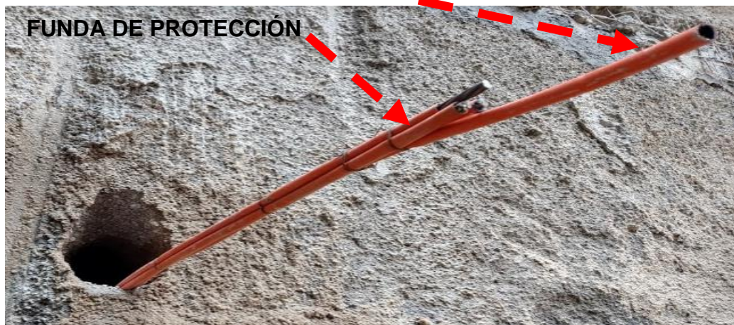
Ilustración 4. Tubo de inyección y mangueras de protección de los cables.
