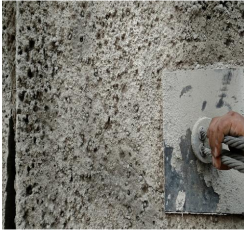
Fotografía 6. Zapata fisurada y agrietada durante el proceso de tensado.
