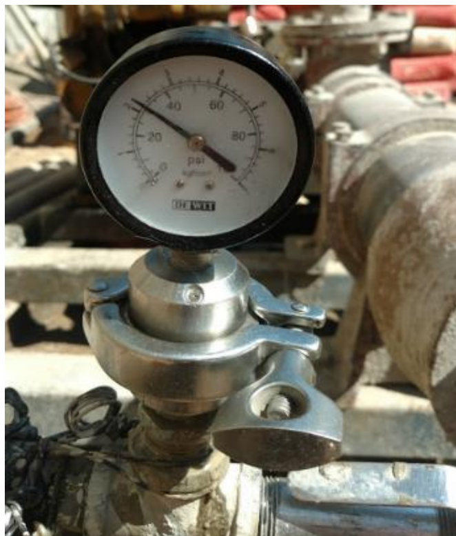
Fotografía 2. Supervisando que la presión para inyección sea lo que indica el estudio.
