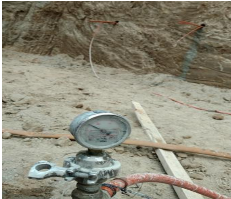
Fotografía 3. Inyección de lechada a 2 kg/cm 2 y al fondo se aprecia el barreno en el que se aplica la lechada, se aprecia que los barrenos no tienen un obturador y por lo cual se inyectan hasta que la lechada sale por el barreno.
