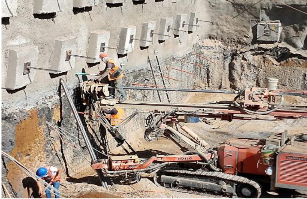
Fotografía 19. Colocación del dren (Drenes de alivio 3 de 4).
