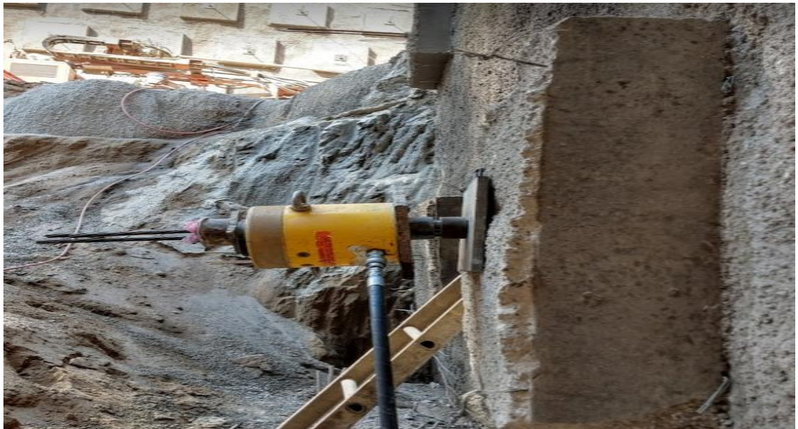
Ilustración 12. Tensado de ancla activa.
