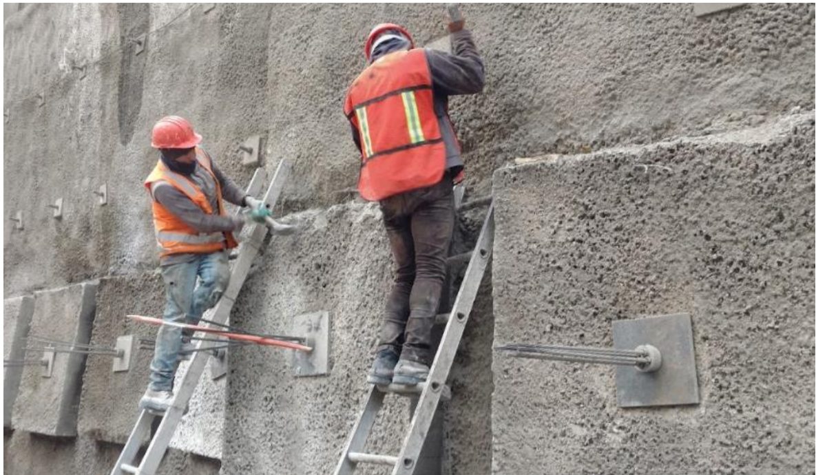
Fotografía 7. Demolición de Zapata de Reacción. (1 de 2).
