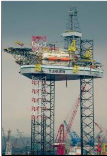
Imagen 6 Plataforma Auto Elevable Petrolera "Spud Can" (Tomada de Petróleos Mexicanos, 2015)
