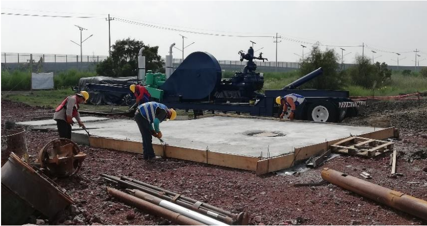
Ilustración 19 Preliminar. Losa de cimentación. Fuente: Elaboración propia.
