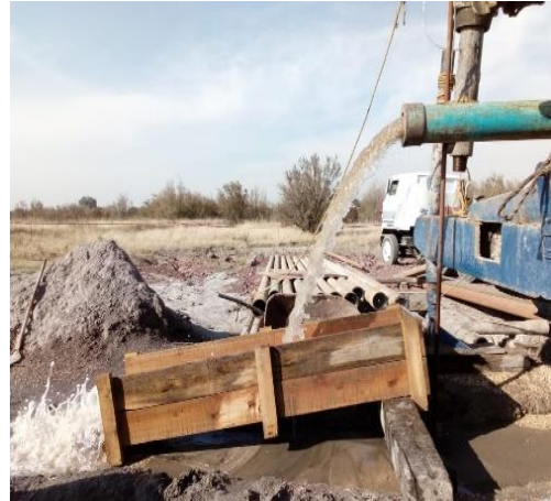
Ilustración 62 Inicio de prueba de aforo. Fuente: Elaboración propia.
