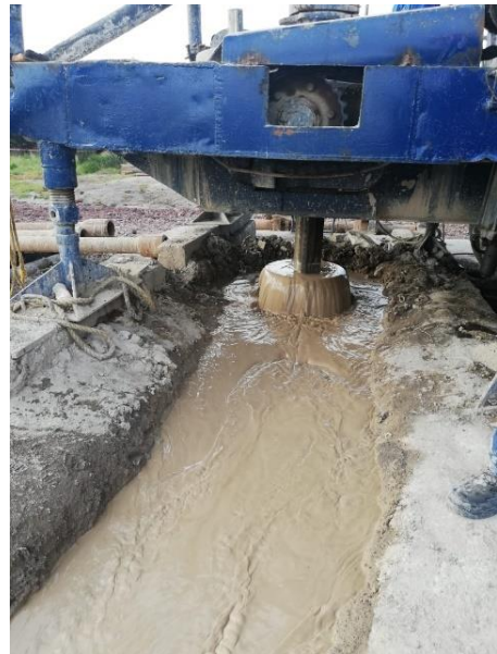
Ilustración 43 Retorno de fluido de perforación. Fuente: Elaboración propia.
