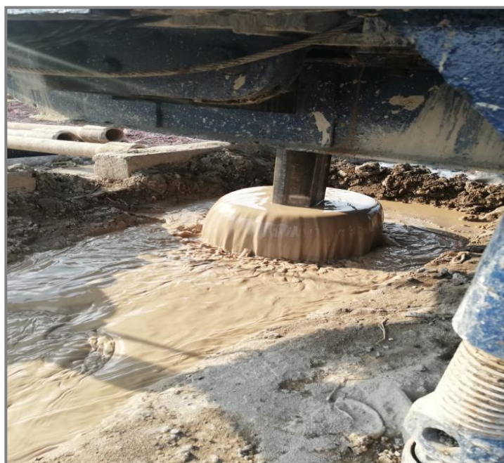
Ilustración 28 Canal conductor del fluido de perforación. Fuente: Elaboración propia.
