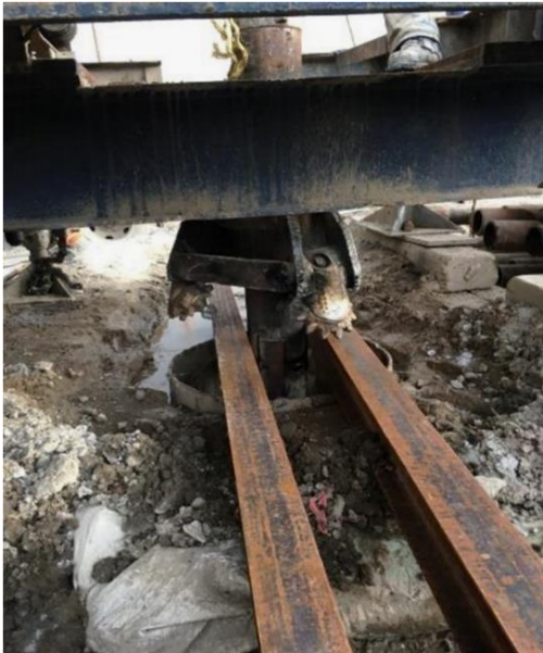
Ilustración 42 Colocación de barrena tricónica. Fuente: Elaboración propia.
