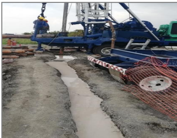
Ilustración 28 Canal conductor del fluido de perforación. Fuente: Elaboración propia.
