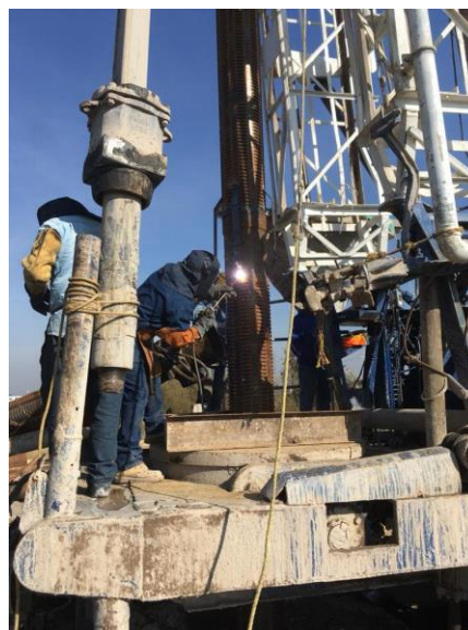
Ilustración 57 Aplicación de soldadura en tubería ranurada. Fuente: Elaboración propia.
