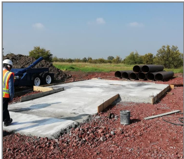
Ilustración 25 Término de construcción de la losa de cimentación. Fuente: Elaboración propia.
