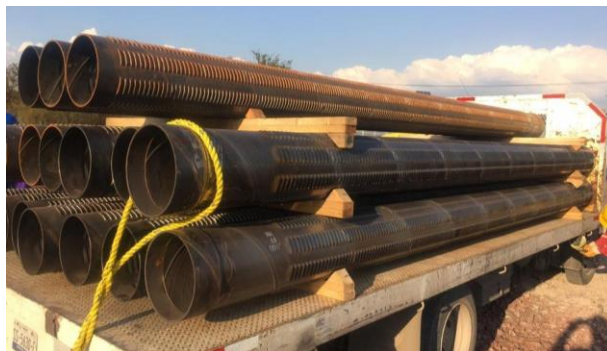
Ilustración 53 Suministro de tubería ranurada. Fuente: Elaboración propia.
