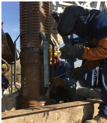
Ilustración 54 Colocación de tubería ranurada.
