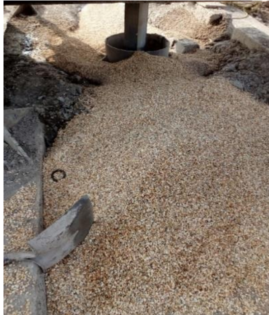
Ilustración 59 Colocación de grava de cuarzo. Fuente: Elaboración propia.
