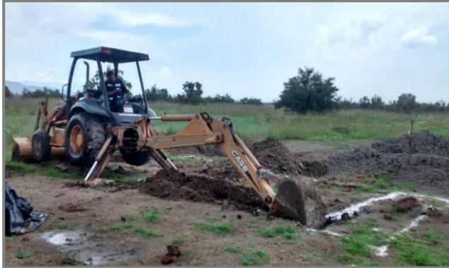
Ilustración 26 Excavación preliminar de fosas para fluido de perforación. Fuente: Elaboración propia.
