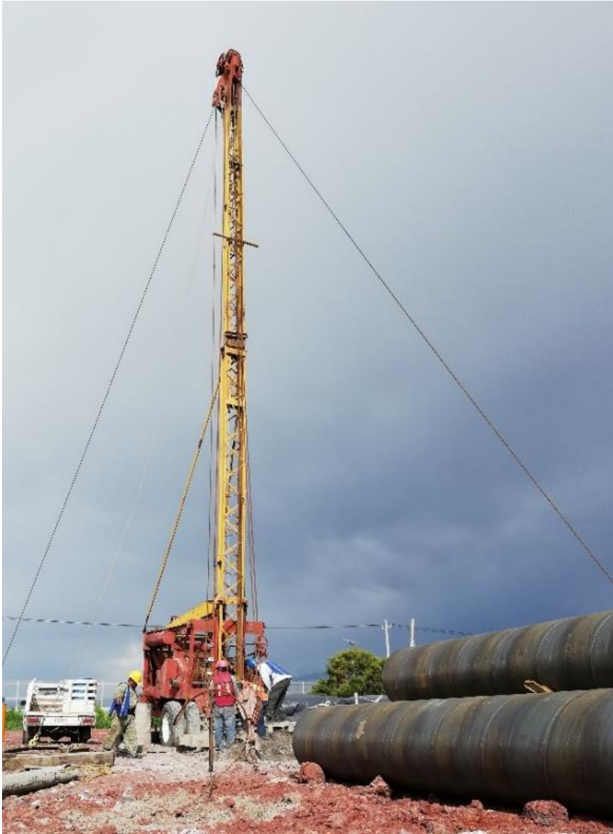
Ilustración 15 Equipo de perforación tipo percusión. Fuente: Elaboración propia.
