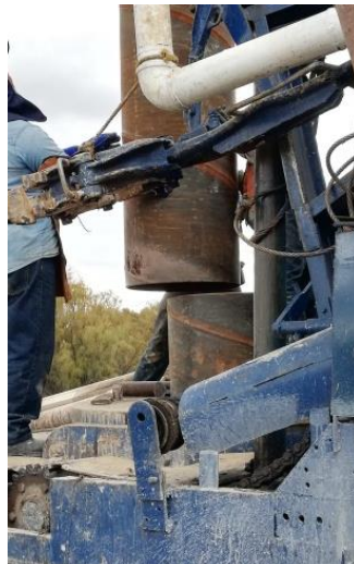
Ilustración 47 Acoplamiento de tubería lisa. Fuente: Elaboración propia.
