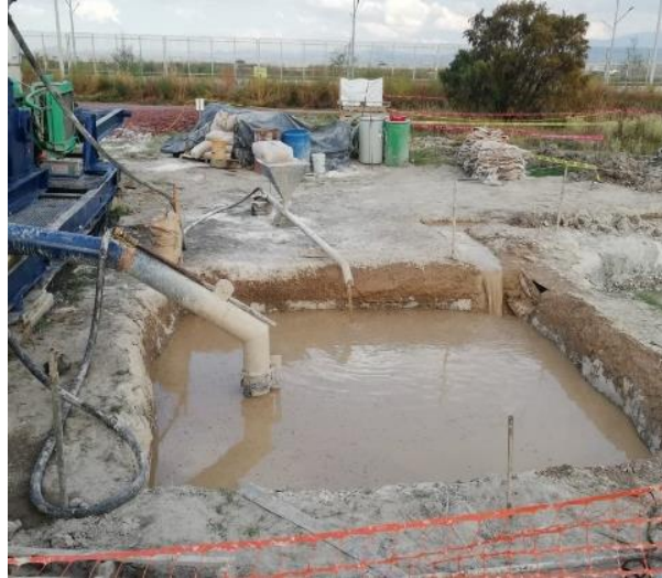
Ilustración 40 Fosa contenedora de lodo a base de bentonita sódica. Fuente: Elaboración propia.
