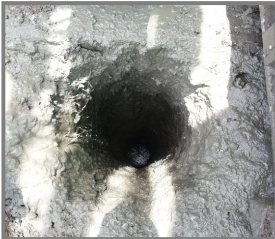
Ilustración 34 Diámetro de perforación primera etapa (Ø12 ¼"). Fuente: Elaboración propia.
