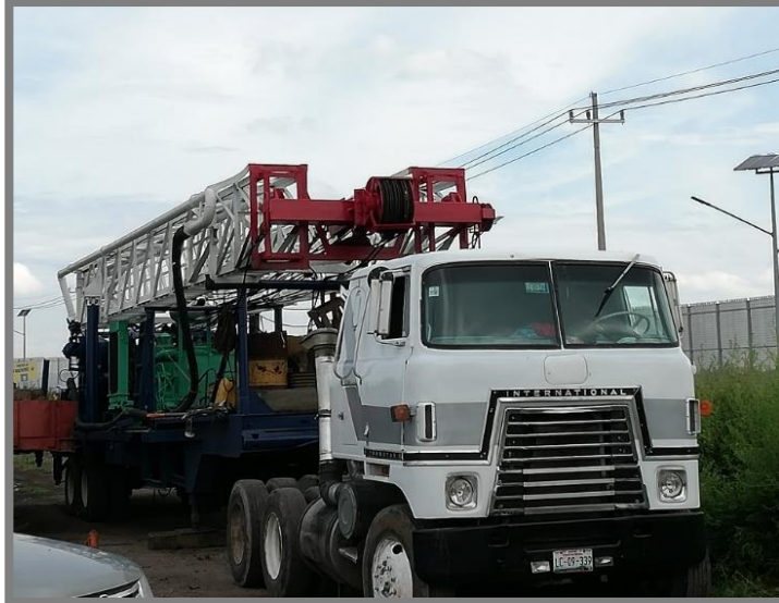
Ilustración 38 Ingreso de equipo de perforación con sistema rotario.
