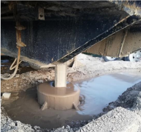
Ilustración 49 Expulsión de fluido de perforación. Fuente: Elaboración propia.
