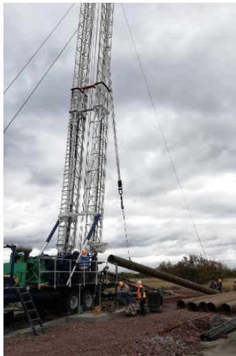
Ilustración 46 Izaje de tubería lisa. Fuente: Elaboración propia.
