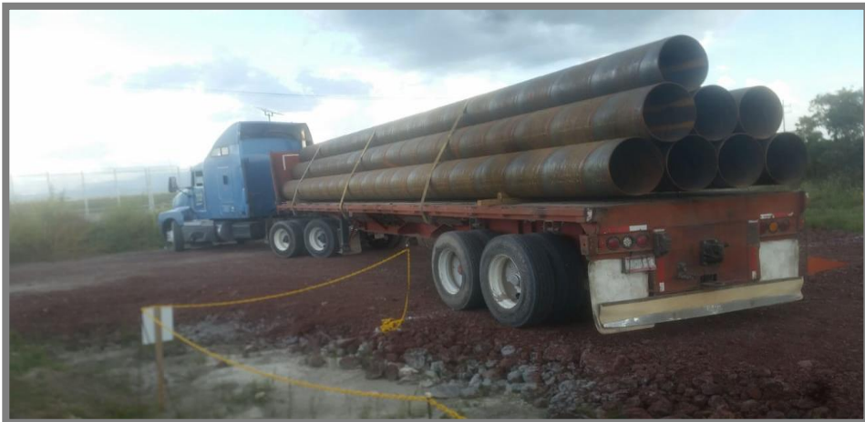
Ilustración 37 Ingreso de tubería lisa al sitio de los trabajos. Fuente: Elaboración propia.
