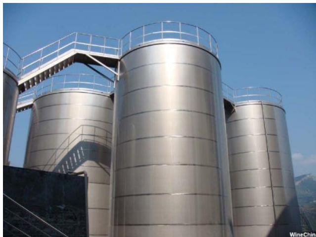
Ilustración 9. Tanque vertical de almacenamiento de combustible
