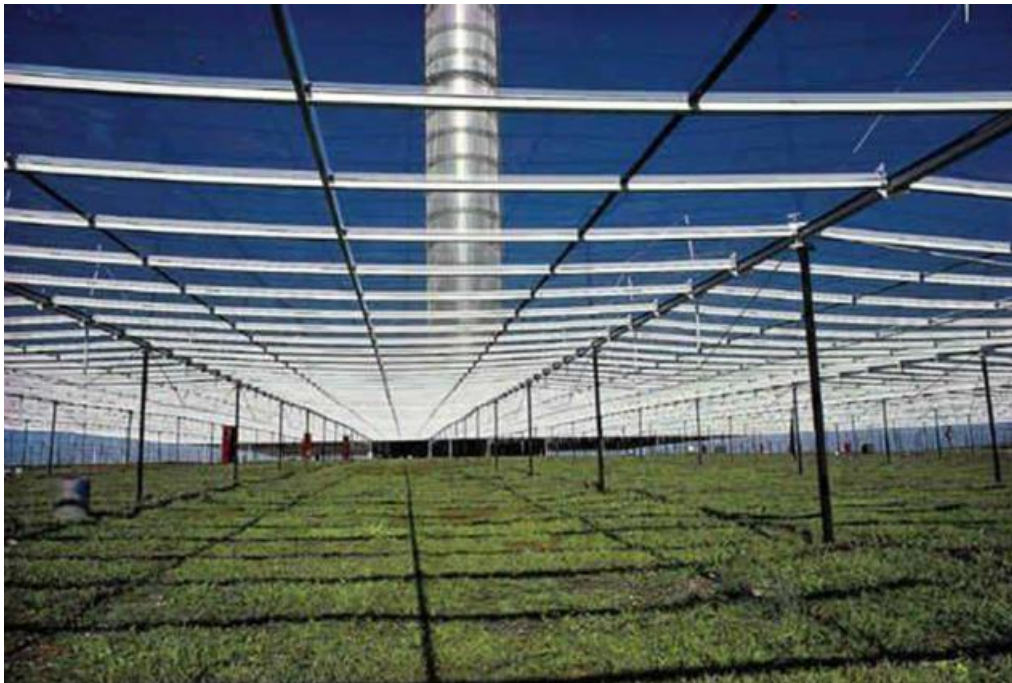
Figura 26. Interior del colector de la chimenea solar, Manzanares, España [29].
