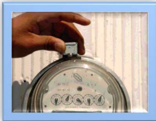
Ilustración 18 Revisión con un imán, posible UI bobinas abiertas.
