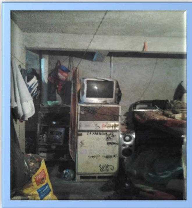
Ilustración 10 casa de escasos recursos, se notan malos hábitos. No se deja separación ni respiración de aire fresco al refrigerador, así como un refrigerador obsoleto y con una mala instalación eléctrica solo con extensiones, así como la ubicación de equipo que produce calor por encima. FOTO: COL. DEGOLLADO IZTAPALAPA QUEJA POR ALTO CONSUMO
