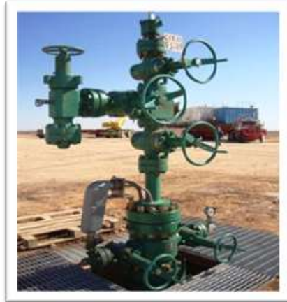
Ilustración 5. Medición a nivel de Pozo.
