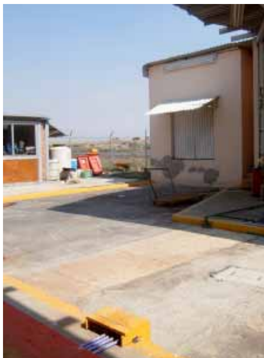
Fotografía III.2. Distancia entre cárcamo de lixiviados a zona de lisímetros
