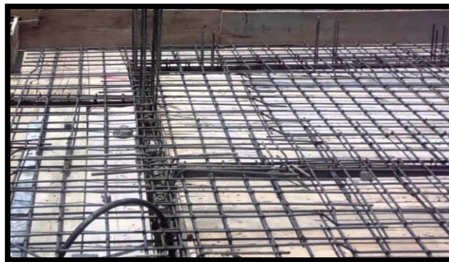
Figura 3.1. Armado de losa maciza de concreto reforzado.
