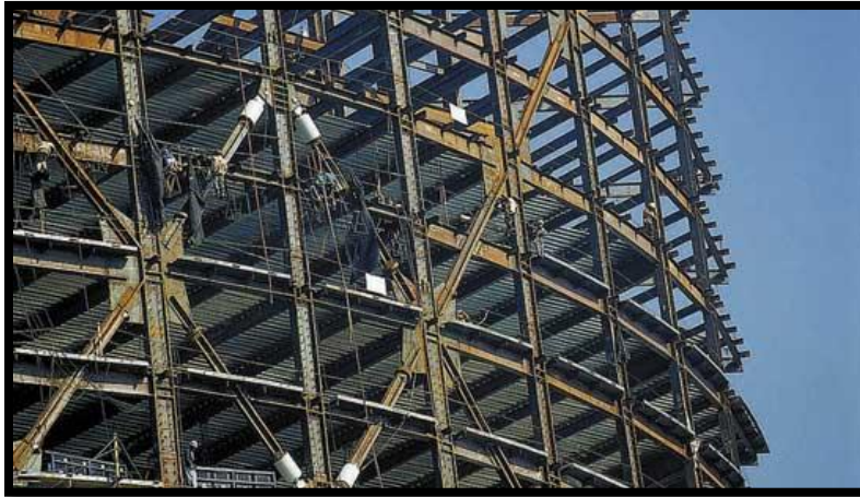
Figura 1.19. Contraventeo de edificios.
