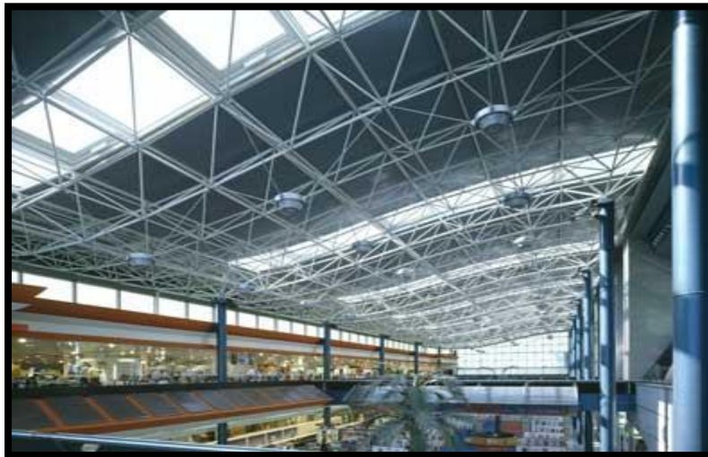
Figura 1.20. Barras de una armadura espacial o tridimensional en tensión axial.
