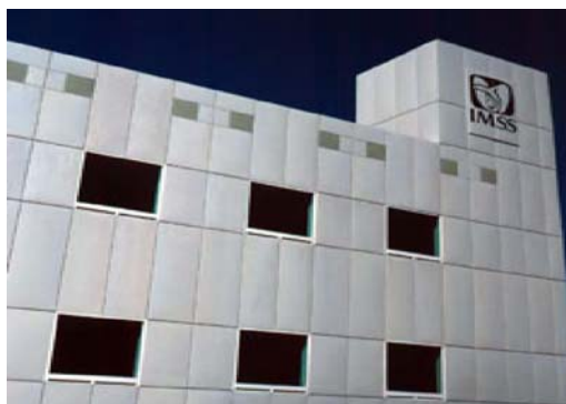
Figura 12. Fachada Hospital IMSS con muros de Porcewol
