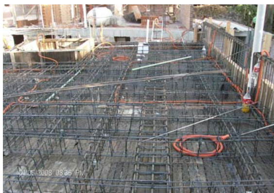
Fotografía 8. Armado de nervaduras de losa aligerada
