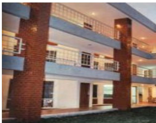
Fotografía 12. Edificio con muros de block de barro vidriado
