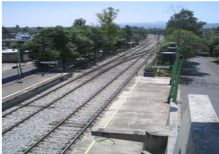
Fotografía 5. Vía sobre Balasto
