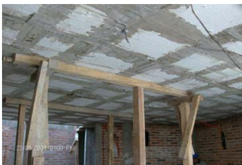
Fotografía 7. Losa aligerada con nervaduras de concreto reforzado
