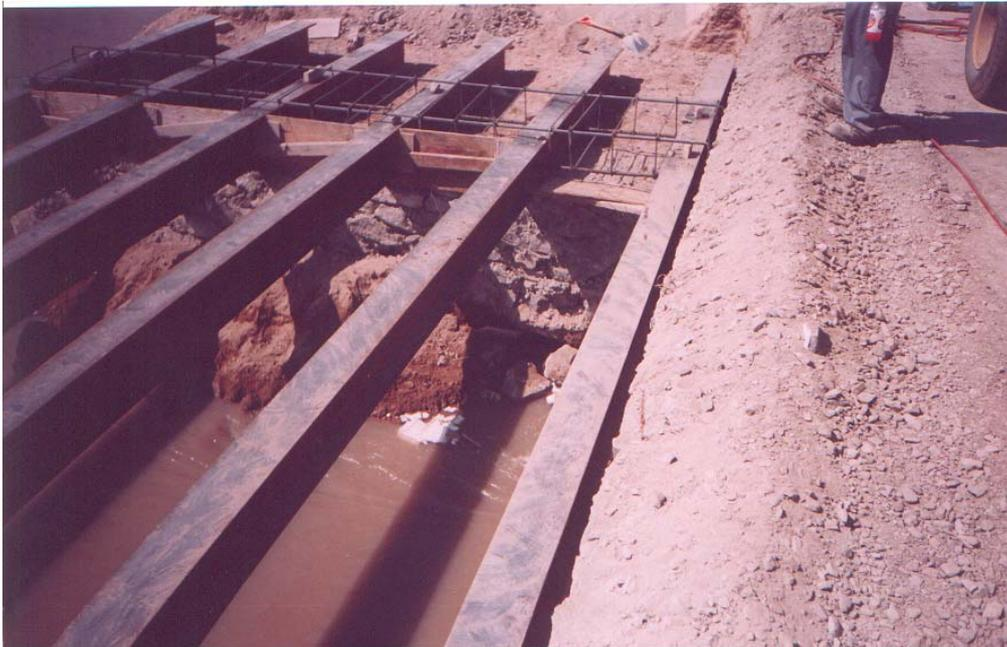
SE COLOCARON VIGAS DE PERFIL IPR, PARA SOPORTAR LA LOSA.
