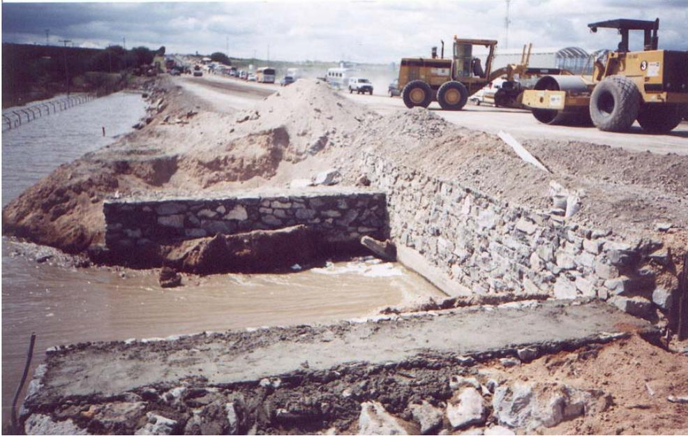
SE ADECUO UNA ALCANTARILLA DE SECCIÓN CUADRADA YA EXISTENTE SE AMPLIO EL MURO DE MAMPOSTERIA Y SE MUROS DE APOYO PARA SOSTENER LA LOSA.
