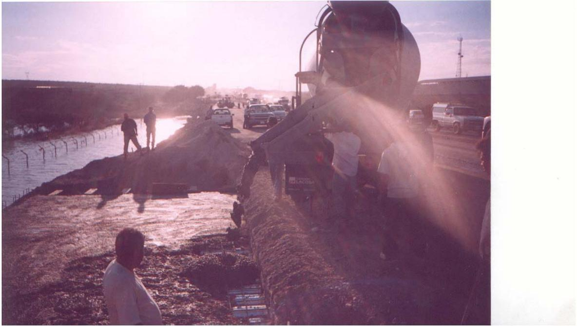
FINALMENTE SE COLO LA LOSA DE CONCRETO
