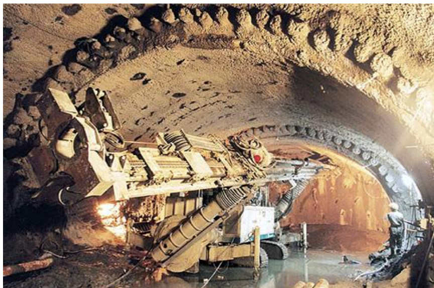
Figura 2.1. Colocación del paraguas de micropilotes
