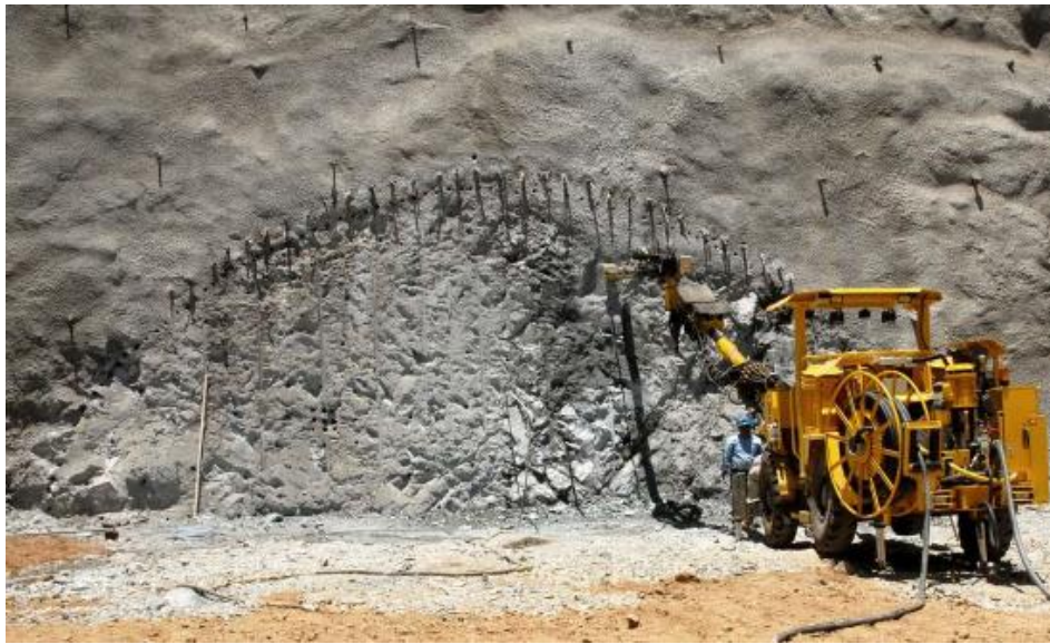
Figura 2.4. Enfilaje ligero en un portal. Túnel Las Palomas, México. Foto Consultec
