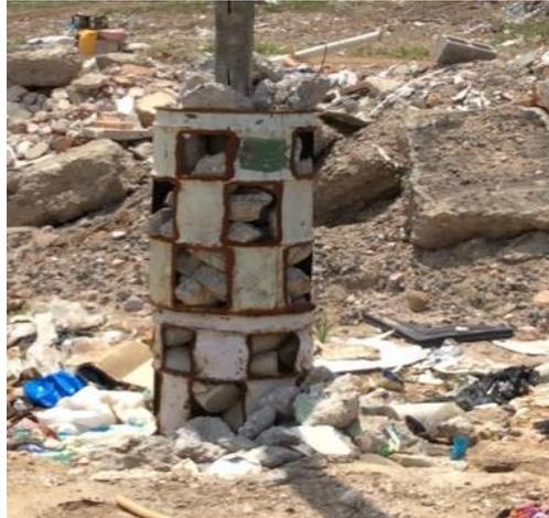
*Figura 3.9 Pozo de extracción y quema de biogás
