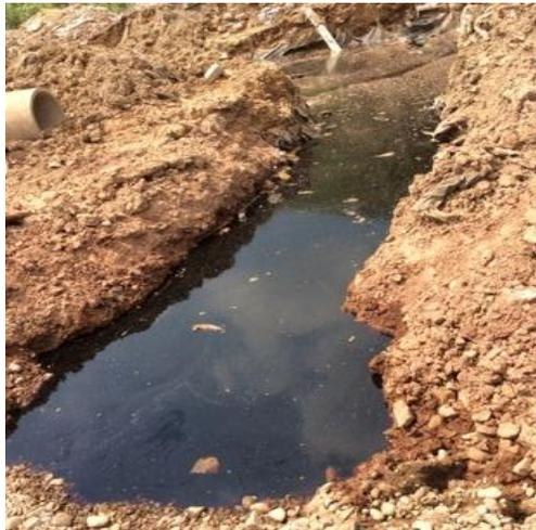
*Figura 3. 8 Filtración de lixiviados en el subsuelo*
