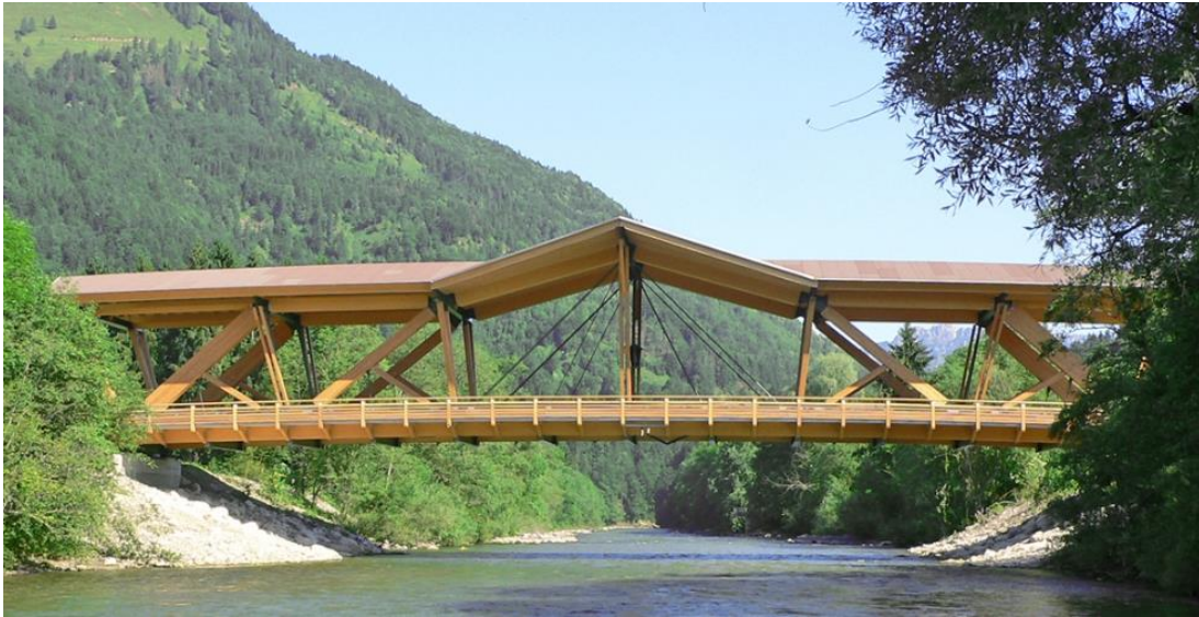
Figura 1.1 Puente Kossen, Australia
