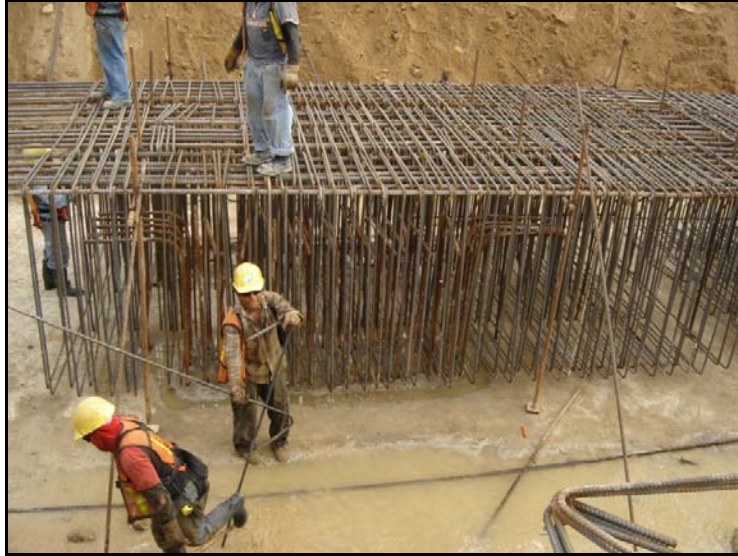
Figura 3.29. Armado de traves correderas.
