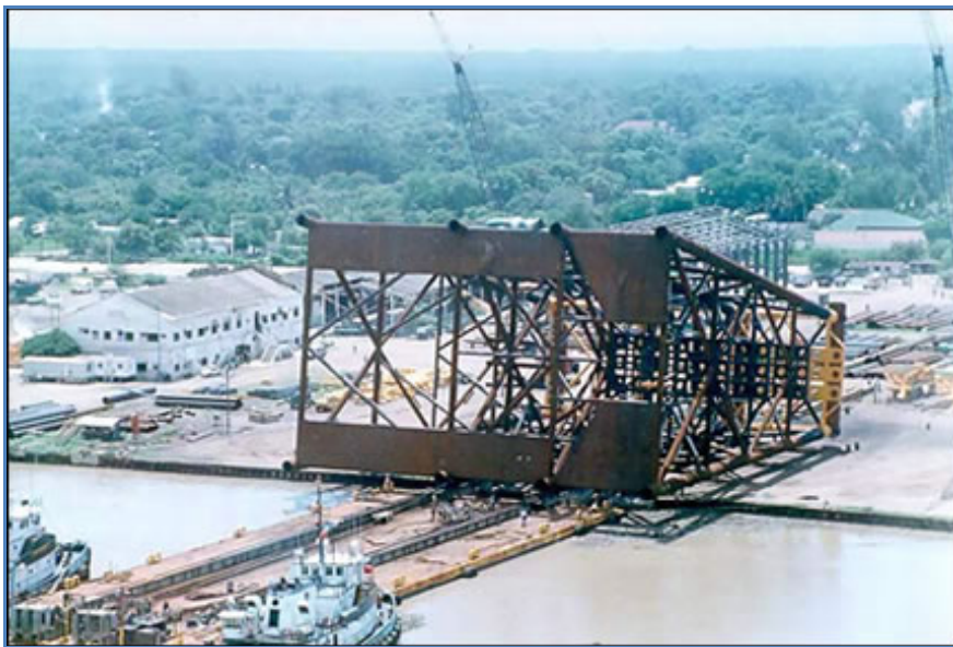
Figura 11. Subestructura lista y preparada para retirarse del patio.
