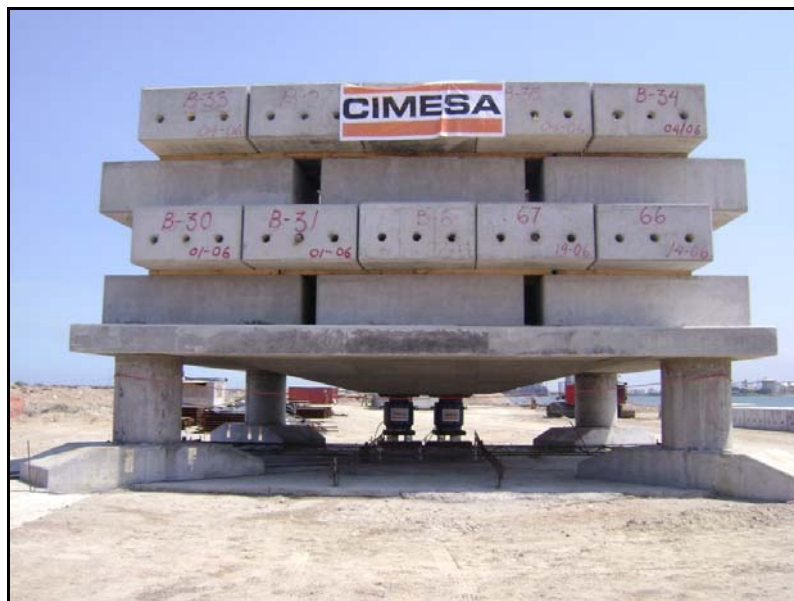
Figura 2.27. Fotografía que muestra la prueba de carga con los gatos hidráulicos.
