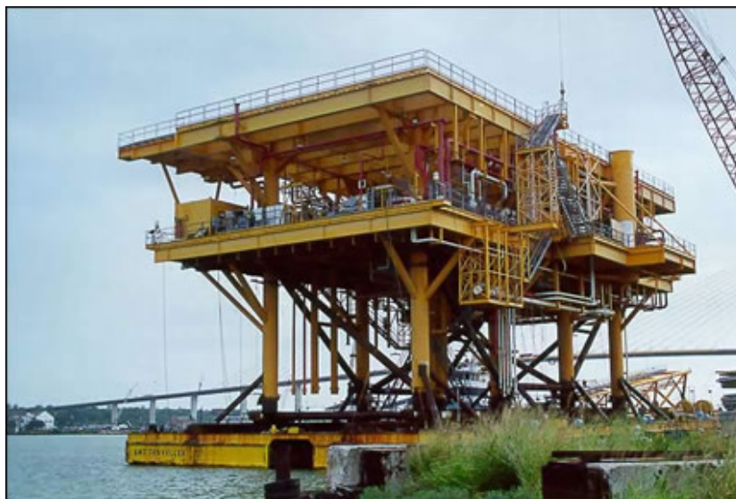
Figura 23. Vista de superestructura en cubierta de Chalán.
