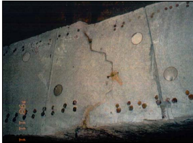
Figura 3.11. Junta de PVC entre lado primario con secundario.
