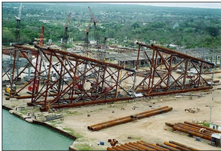
Figura 9. Izaje de marco eje de subestructura.
