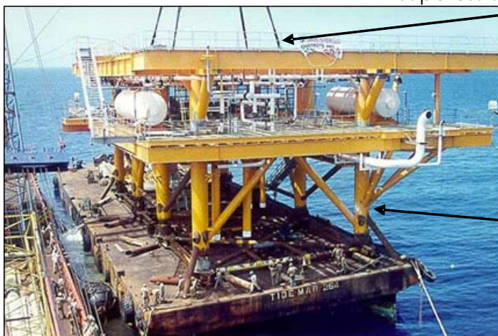
Figura 25. Separación de Chalán y superestructura para su instalación.
