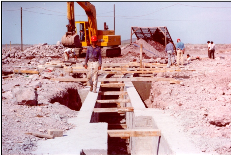
Figura 3.33. Vista donde se puede apreciar la colocación de brocales.
