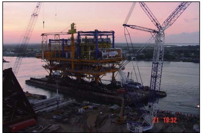
Figura 1.8. Incorporación de plataforma a la barcaza.
