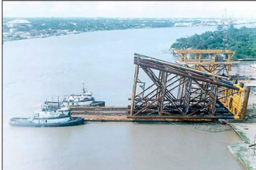
Figura 12. Salida de subestructura por correderas hacia el chalán
