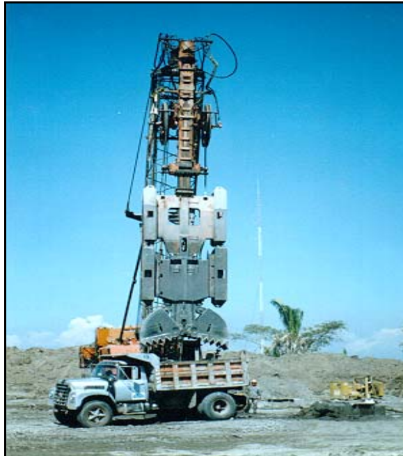
Figura 3.34. Almeja para perforación de zanja.
