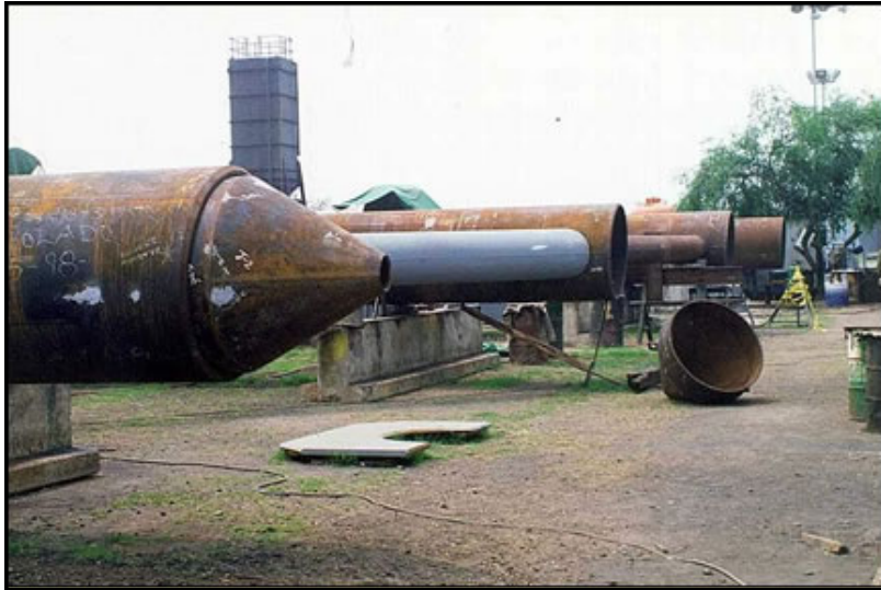
Figura 18. Instalación de conos de acoplamiento.
