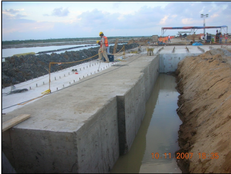
Figura 3.31. Vista de zona de cabeceras.
