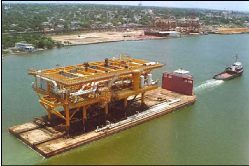
Figura 24. Salida de superestructura.
