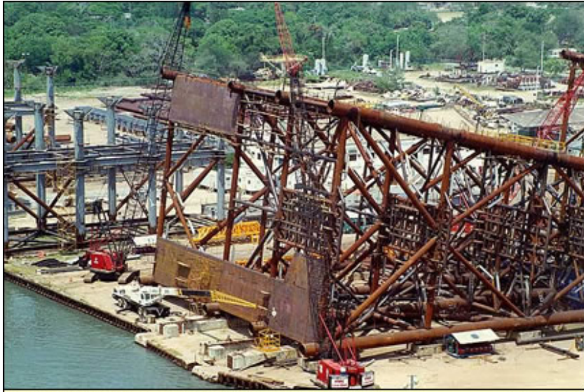
Figura 10. Instalación de placa para lecho marino en subestructura.
