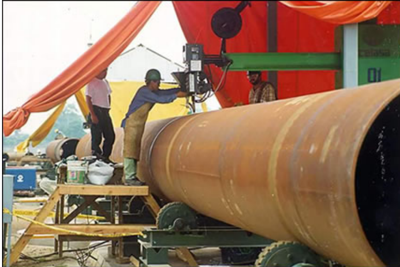
Figura 4. Aplicación de soldadura automática.
