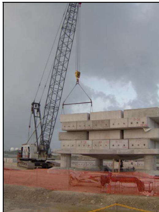
Figura 2.29. Colocación de lastres (bloques de concreto) para la prueba de carga.
