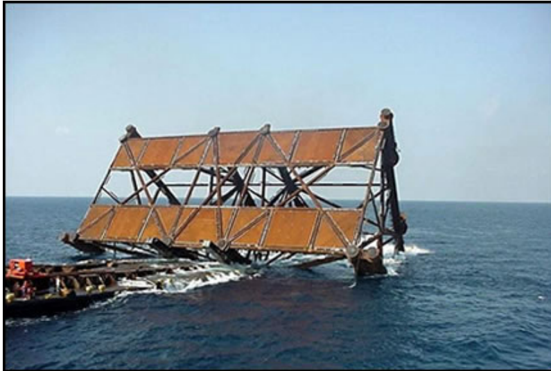
Figura 14. Lanzamiento de subestructura al mar.
