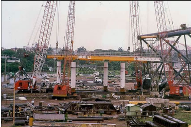
Figura 20. Colocación en columnas.
