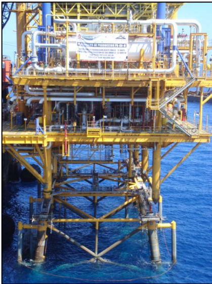
Figura 1.9. colocación de la plataforma en el Jakcet o subestructura por medio de la grúa.
