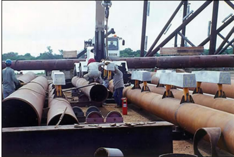
Figura 6. Instalación de protección catódica.
