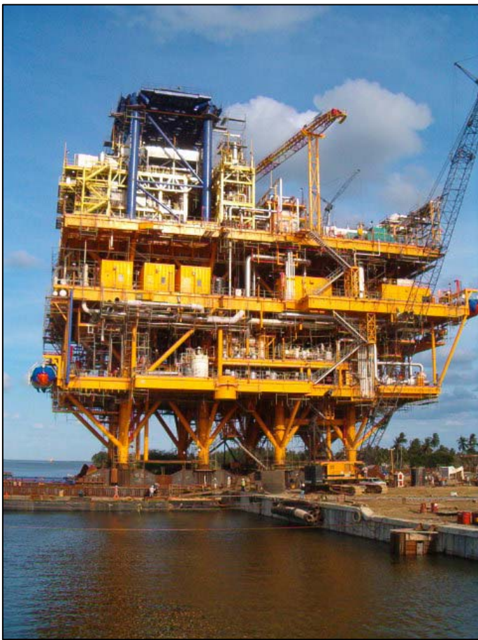
Figura 1.8. Incorporación de plataforma a la barcaza.
