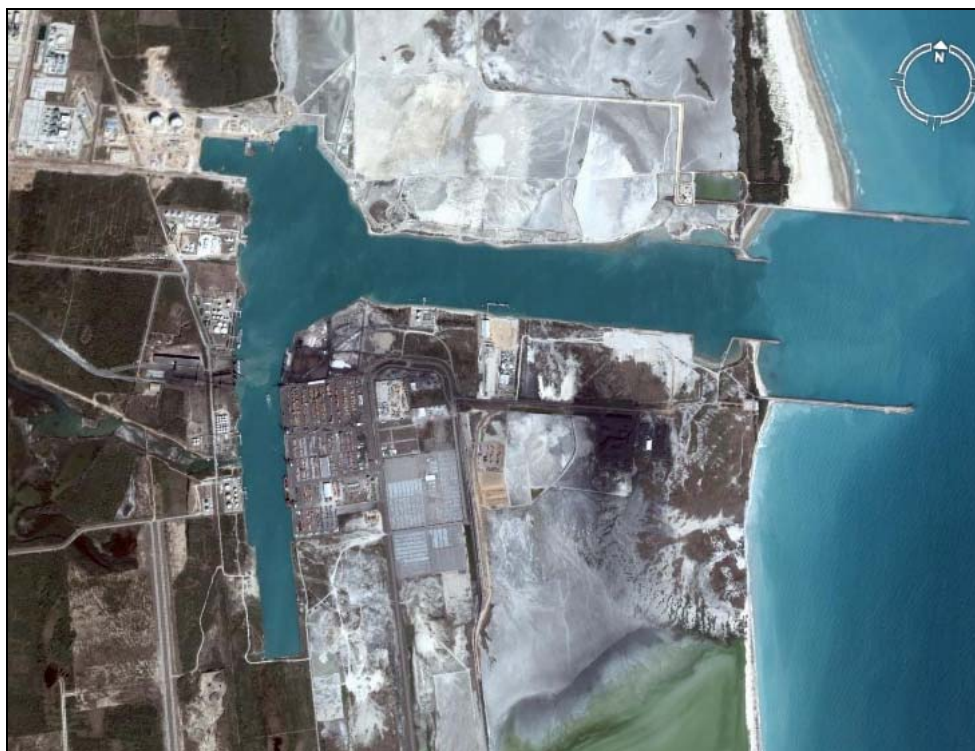
Figura 1.3. Vista aérea del Puerto de Altamira.
