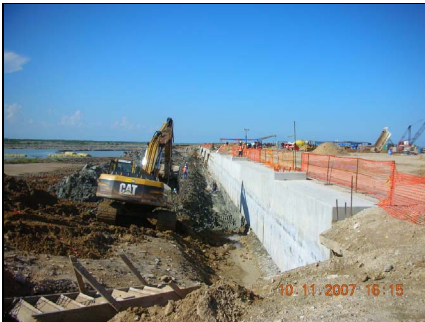
Figura 3.17. Trabajos de excavación en el frente del muro Milán.
