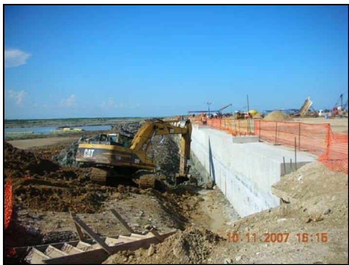
Figura 3.27. Retroexcavadora realizando el dragado.
