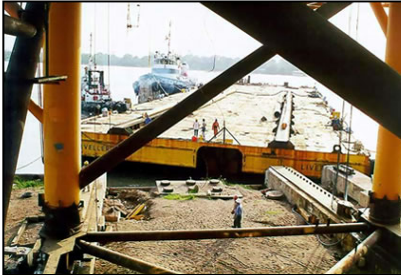
Figura 22. Alineación de correderas del Chalán con correderas de patio.
