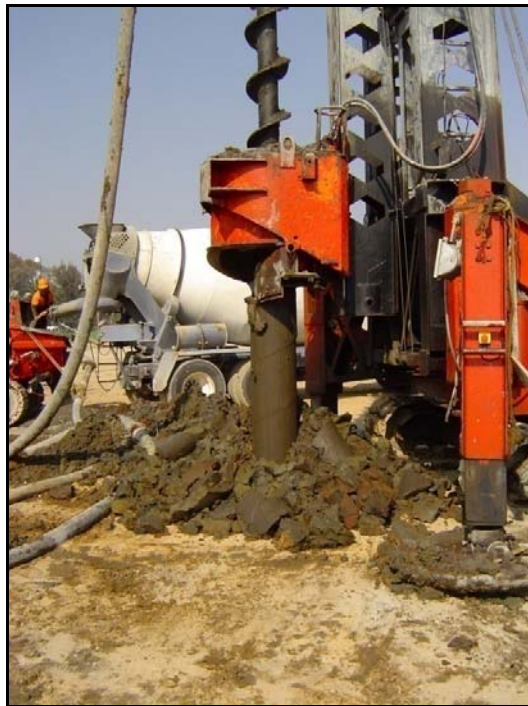
Figura 3.13. Perforación para inclusiones rígidas.
