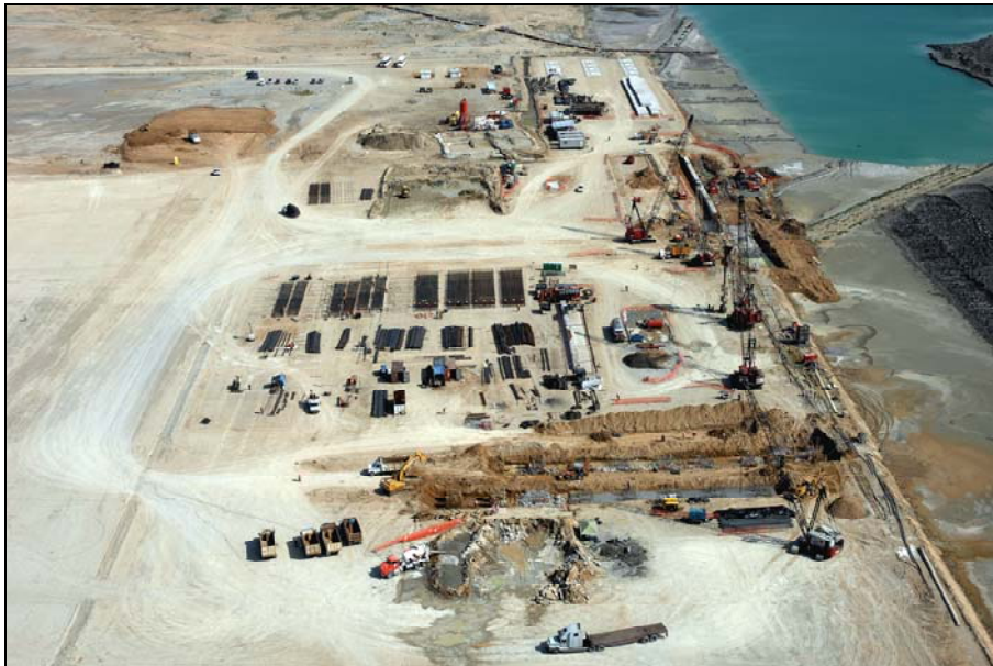
Figura 3.32. Vista aérea de la zona de construcción.
