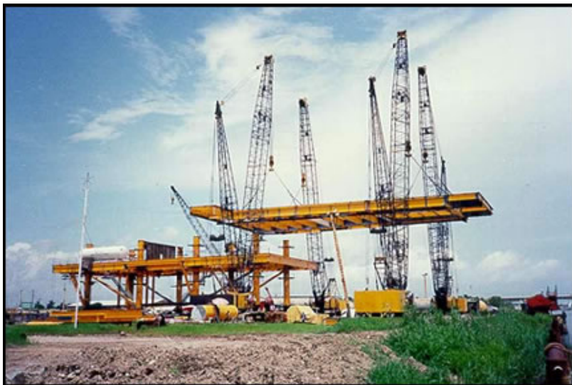
Figura 21. Izaje de cubierta superior para instalación en columnas.
