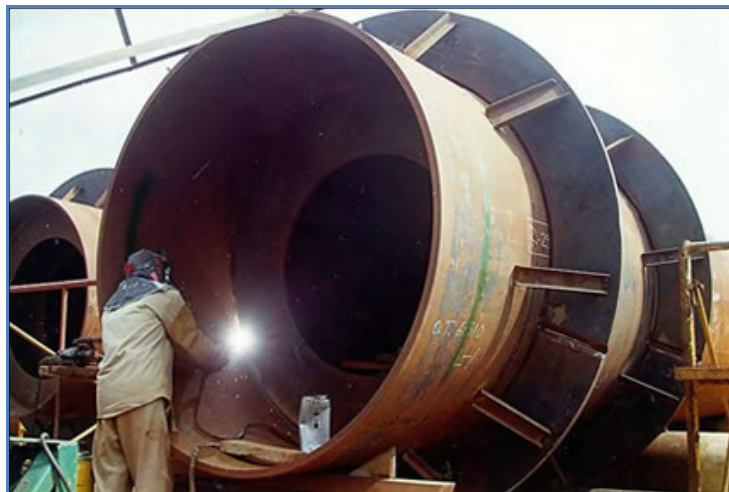
Figura 3. Aplicación de soldadura manual.
