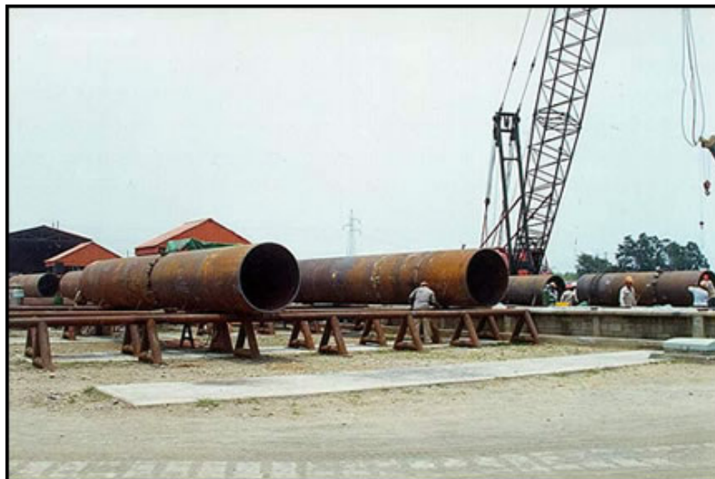
Figura 17. Armado de columnas para superestructura.
