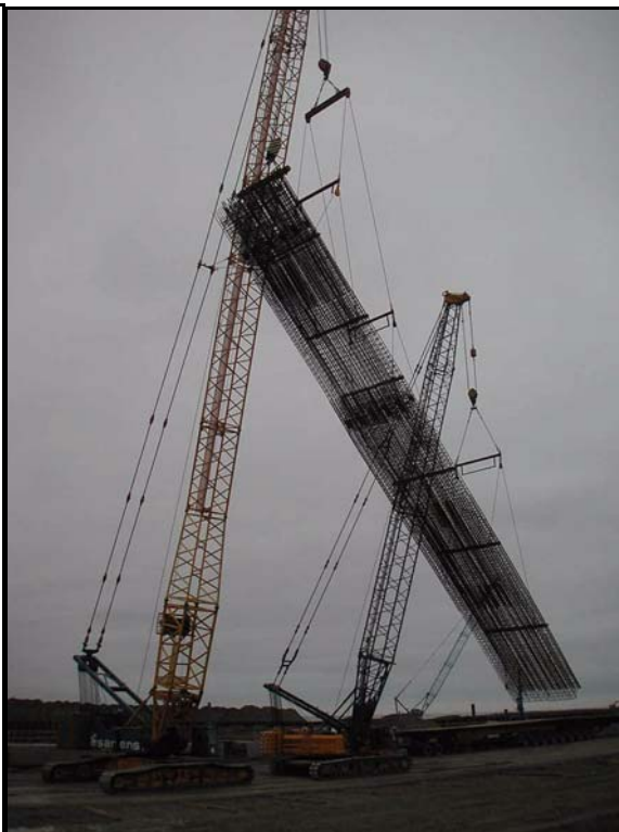
Figura 3.6. Colocación de refuerzo.
