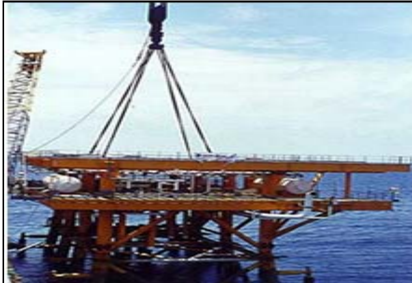
Figura 26. Acoplamiento de superestructura en subestructura.
