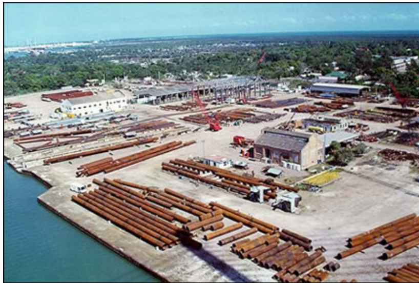
Figura 7. Armado de marcos, ejes de subestructura.
