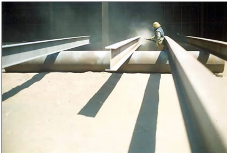
Figura 5. Aplicación de "Sand Blast" para preparación de superficie.
