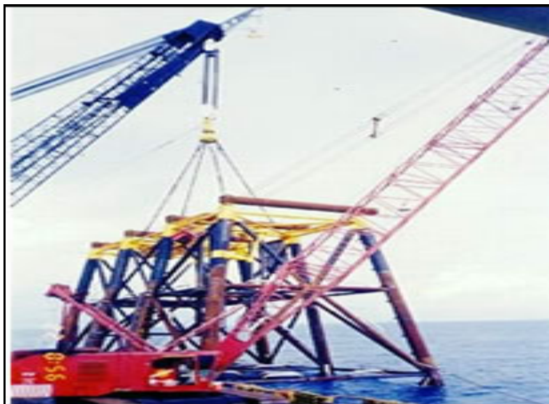
Figura 15. Recuperación de subestructura para su instalación sobre pilotes.
