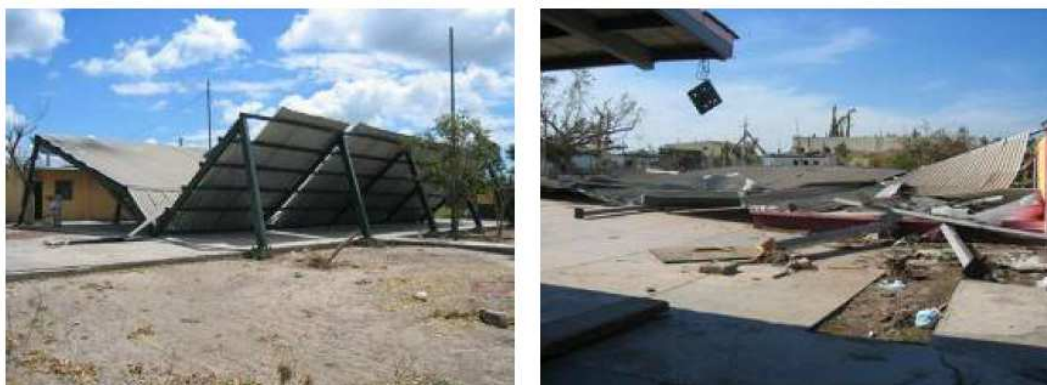
Figura II.9 fotografías de daños en techumbres de planteles estatales por el huracán Lane en 2006. 174
