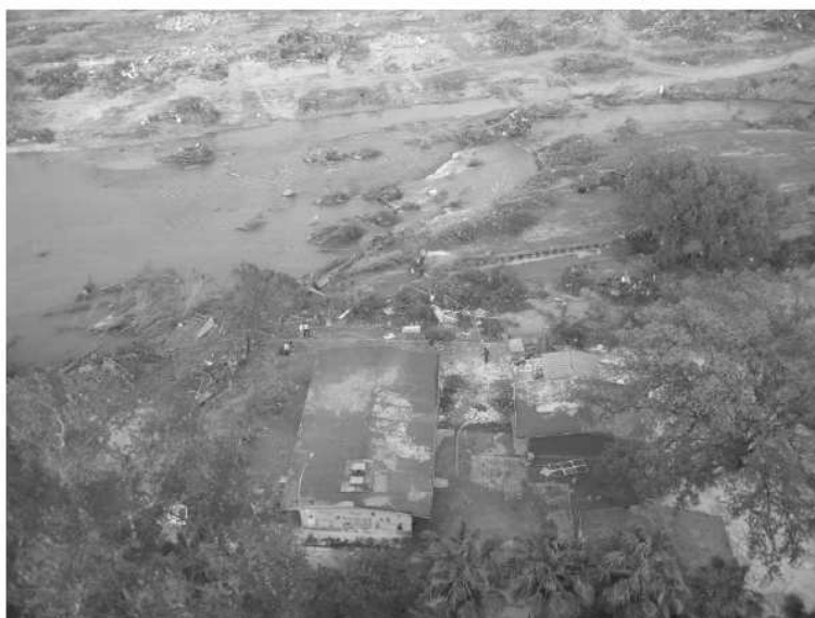
Figura II.1 Daños en un plantel educativo ubicado en las márgenes del río Escondido. 104
