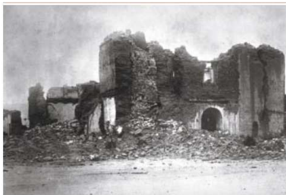
Parte exterior de una iglesia en Bavispe, Sonora dañada por el terremoto del 3 de mayo de 1887 (Mw 7.2), con epicentro cercano a ese poblado.
