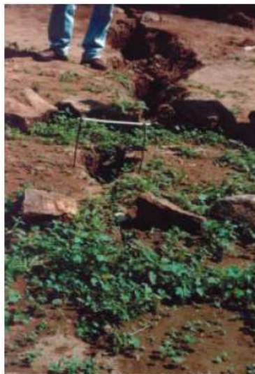
Figura I.23: Agrietamiento de la superficie del terreno natural, como consecuencia de los hundimientos diferenciales que produce la sobreexplotación de acuíferos. 27
