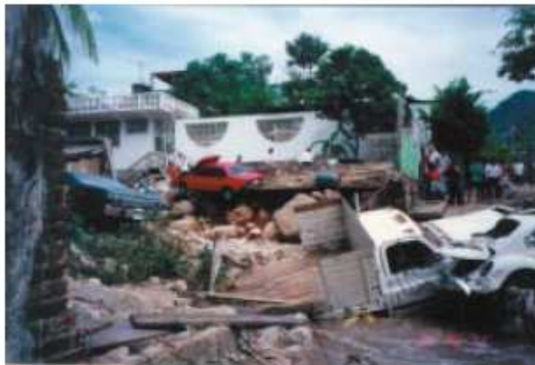
Figura I.20: Estragos causados por la socavación que se generó al paso de los flujos de lodo y escombros en la ciudad de Acapulco, durante el huracán Pauline. 24
