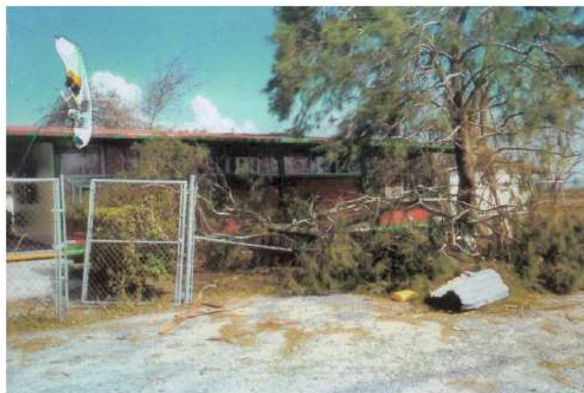
Figura II.6 Fotografía que muestra los daños por el paso de “Emily” en Tamaulipas. 131
