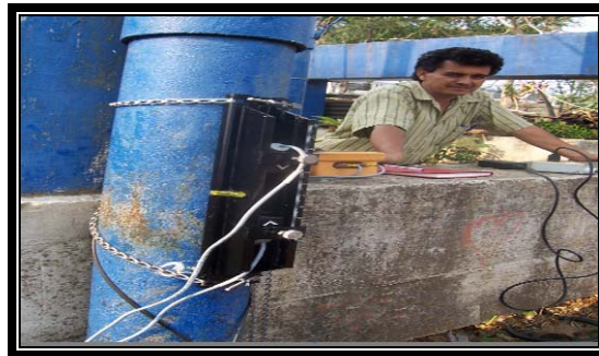
Foto 19, 20 y 21.- Mediciones en la tubería de 6" que sube al tanque elevado.
