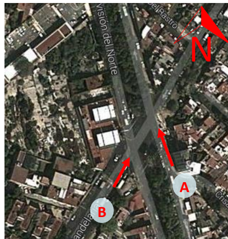
Figura 8.21 Vista aérea, intersección Eje 10 con Av. División del Norte. Fuente: Google Maps (2014)
