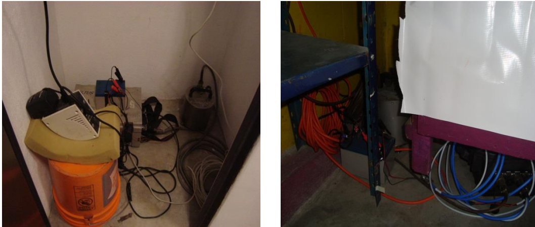
Figura 4.27. Instalación de las estaciones temporales, de lado derecho THAM y de lado izquierdo THPE.
