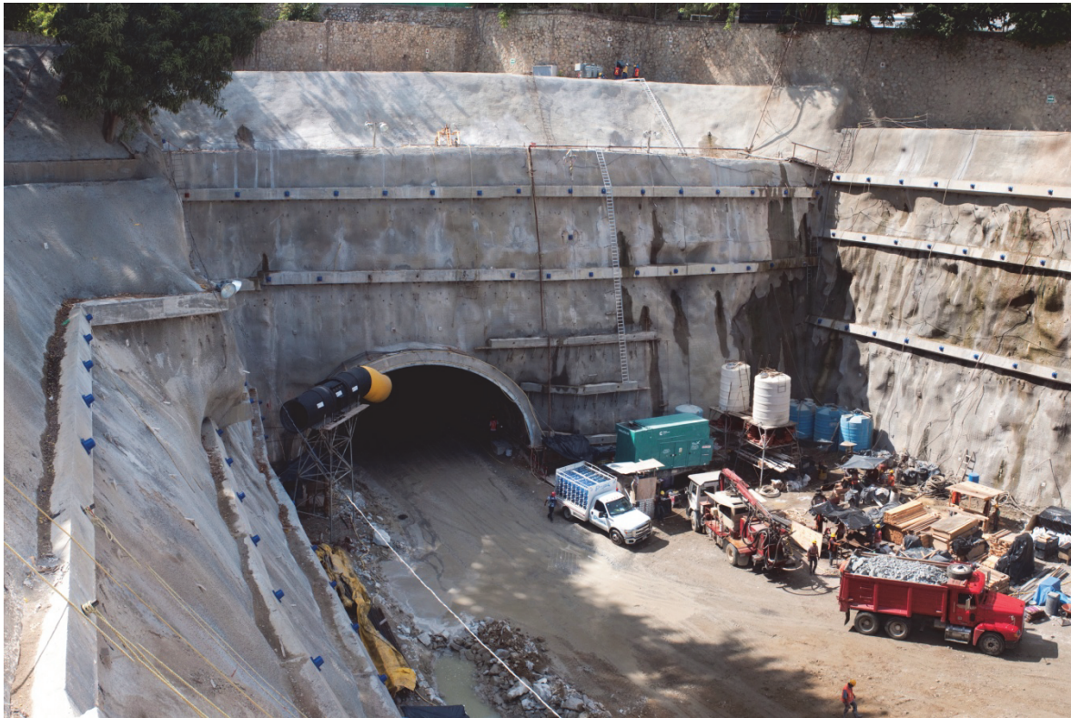
Figura 29. Portal Brisamar del "Acatúnel".
