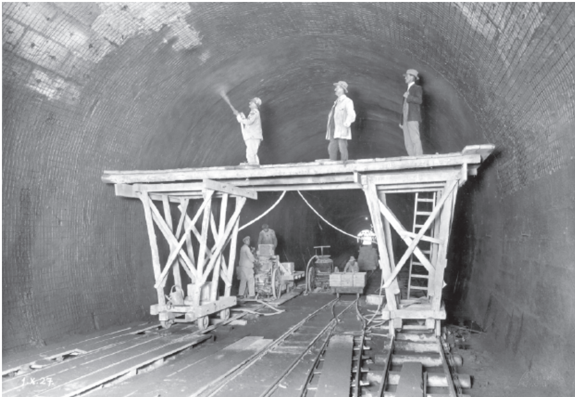
Figura 3. Concreto lanzado en el túnel Ulmberg en Zúrich, Suiza, 1927. Imagen extraída de Kovári, (2003).
