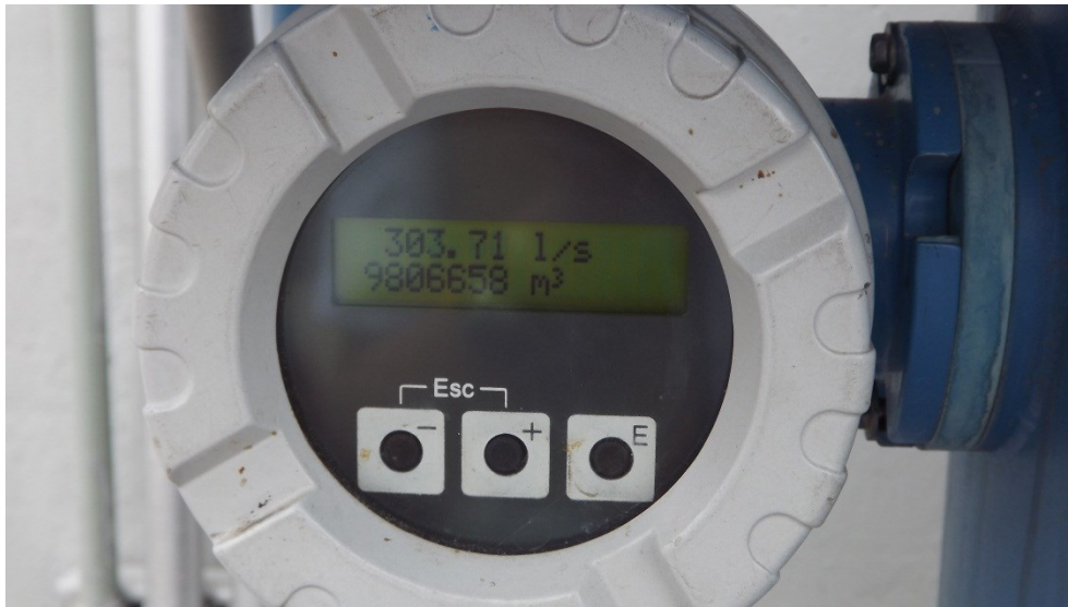
Figura 8.5 Caudal de llegada a la planta
