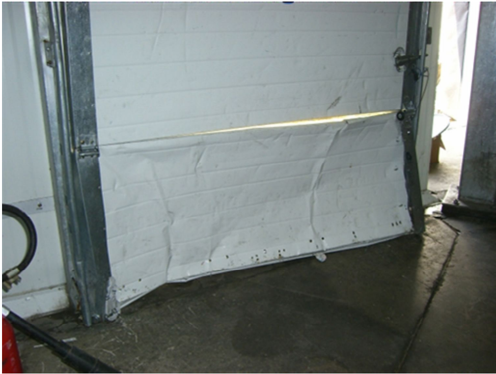
Foto 6. Otro daño clásico ocasionado por los montacargas en las puertas overhead
