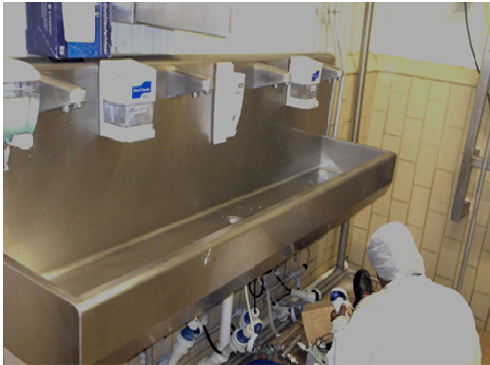
Foto 20. Instalación de lavabo de acero inoxidable de cuatro puestos, en el Mantenimiento Modificado de las aduanas sanitarias
