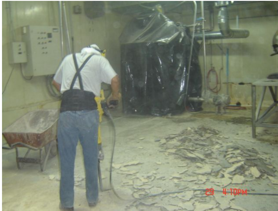
Foto 2. Demolición de área dañada, para sustituir loseta antiácida
