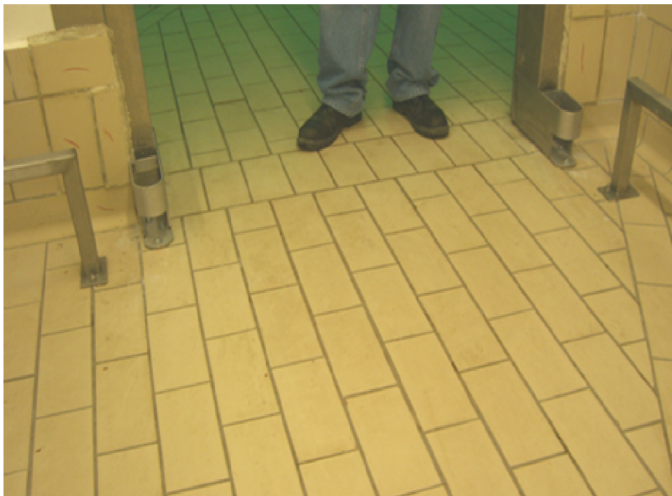
Foto 4. Piso recubierto con loseta antiácida totalmente terminado
