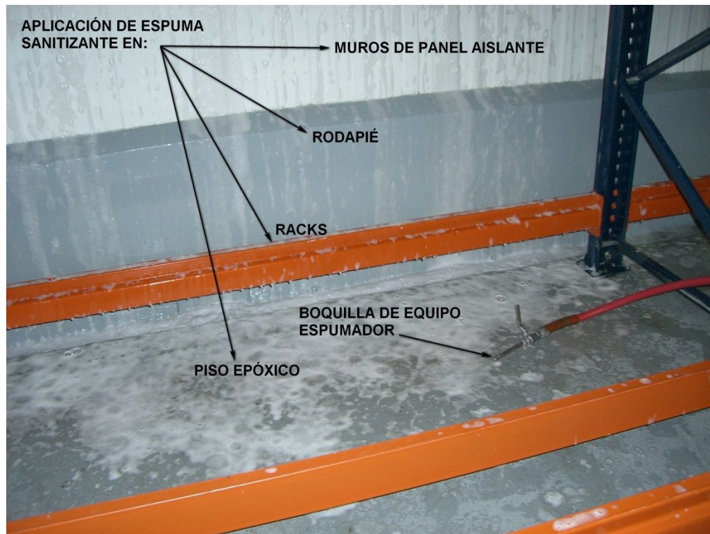
Foto 33. Sanitización a base de espuma germicida y virucida, como proceso final de la limpieza
