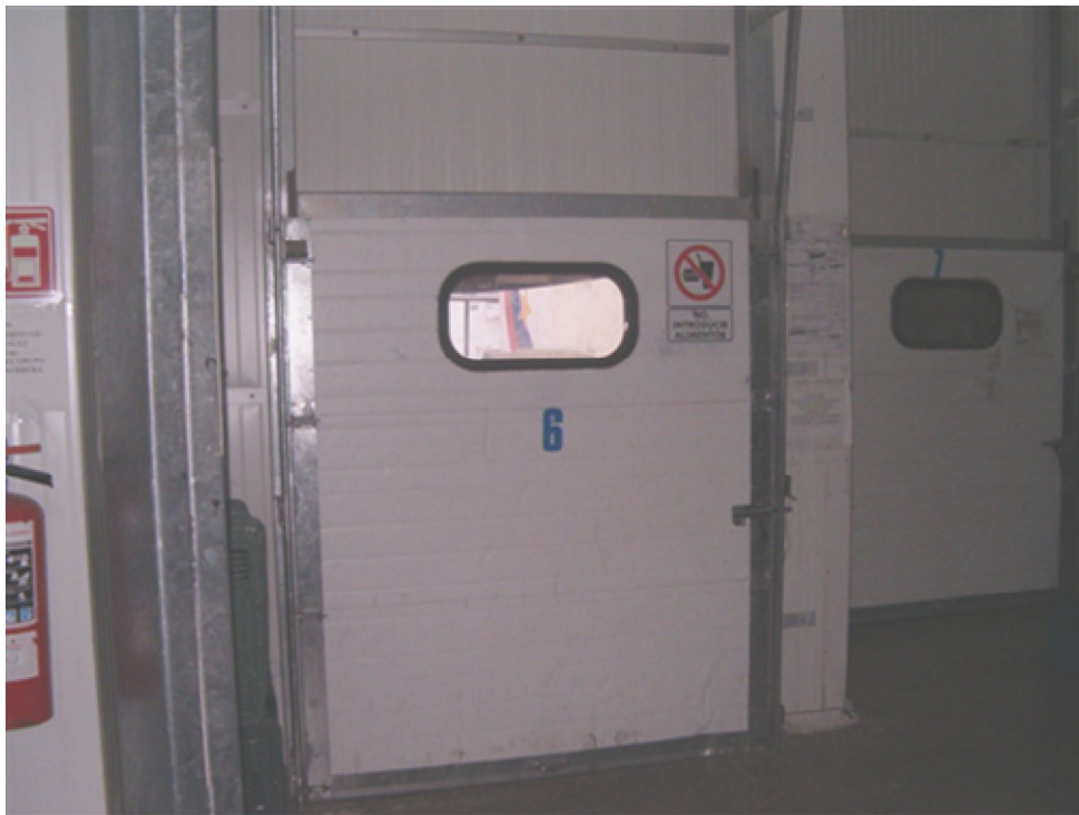
Foto 6. Otro daño clásico ocasionado por los montacargas en las puertas overhead
