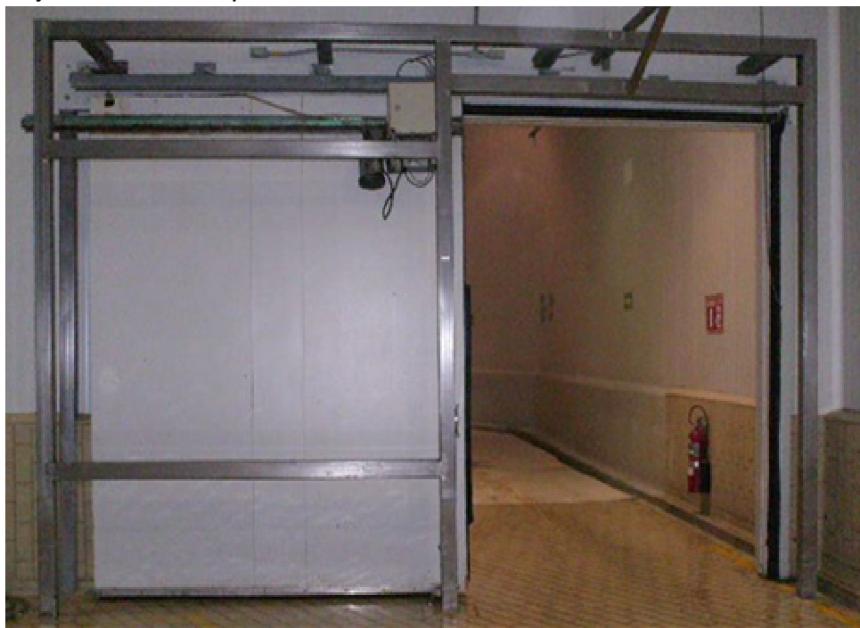
Foto 12. Protección de puerta corrediza automática, a base de un doble marco de ptr de acero inoxidable calidad sanitaria t-304
