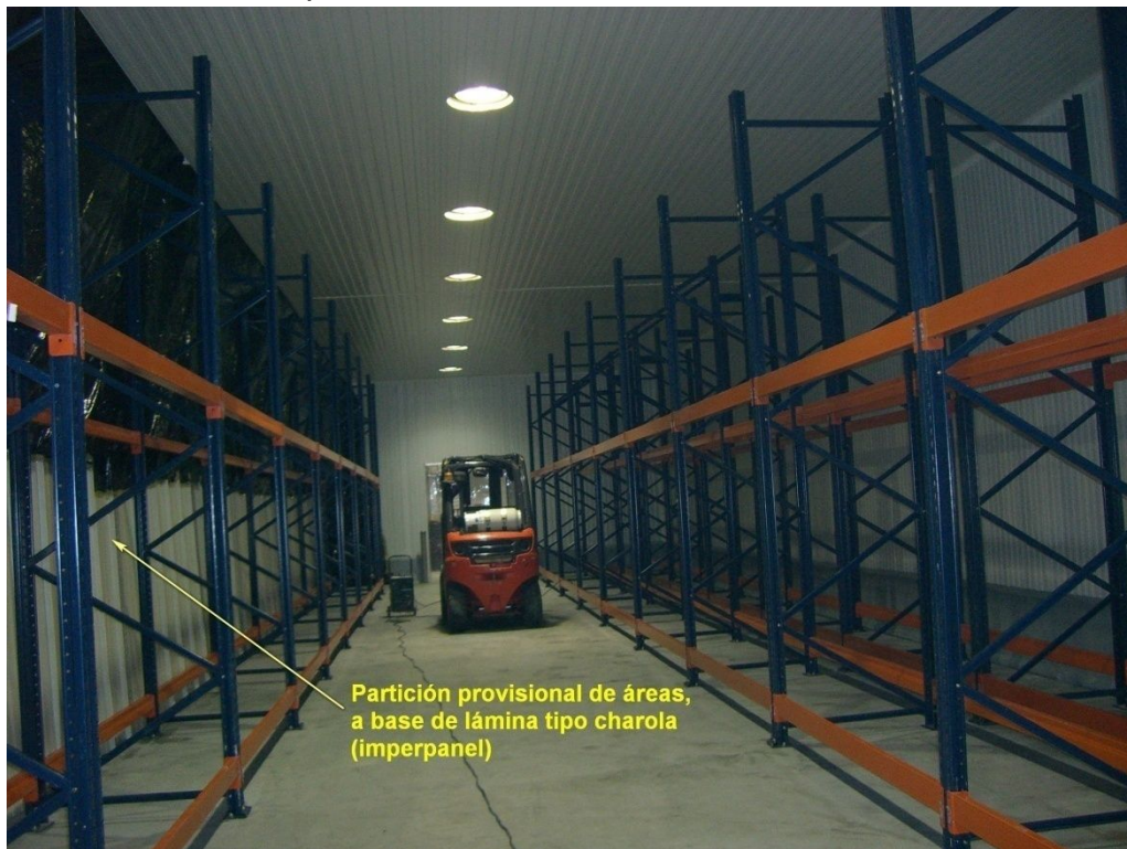
Foto 32. Las particiones provisionales, permitieron reducir el riesgo de contaminación de los productos almacenados, mientras se realizaba el proyecto de Mantenimiento
