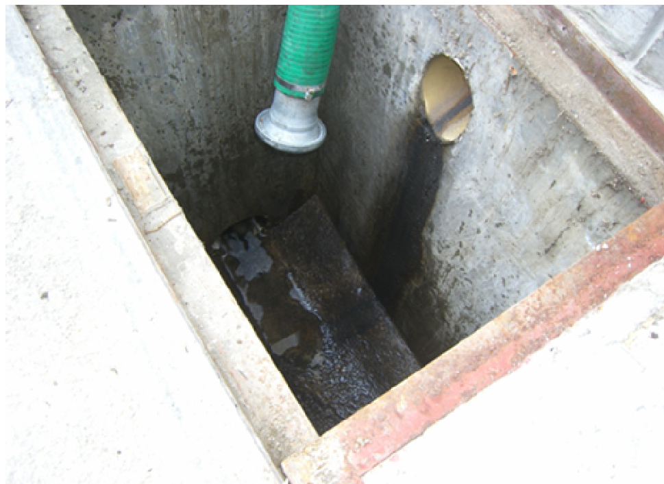
Foto18. Registro totalmente desazolvado y limpio de residuos sólidos
