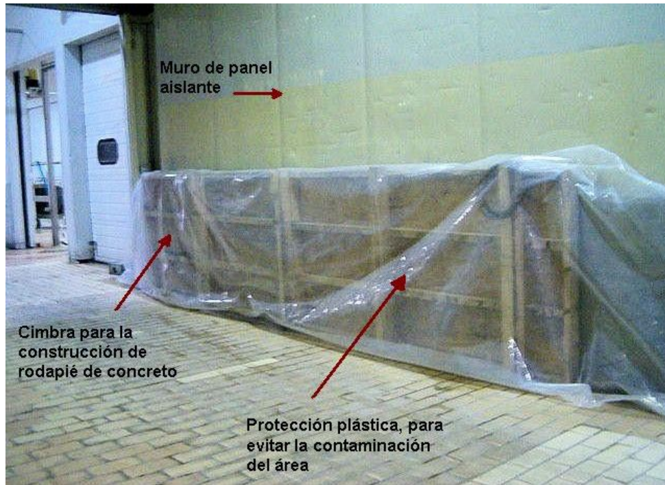
Foto 11. Protección de multypanel por medio de rodapié de concreto reforzado, que posteriormente será recubierto con loseta antiácida
