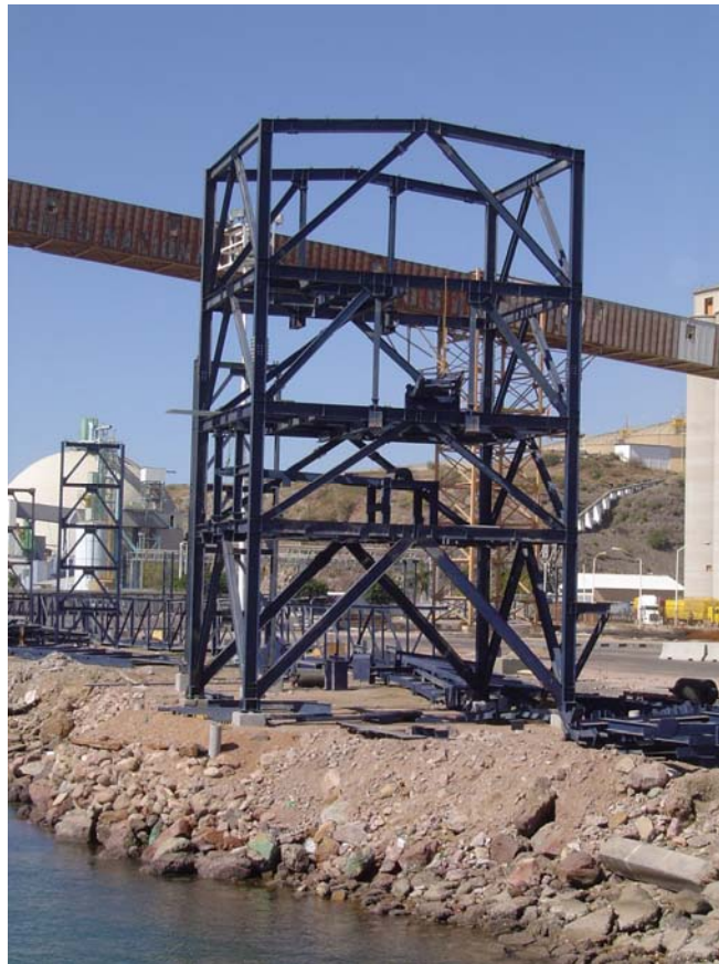
Montaje de torre de transferencia TT-4.
