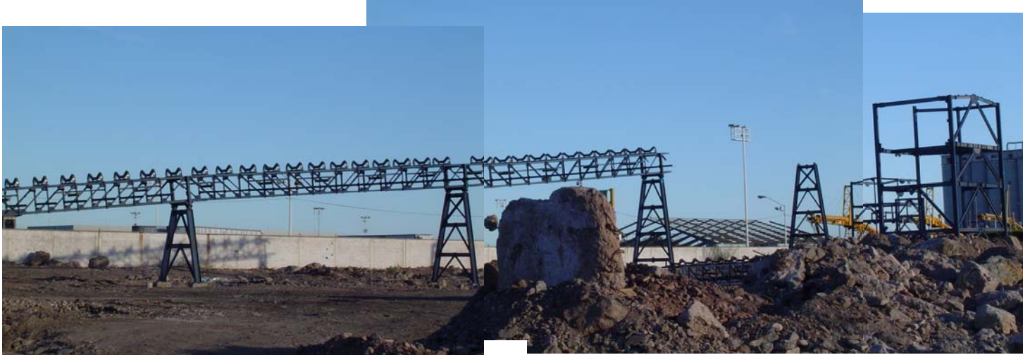
Montaje de transportador TB-07 en su trayectoria hacia la torre de transferencia TT-1.
