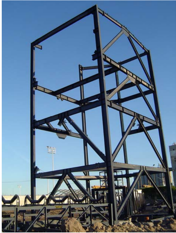
Inicio de montaje de torre de transferencia TT-1.
