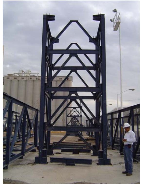
Elevación de caballete ( izquierda ) y torre auxiliar ( derecha ) sobre la trayectoria del transportador TBS-02.
