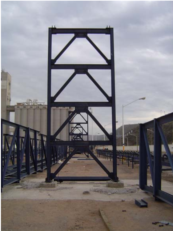
Elevación de caballete ( izquierda ) y torre auxiliar ( derecha ) sobre la trayectoria del transportador TBS-02.
