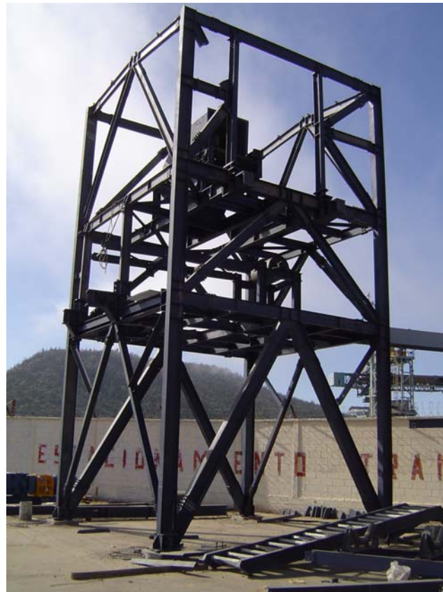
Montaje de torre de transferencia TT-3.
