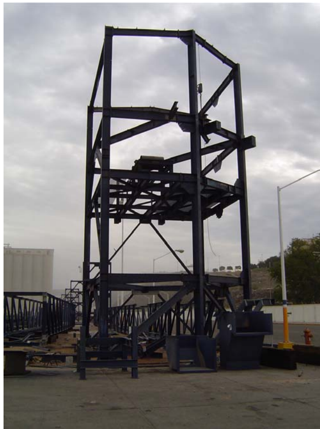
Inicio de montaje de torre de transferencia TT-1.
