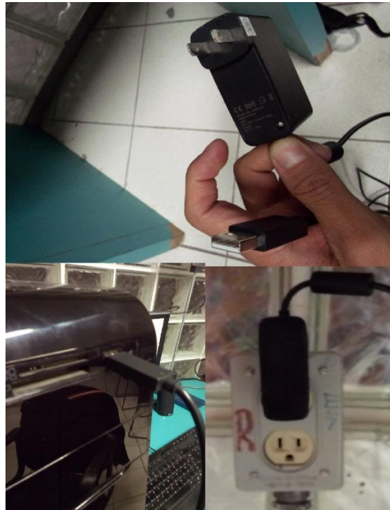
Figura a-7 Terminales y conexiones.
