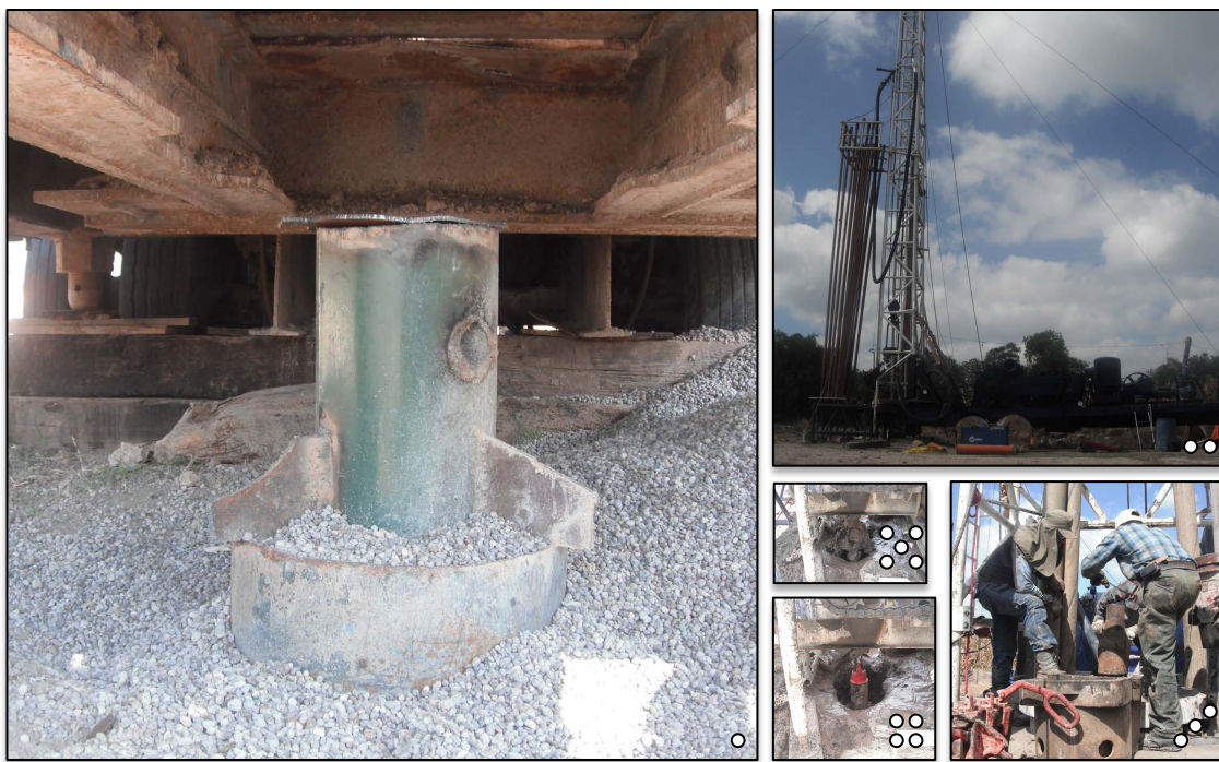
○ Pozo re perforado y equipado para prueba de bombeo ○ ○ Entubando el pozo para prueba de bombeo (Aforo) ○ ○ Entubando el pozo para prueba de bombeo (Aforo) ○ ○ ○ ○ Re perforando
