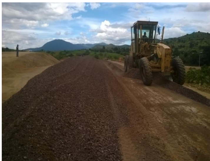
Figura 4.3.1.9 Tendido de material para base hidráulica con motoconformadora.
