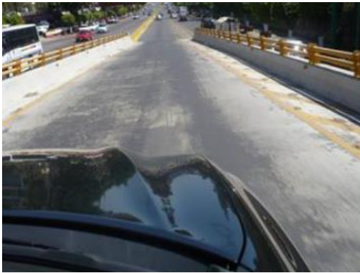
Figura 2.5.1.7 Pulido de superficie.
