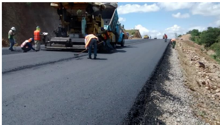
Figura 4.3.3.2 Control y monitoreo de temperaturas para el tendido de carpeta
