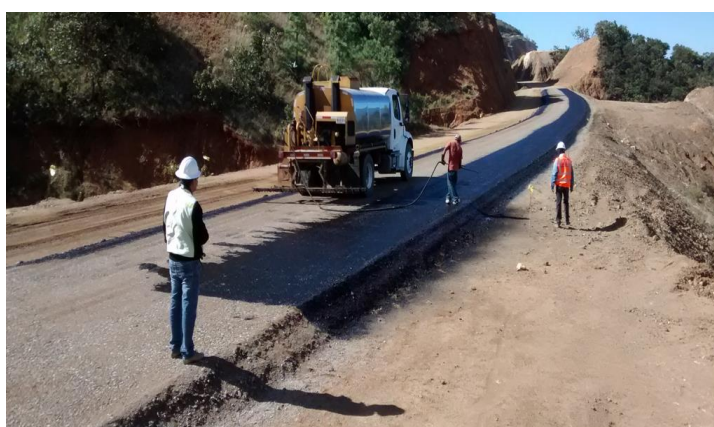
Figura 4.3.2.4 Realizando el bacheo con aspersores manuales.
