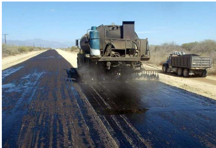
Figura 4.3.4.3 Tendido del sello por medio de la macrosello.
