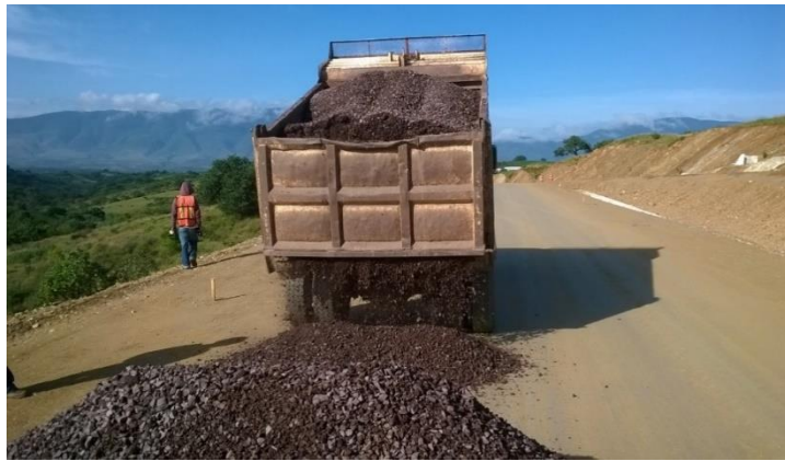
Figura 4.3.1.7 Arribo y vaciado de los camiones con el material para base hidráulica.
