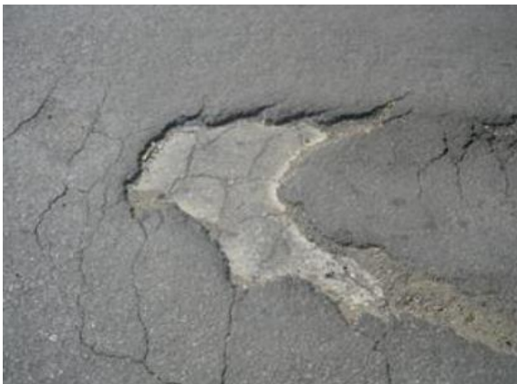
Figura 2.5.1.17 Grietas parabólicas.
