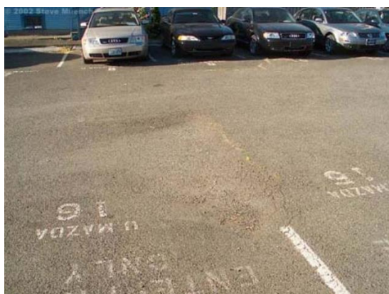
Figura 1.5.2.2 Elevaciones y hundimientos.
