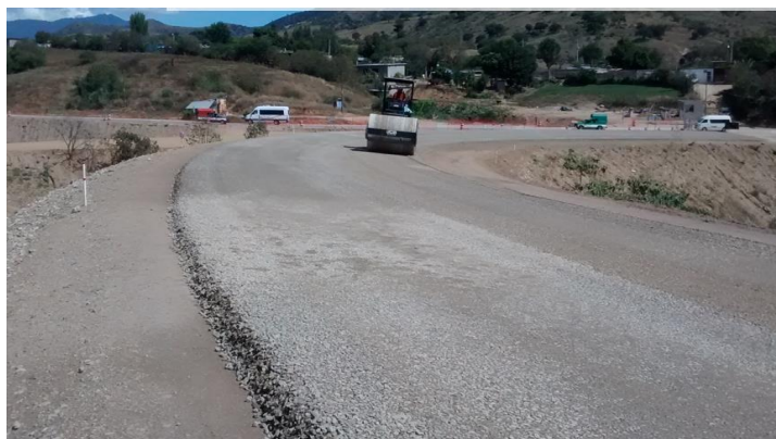
Figura 4.3.1.12 Compactación de base hidráulica en curva.
