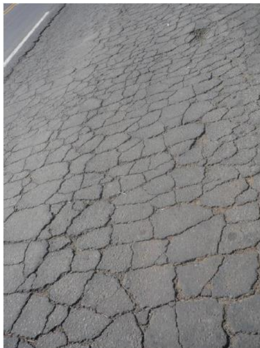
Figura 2.5.1.2 Desintegración.
