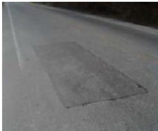
Figura 2.5.1.21 Reparación de la estructura del pavimento.
