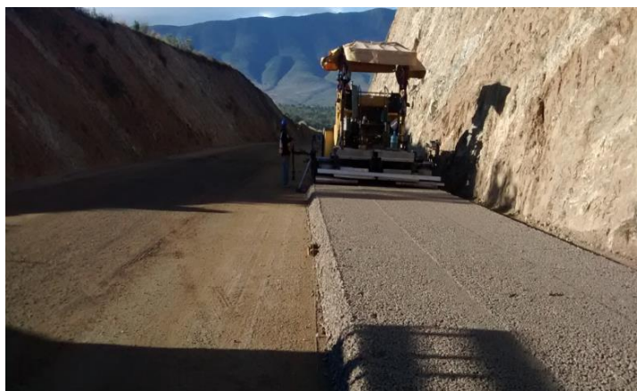
Figura 4.3.1.15 Pavimentadora sobre orugas.
