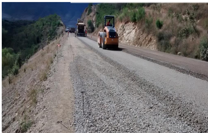
Figura 4.3.1.11 Compactación de base hidráulica.
