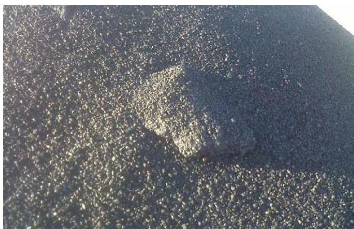
Figura 4.3.4.1 Sello premezclado de tipo 3-E.
