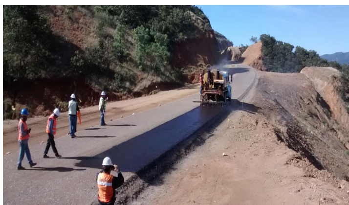
Figura 4.3.2.3 Tendido de riego de impregnación con petrolizadora.
