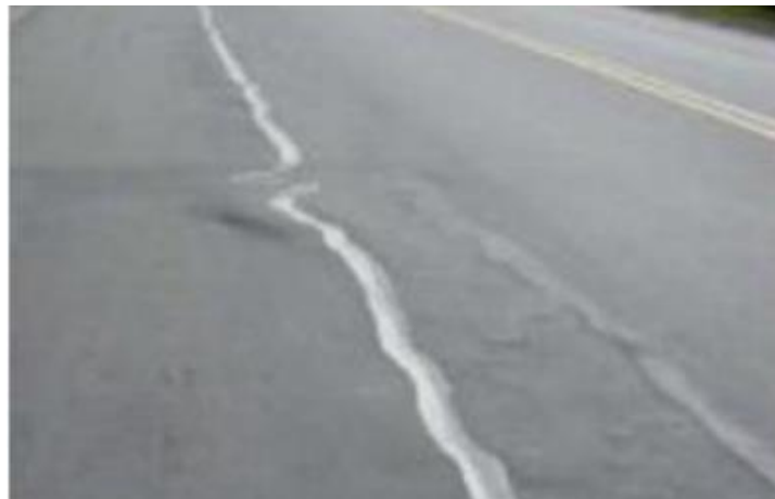
Figura 2.5.1.10 Ondulaciones transversales.
