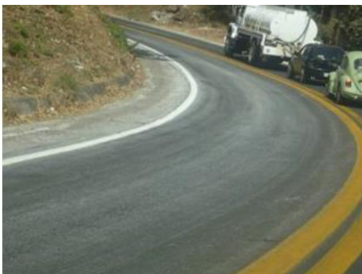
Figura 2.5.1.8 Expulsión de finos y afloramiento de humedad.
