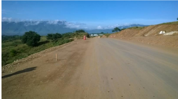
Figura 4.3.1.6 Vista de la carretera en fase constructiva base.
