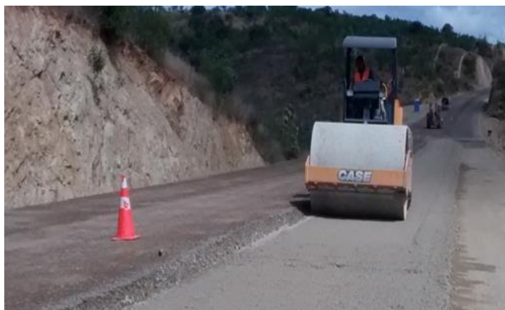
Figura 4.3.1.14 Vibrocompactadora.
