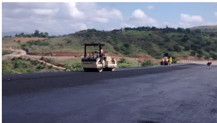
Figura 4.3.3.3 Compactación de carpeta asfáltica con rodillo.
