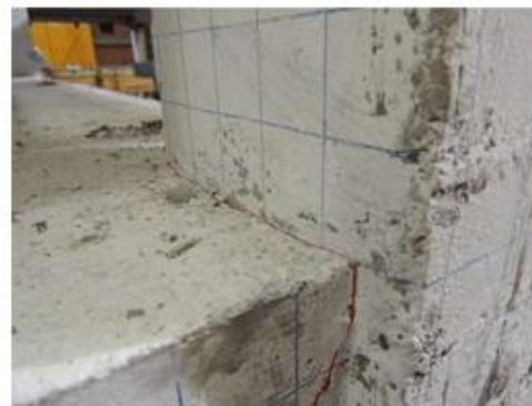
d) Firme en piso 1
