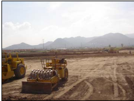
Fig. 5.4 Trazo, desmonte, despalde y nivelación de terreno a construir.
