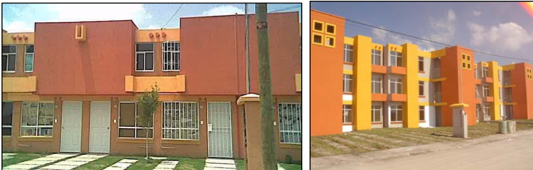
Fig. 5.2 Viviendas de interés social, Tecamác, Estado de México, vivienda de 2 niveles (izquierda), vivienda de 3 niveles (derecha)
