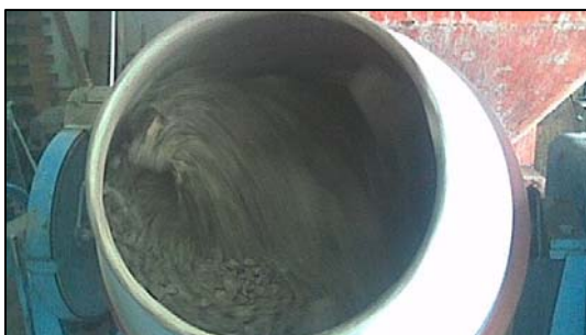
Fig. 2.1 Mezclado de concreto en revolvedora.
