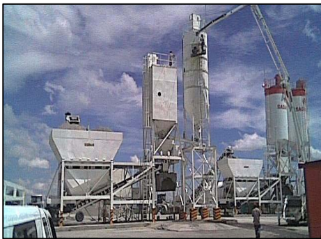
Fig. 3.1 Planta de fabricación de concreto
