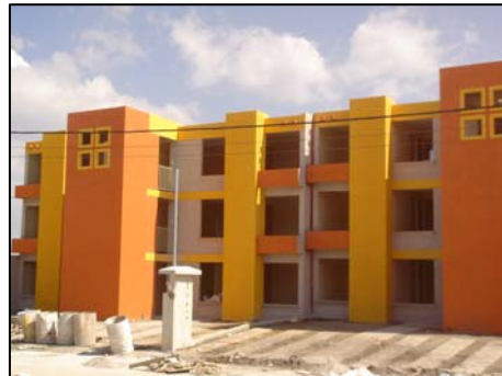
Fig. 5.9 Vivienda de interés social concluida
