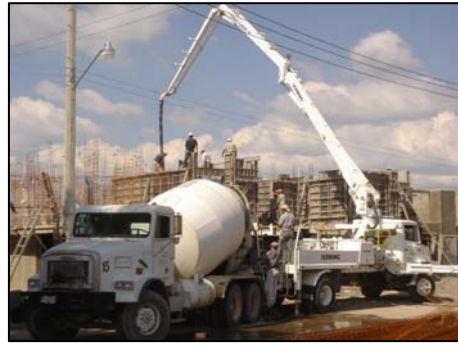
Fig. 5.7 Colocación del concreto en muros de espesor de 10 con cimbra metálica.
