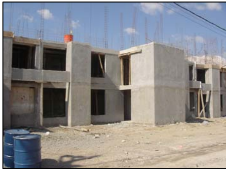
Fig. 5.8 Obra negra de conjunto habitacional
