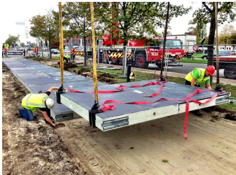
Figura 6.10 Instalación de SolaRoad (deepresource.wordpress.com)
