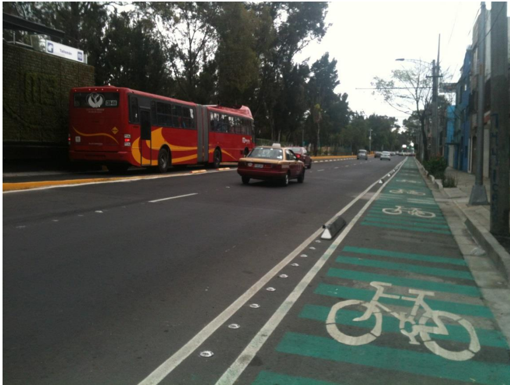
Figura 6.2.10 Infraestructura para varios tipos de transporte en Av. Eduardo Molina (huellasenelpavimento.wordpress.com)
