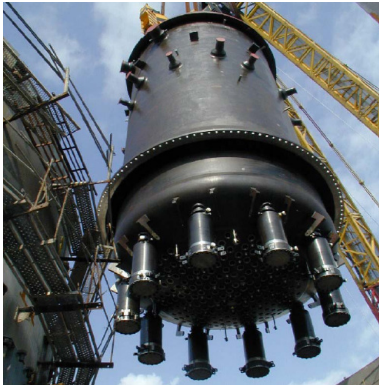
Figura 1-17 Vasija del ABWR con las RIP's [6]
