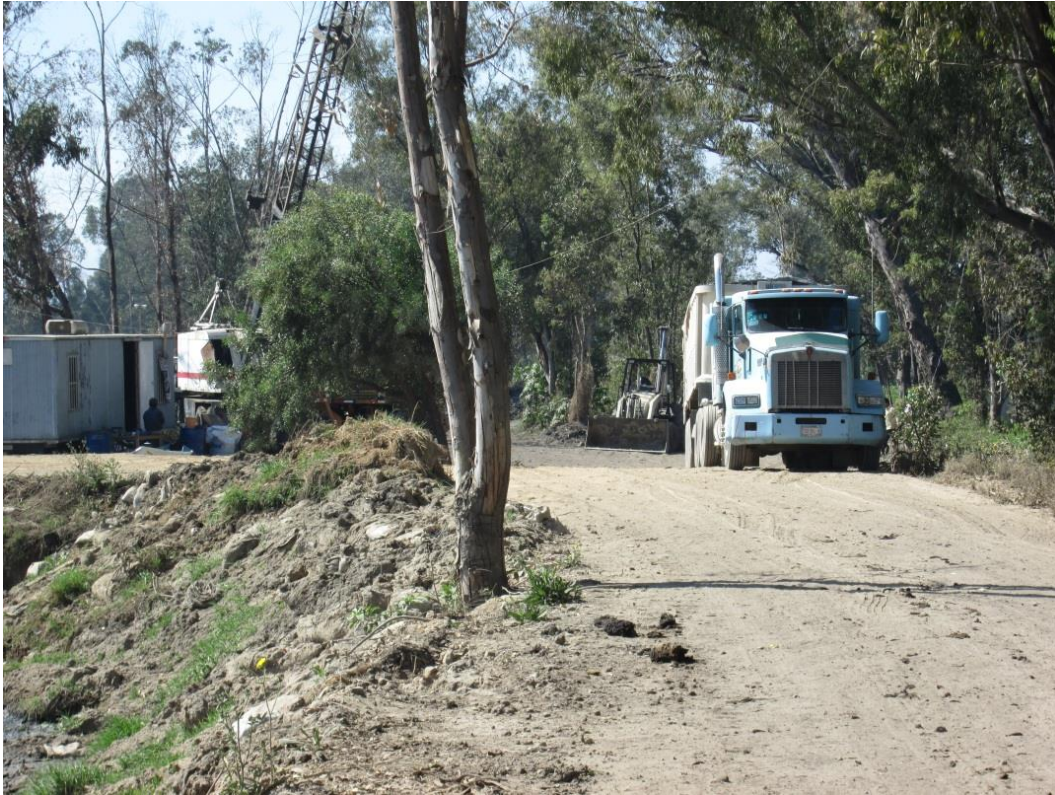
Imagen 33. Salida de camiones hacia el tiro.
