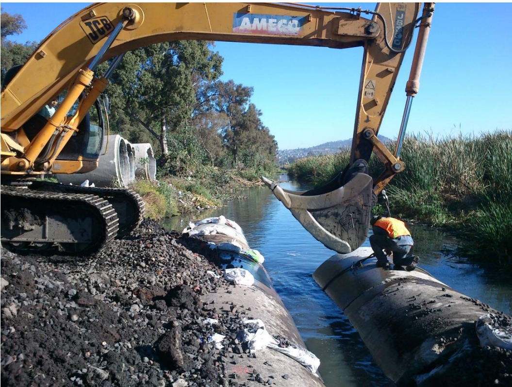
Imagen 8. Colocación de segunda línea de tubería sobre canal de llamada.
