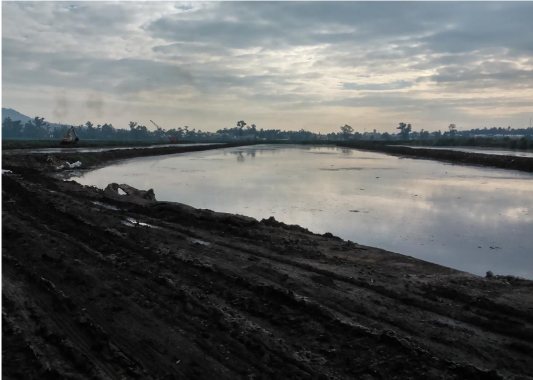
Imagen 42. Condiciones del vaso después de realizar el desazolve (Sección desazolvada entre peine 4 y 5)
