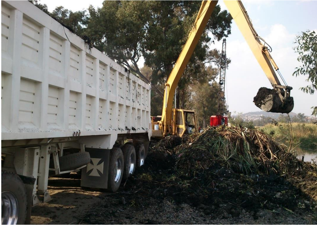
Imagen 22. Carga de camiones con retroexcavadora para traslado a zona de deshidratación.
