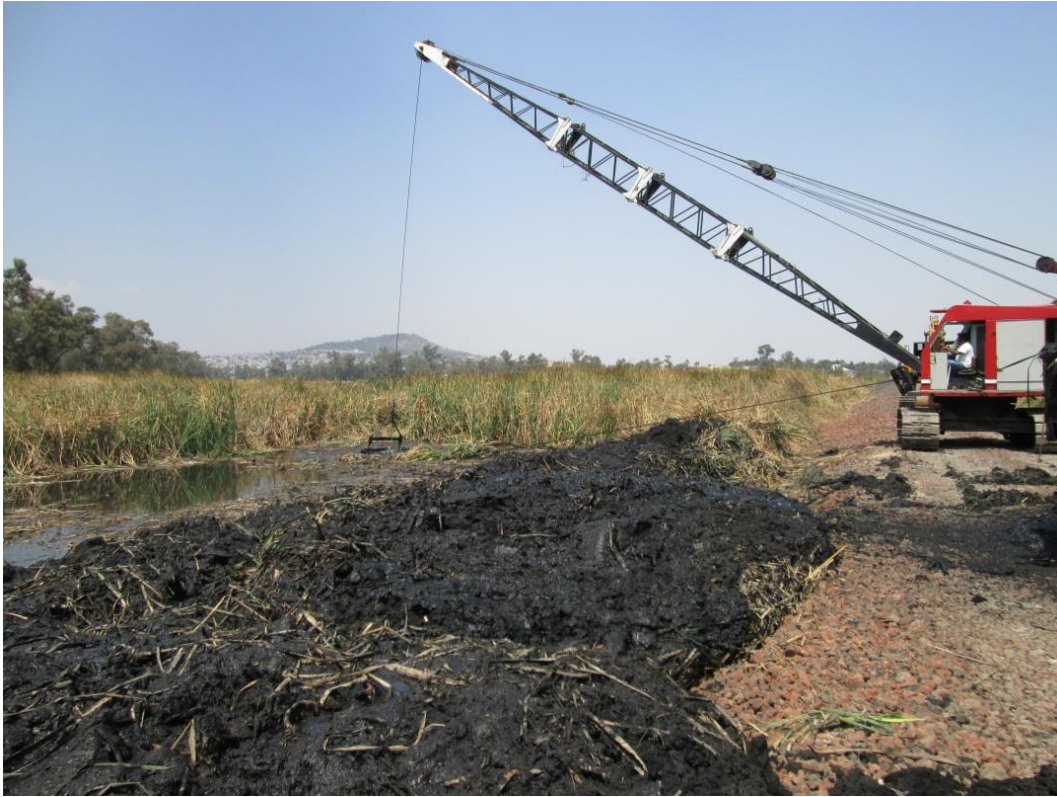
Imagen 16. Extracción de material de azolve con draga.
