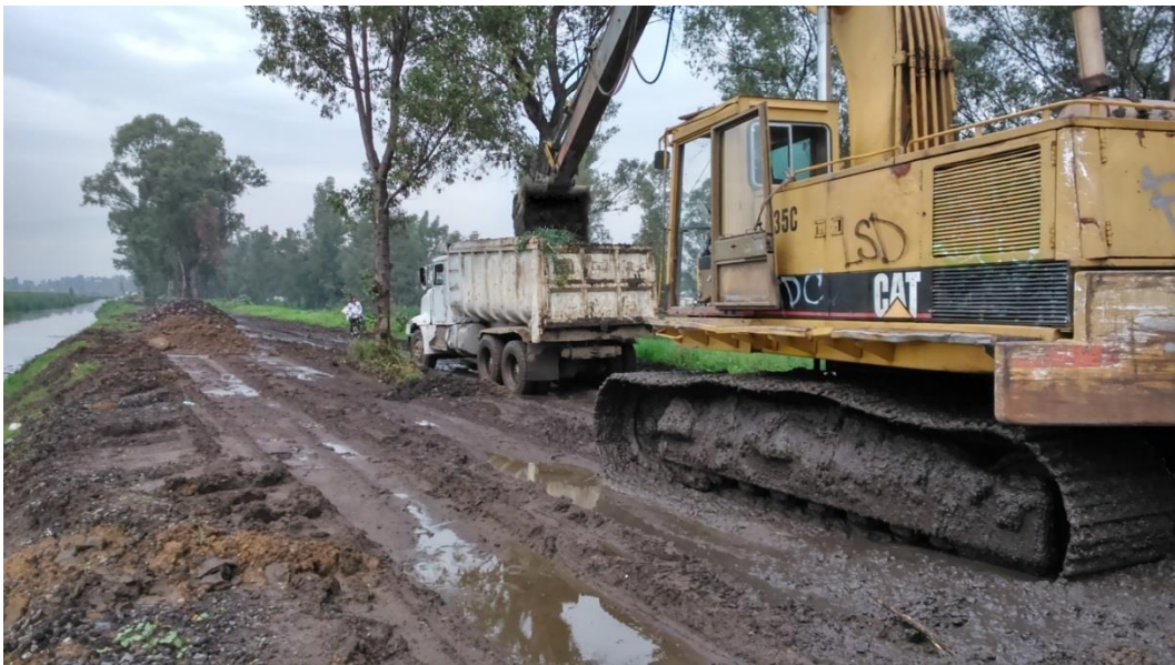
Imagen 36. Carga de lodo en camiones
