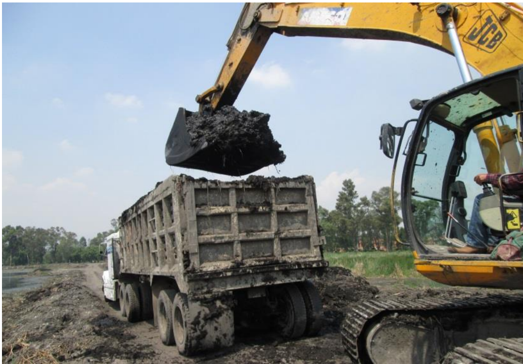
Imagen 32. Carga de camiones en zona de deshidratación.
