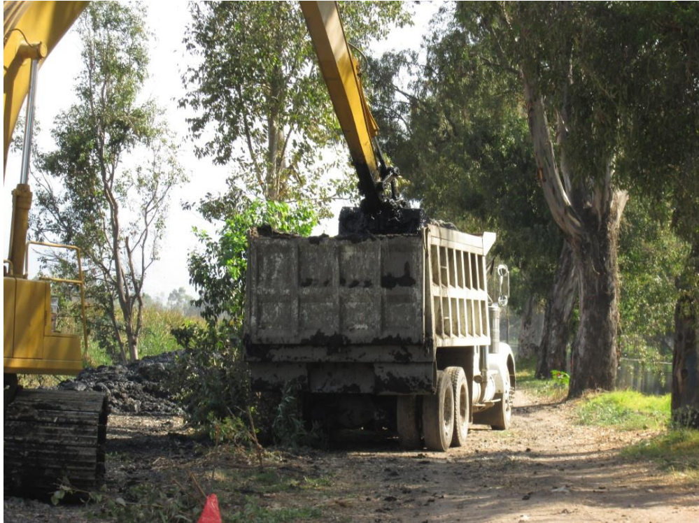
Imagen 23. Carga de camiones con retroexcavadora para traslado a zona de deshidratación.
