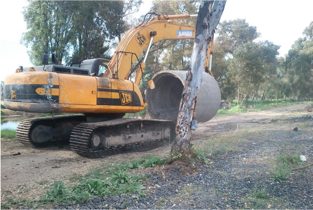
Imagen 5. Acarreo de tubería.
