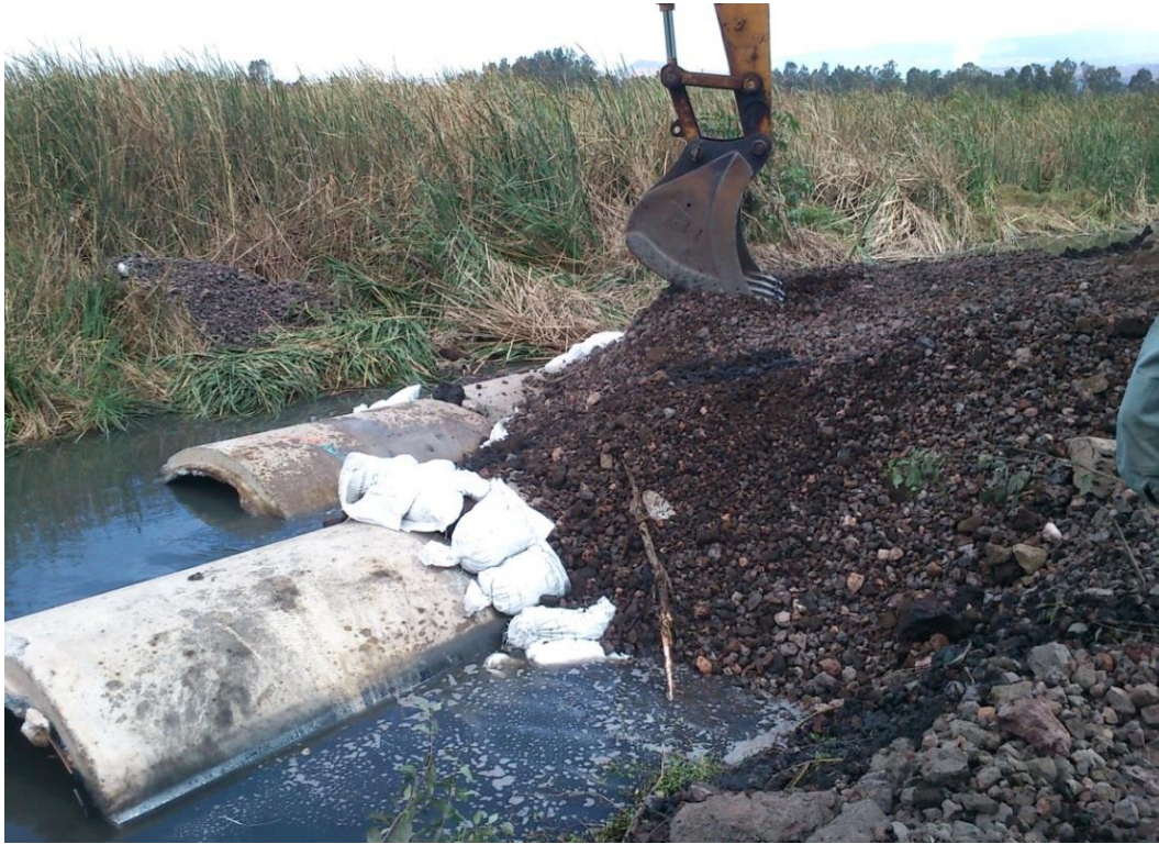
Imagen 9. Colocación de balastro sobre tuberías.
