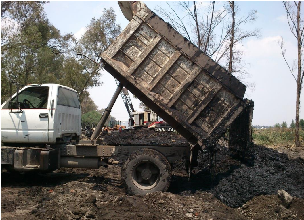
Imagen 25. Descarga de material en zona de deshidratación.
