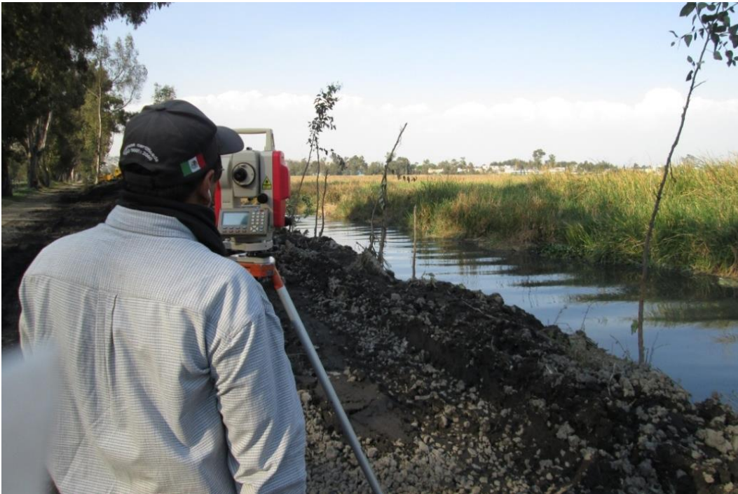
Imagen 1. Levantamiento de poligonal con estación total
