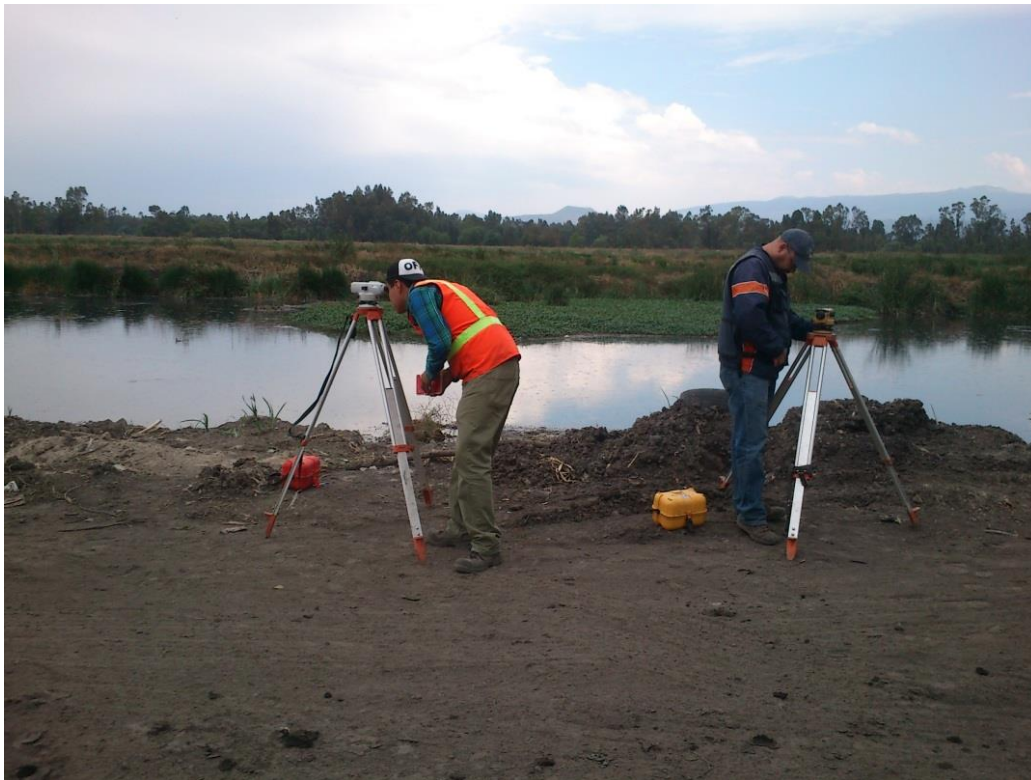
Imagen 29. Verificación de rasante de proyecto.
