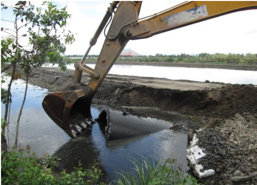
Imagen 38. Retiro de tuberías de concreto de canal de llamada
