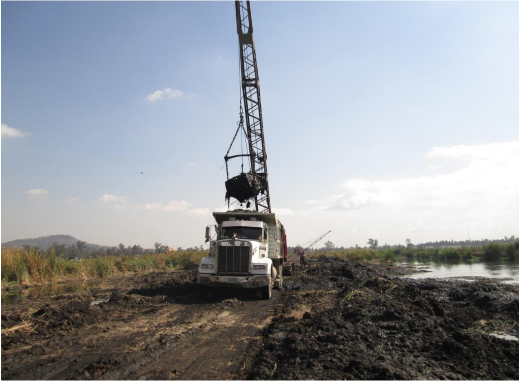
Imagen 18. Carga de camiones para traslado a zona de deshidratación.
