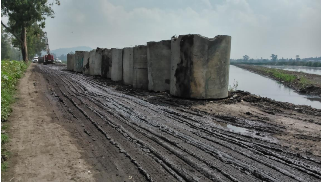
Imagen 39. Colocación de tuberías sobre bordo
