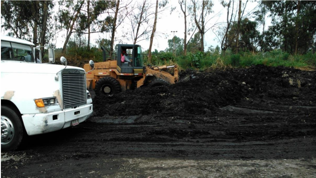
Imagen 31. Carga de camiones en zona de deshidratación.
