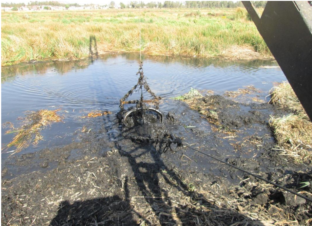
Imagen 17. Extracción de material de azolve con draga.
