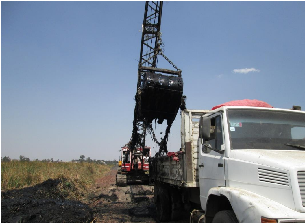
Imagen 19. Carga de camiones con draga para traslado a zona de deshidratación.
