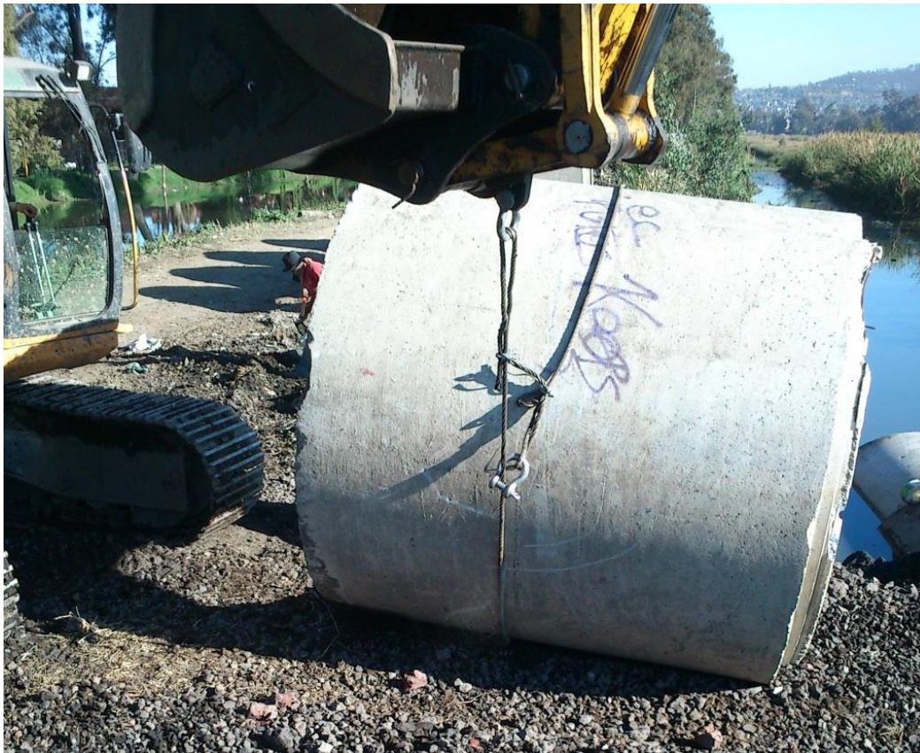
Imagen 6. Colocación de estrobo en tubería.
