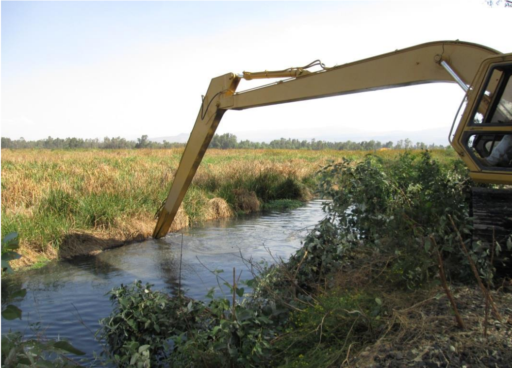
Imagen 20. Extracción de material con Retroexcavadora.
