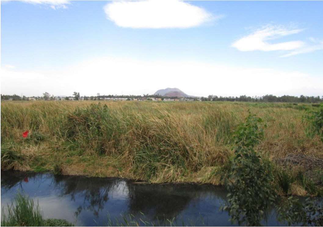
Imagen 40. Condiciones del vaso antes de realizar el desazolve
