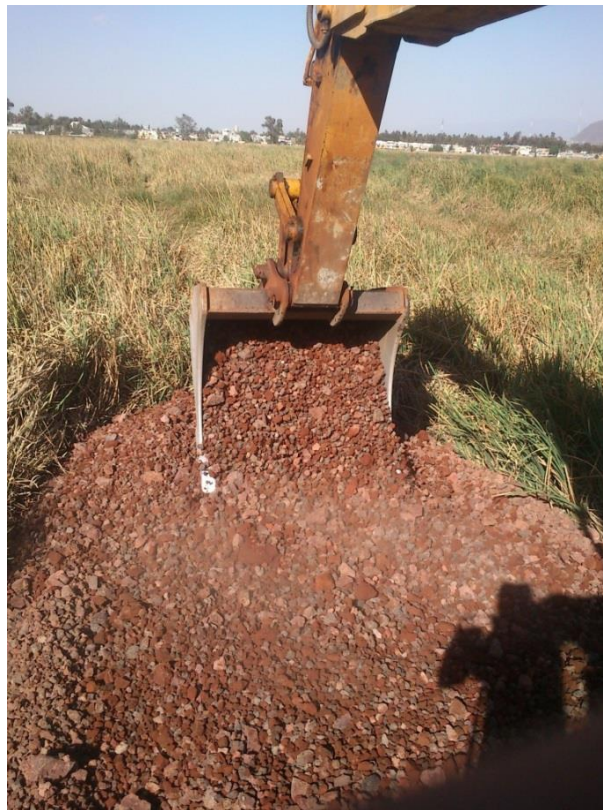
Imagen 12. Bandedo de balastro para conformación del peine
