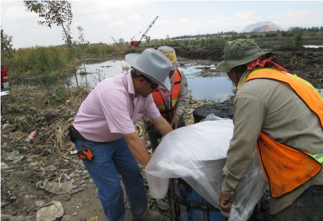
Imagen 46. Sellado de contenedores con plástico.
