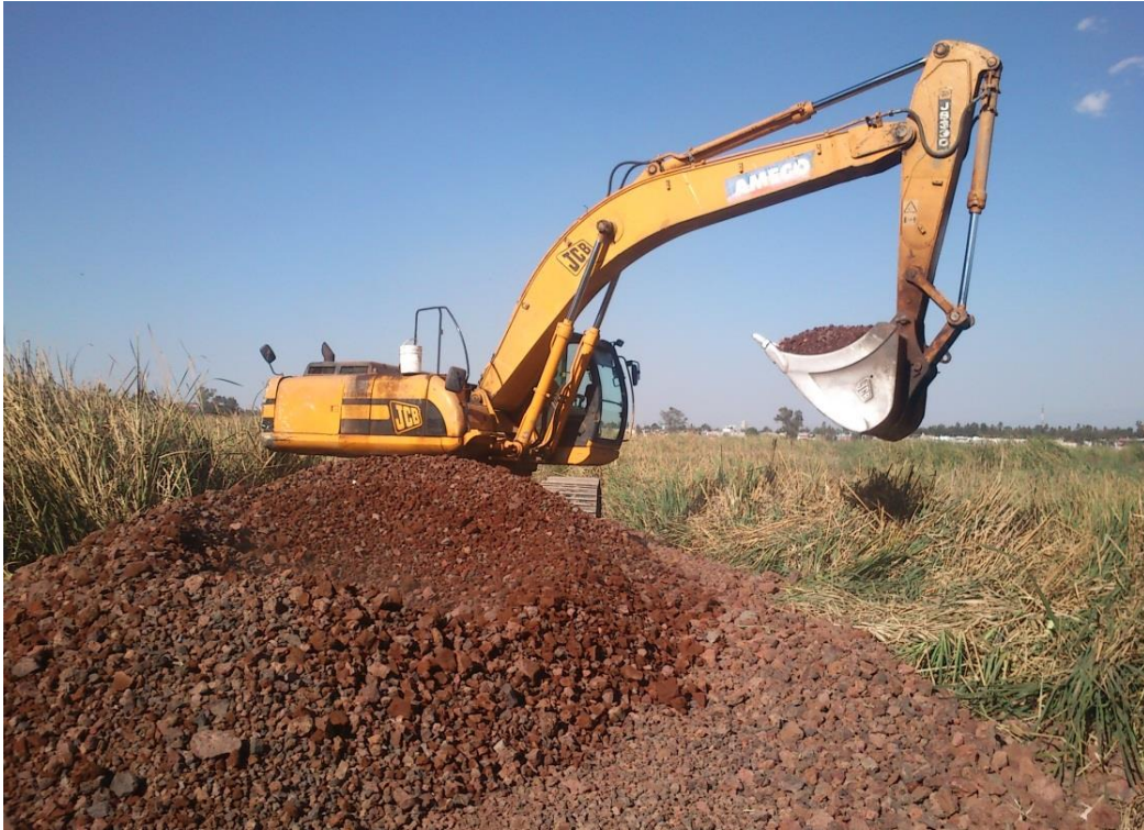
Imagen 11. Tendido de balastro.
