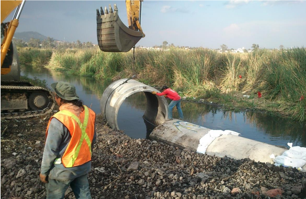
Imagen 7. Colocación de primera línea de tubería sobre canal de llamada.
