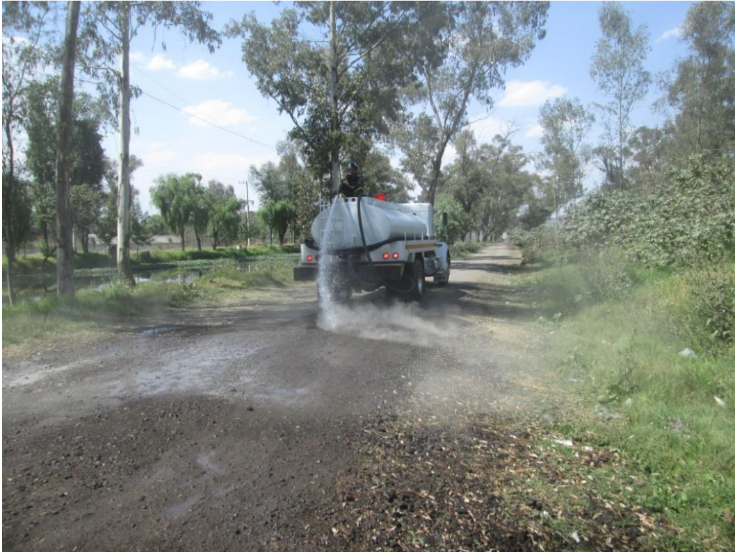
Imagen 37. Riego de agua en camino con pipa
