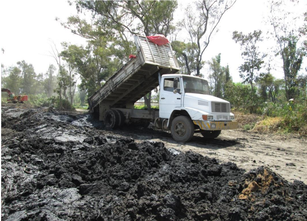
Imagen 26. Descarga de material en zona de deshidratación.
