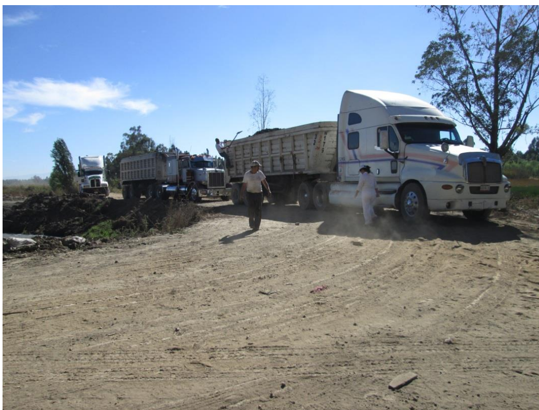
Imagen 30. Camiones a la espera de cargar en zona de deshidratación.
