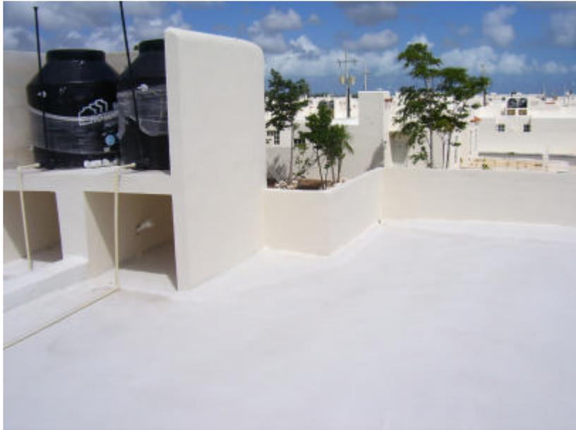
Fig. 33 Impermeabilización de la vivienda
