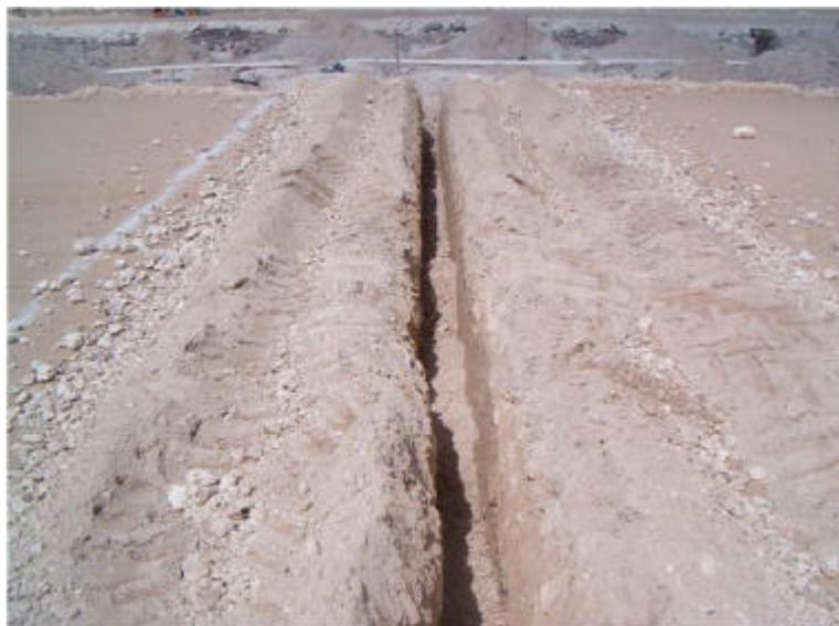
Fig. 15 Cortes para tubería sanitaria
