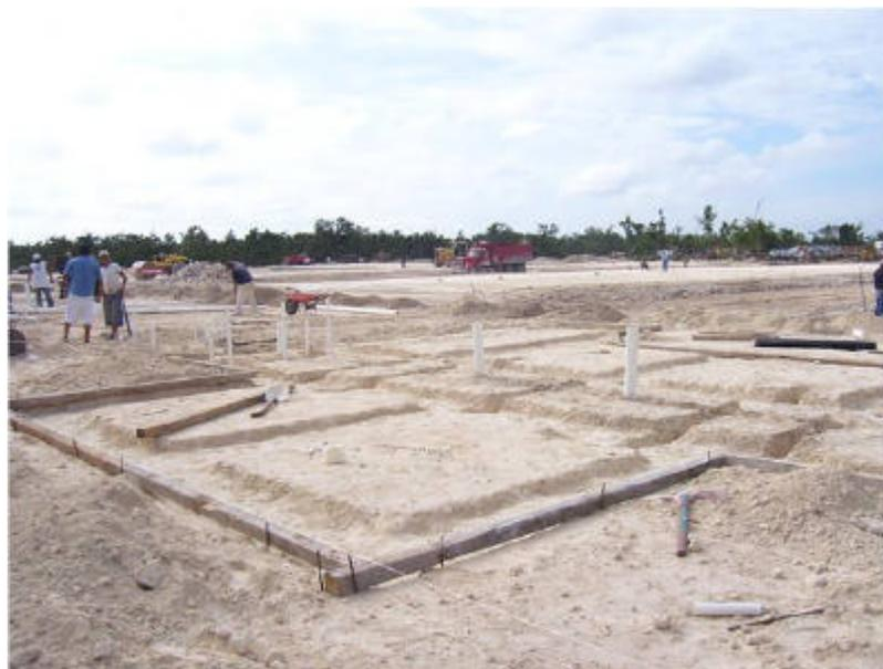
Fig. 18 Colocación de cimbra frontera
