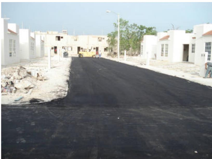
Fig. 13 Tendido de carpeta asfáltica
