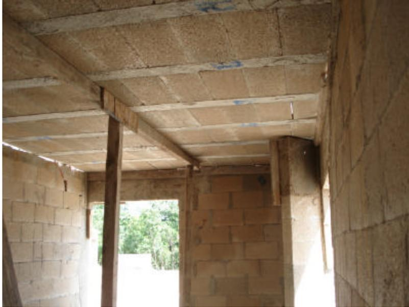
Fig. 24 Detalle de losa de vigueta y bovedilla
