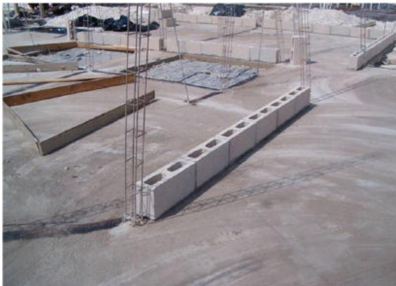
Fig. 23 Primera hilada del desplante de muros
