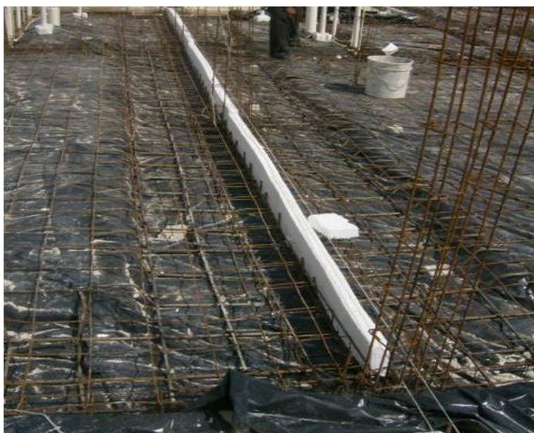
Fig. 20 Acero de refuerzo en cimentación
