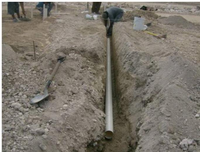
Fig.16 Colocación de tubería sanitaria
