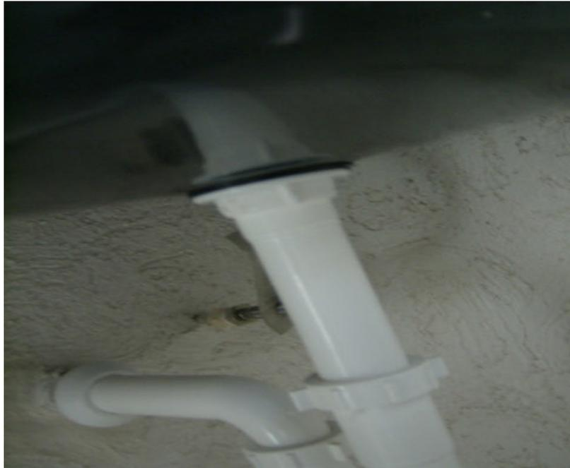
Fig. 28 Salida sanitaria de PVC de la tarja de la cocina
