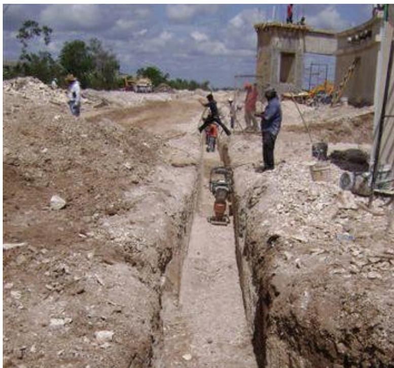
Fig. 10 Excavación de zanjas para red de agua potable
