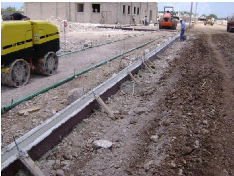
Fig. 12 Compactación de terreno para pavimentación.
