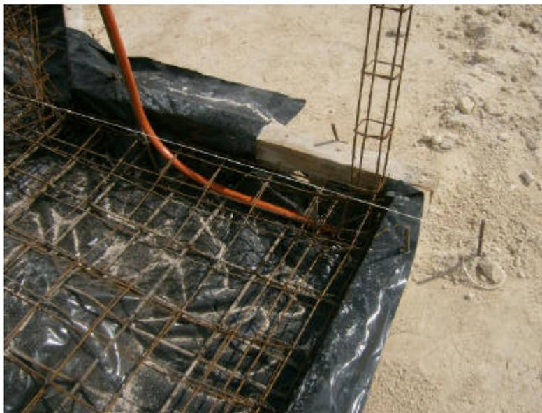
Fig. 29 Ductería de PVC en cimentación
