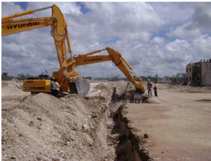
Fig. 9. Excavación de zanjas para drenaje
