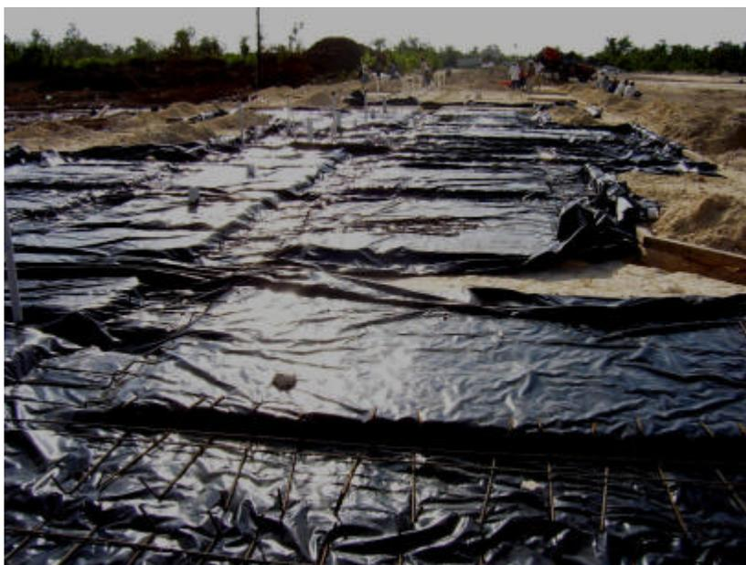
Fig. 19 Colocación de polietileno en cimentación
