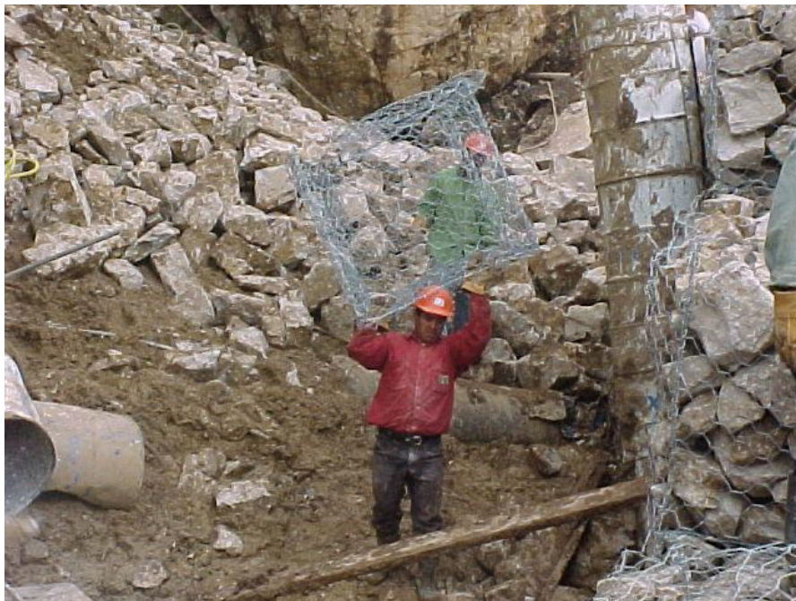
ARMADO Y COLOCACIÓN DE MUROS GAVIONES
