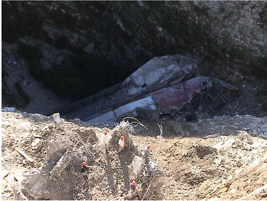
DESPUES DE LA VOLADURA, ASI QUEDÓ LA PILA, Y EN EL FONDO SE OBSERVA LA CHATARRA
