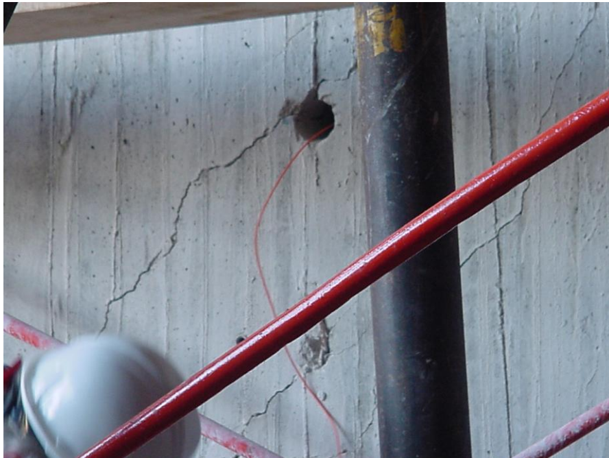
PERFORACIONES PREVIAS EN EL CUERPO DE LA PILA DAÑADA, PARA LA COLOCACIÓN DE LOS EXPLOSIVOS
