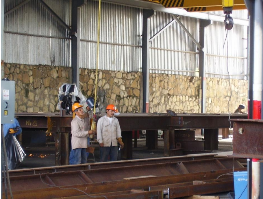
PLACAS Y GRÚA
