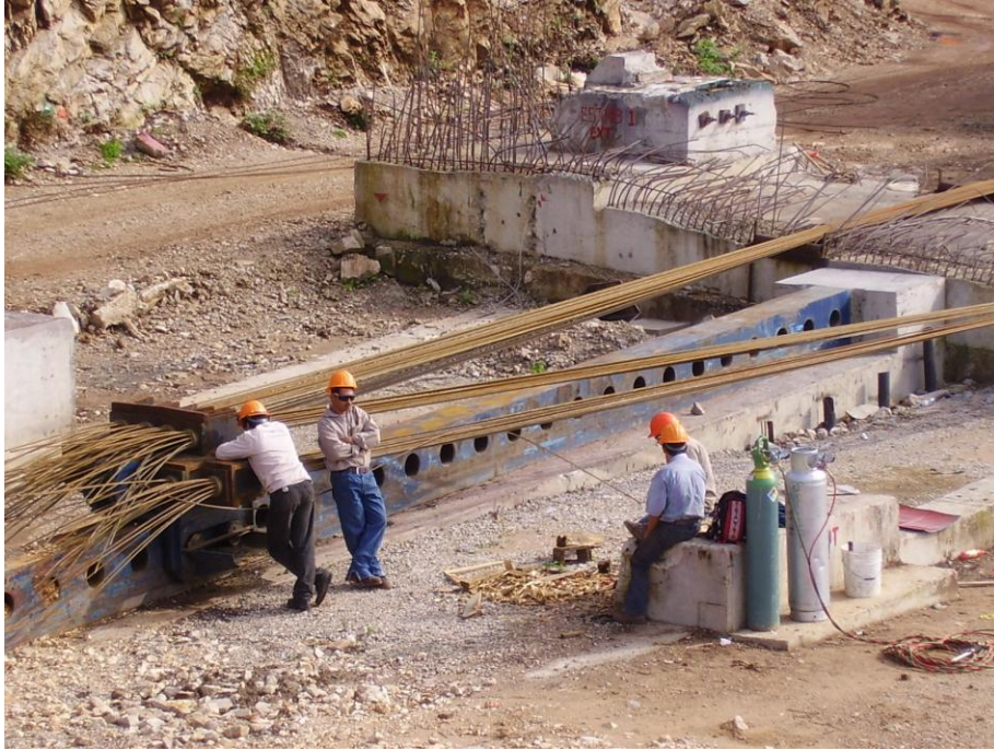
CABLES DE REFUERZO EN LOSAS
