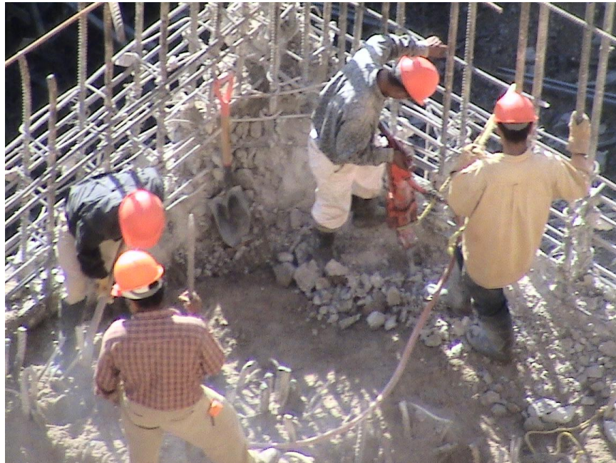
REHABILITACIÓN DE ARMADO
