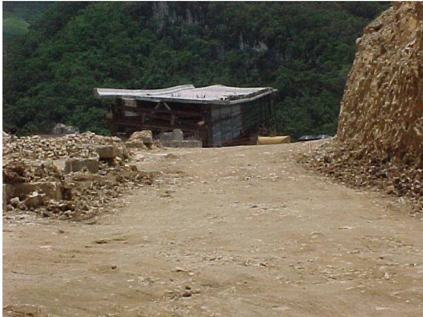
ESTRUCTURA ANTES DE DEMOLERSE
