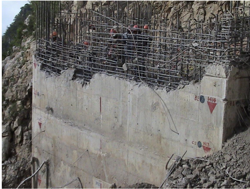
DESPUÉS DE LA VOLADURA SE RETOMÓ EL ARMADO
