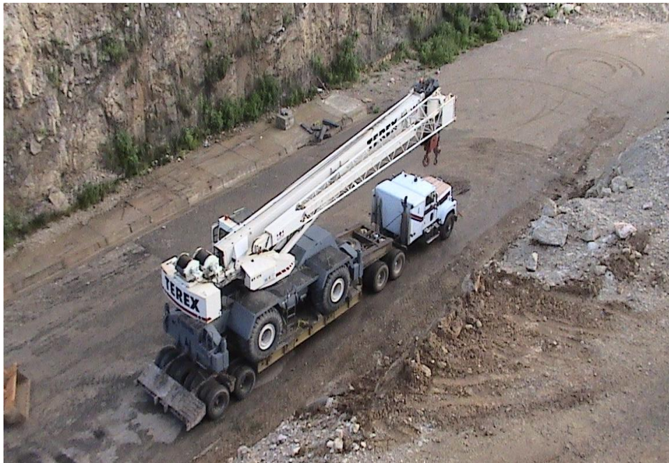
TRANSPORTE DE GRÚA, AL SITIO
