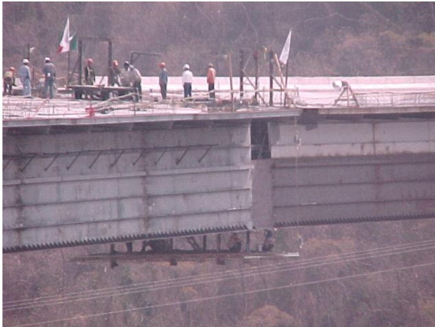
LEVANTAMIENTO PARA DIMENSIONES DE DOVELA DE CIERRE
