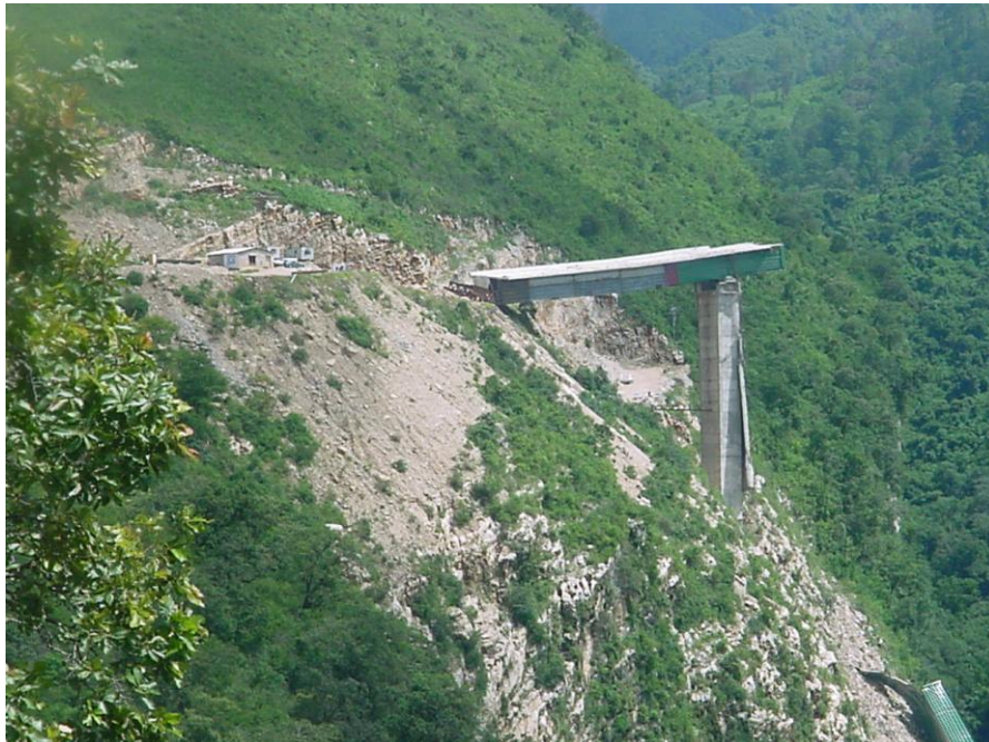
LADO TUXTLA ANTES DE LA DEMOLICION
