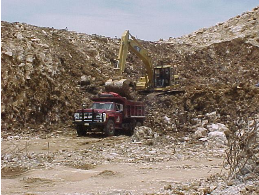
RETIRO DE MATERIAL
