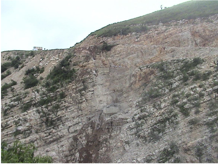
OTRA VISTA DE LA VOLADURA, SE OBSERVA LA ZAPATA
