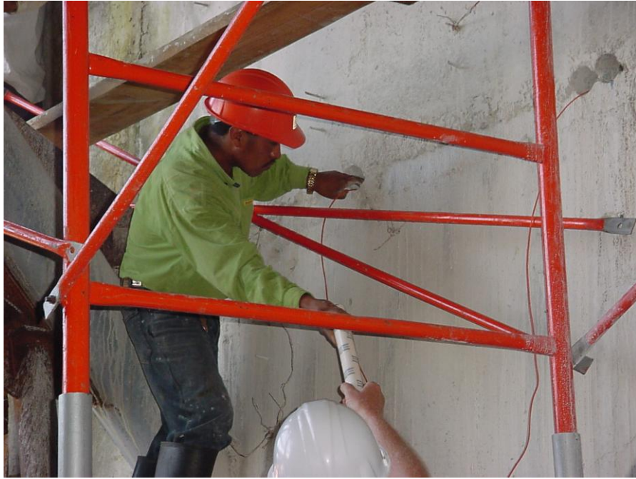
COLOCACIÓN DE LOS EXPLOSIVOS
