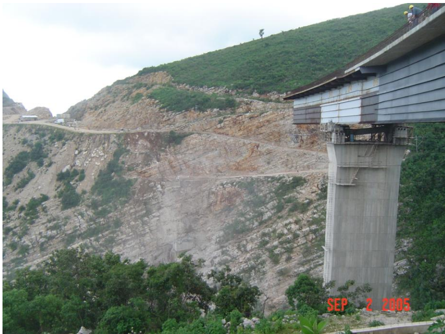
DESPUÉS DE LA DEMOLICIÓN
